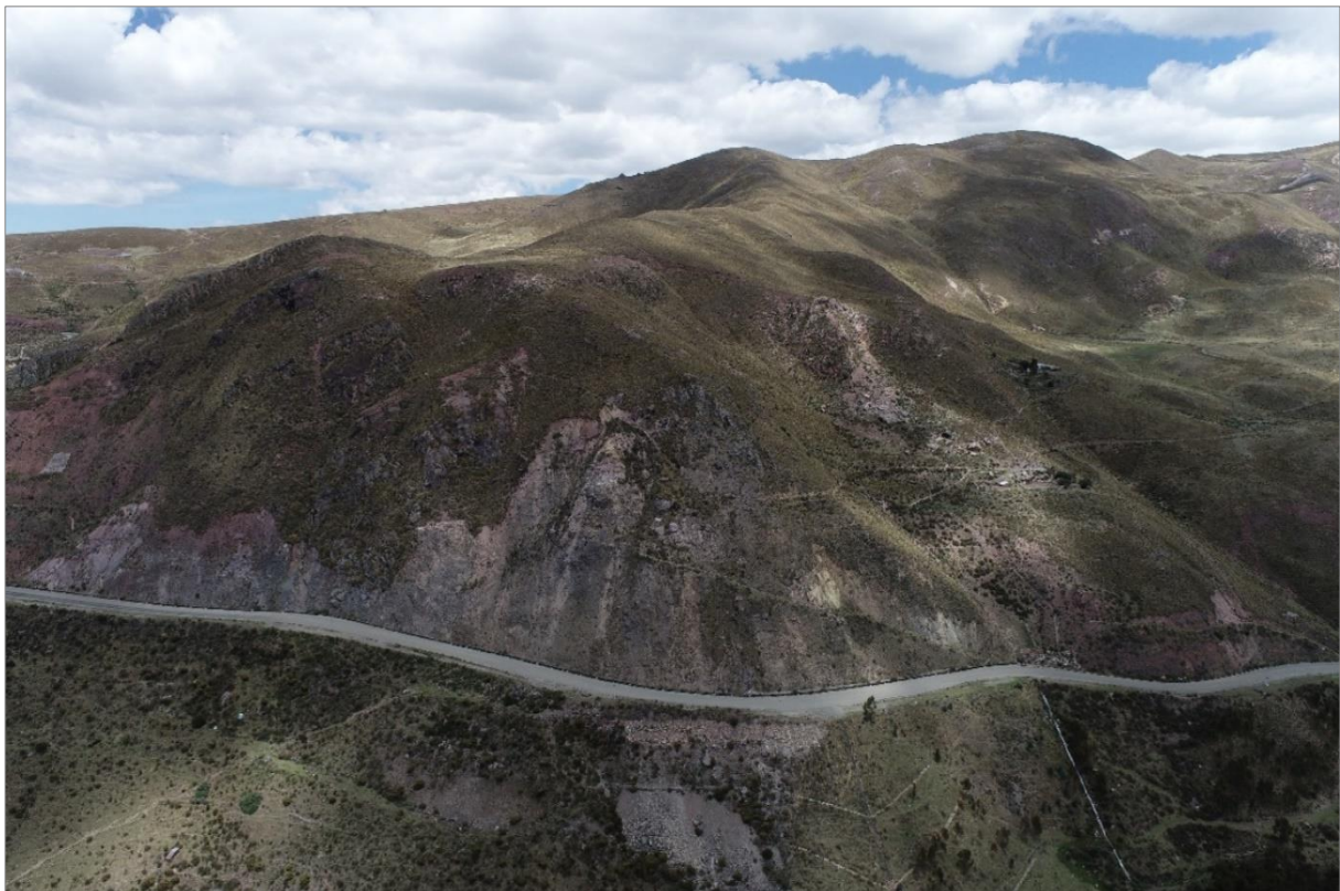
Fotografía 3. En el trazo de la carretera, km 18+000, se observa caída de rocas y derrumbes, con probabilidad de falla en cuña. Hacia el km 18+300 pasa a una morfología ondulada, con pendiente de 35°, compuesto por bloques y arenas color marrón, proveniente de un deslizamiento
