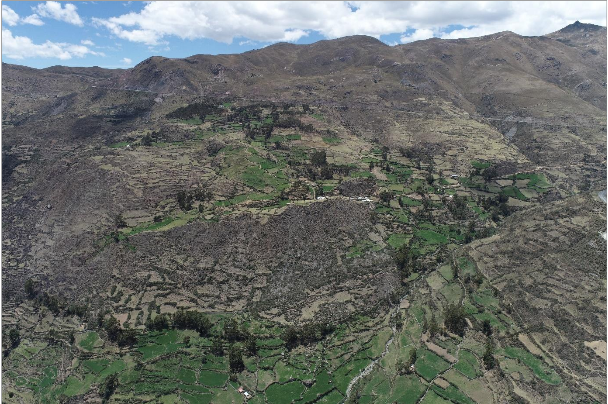
Fotografía 5. Vista del deslizamiento antiguo reactivado. Producto del corte de talud se observa derrumbes y caída de rocas en el talud verticalizado del km 18+000 al 18+640.
