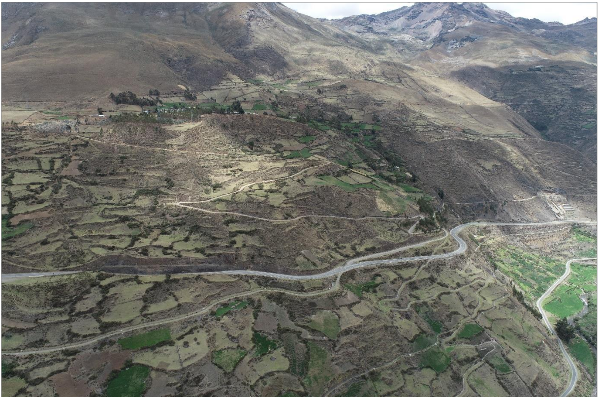
Fotografía 7. Deslizamiento antiguo reactivado, con escarpa de forma semicircular y superficie plana. Entre el km 27+740 al Km 28+100, se produjo asentamiento del terreno, con desniveles de 30 cm en dirección noreste.
