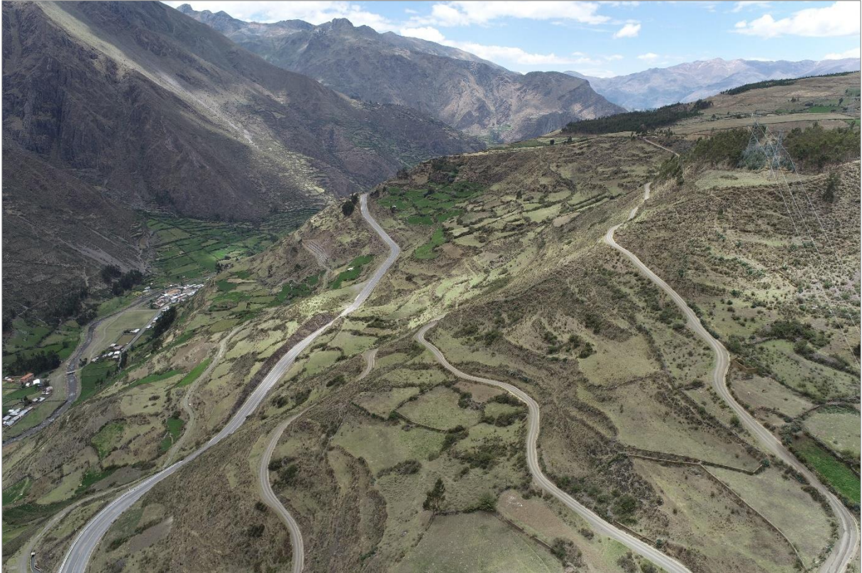
Fotografía 6. Entre el Km 26+840 al km 27+740 se evidenció un deslizamiento antiguo reactivado, con escarpa de forma semicircular y superficie ondulada debido a las reactivaciones.
