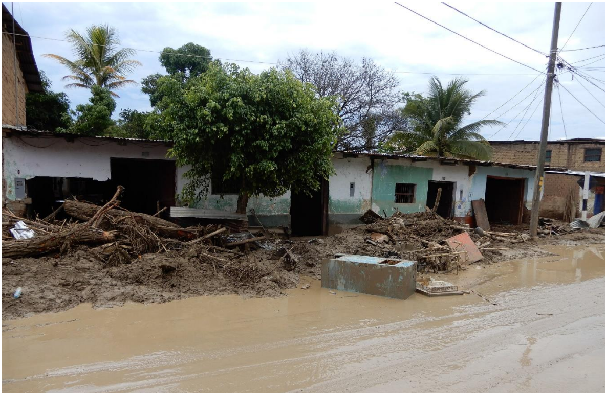
Fotografía 4. Calle afectada por la inundación en el sector de Puerto Naranjitos, ubicada en la margen izquierda del río Utcubamba.
