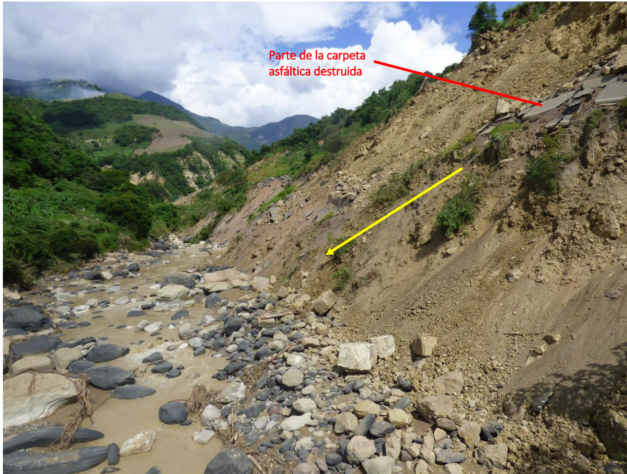
Figura 5. Se observa el pie del deslizamiento, cuyo avance modificó el cauce del río Utcubamba, haciéndolo migrar hacia la margen derecha, reduciendo su cauce. Con línea amarilla, se muestra la dirección del empuje del terreno y en rojo parte de la carpeta asfáltica de la carretera Fernando Belaunde totalmente destruida.
