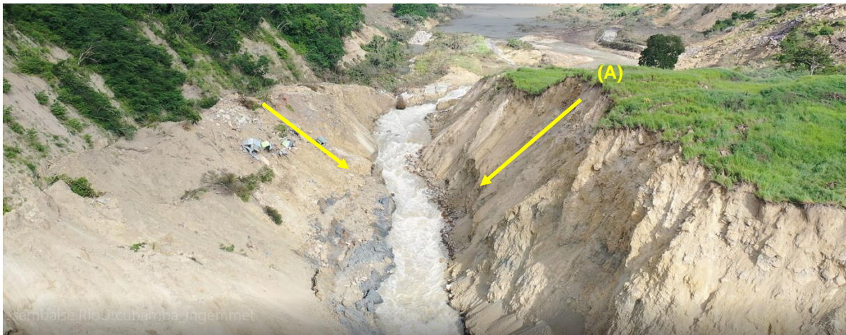
Figura 13. Dique de represamiento erosionado, después de la ruptura del dique. Se muestran taludes erosionados en forma de "V". Se nota la cabecera del derrumbe de la figura anterior (A).
