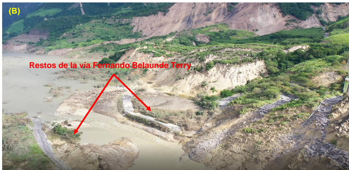
Figura 17. Se aprecia el material desplazado por el deslizamiento.
