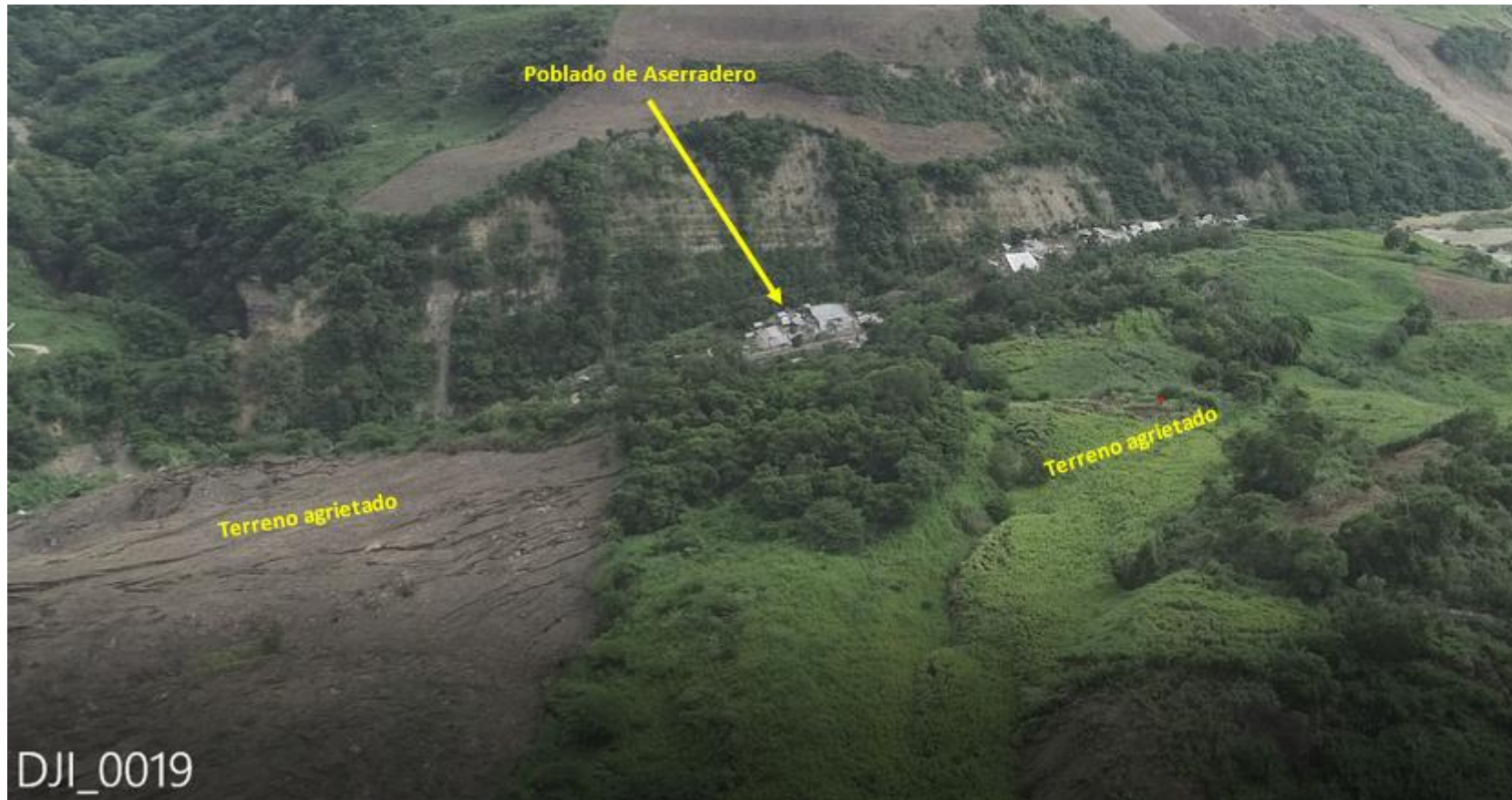
Figura 3. La presencia de agrietamientos en el terreno, indican su inestabilidad, hacia el fondo se observan las viviendas destruidas del poblado Aserradero, que fueron arrastradas hacia la margen derecha del río (zona del dique). Fuente: Fotografía extraída de un video proporcionado por la Fuerza Aérea del Perú.
