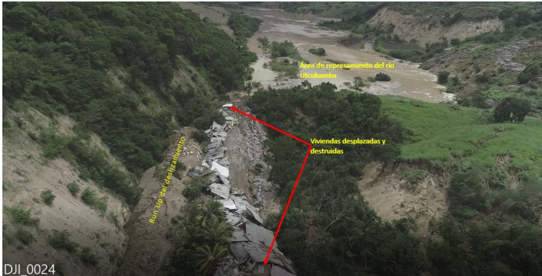
Figura 8. Se muestra el Run Up originado por el movimiento del deslizamiento, sobre éste se muestran las viviendas destruidas. Fuente: Fotografía extraída de un video proporcionado por la Fuerza Aérea del Perú.
