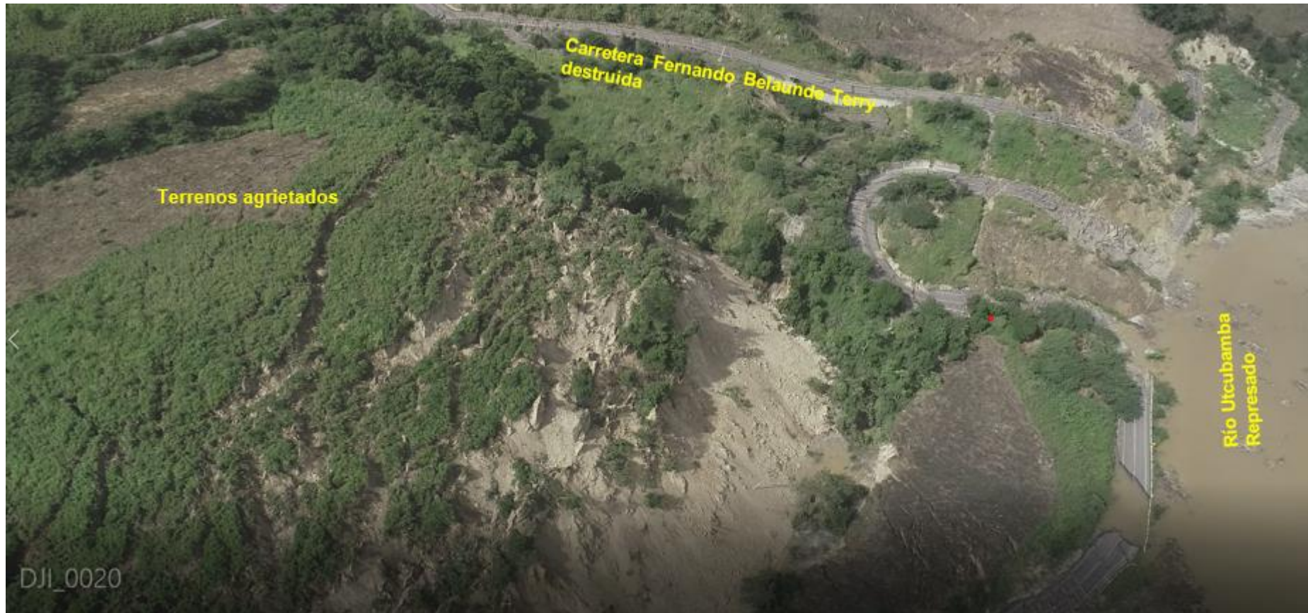
Figura 9. Se observa parte de la carretera Fernando Belaunde Terry destruida y con agrietamientos, terrenos de cultivo desplazados y parte de la laguna formada por el represamiento en el río Utcubamba. Fuente: Fotografía extraída de un video proporcionado por la Fuerza Aérea del Perú.
