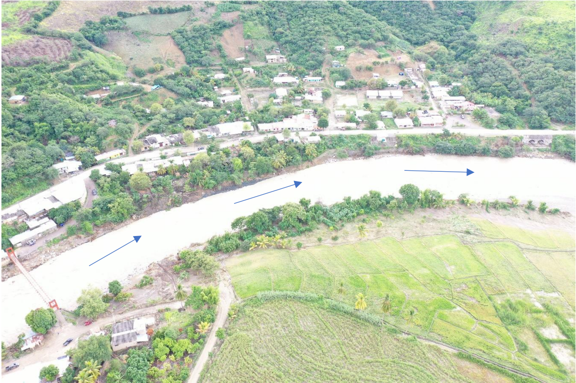
Figura 18. Vista panorámica del caserío El Salao, en la margen derecha se observan las viviendas y terrenos de cultivo afectados por la inundación por el desembalse. También, se observan viviendas susceptibles a ser afectadas por la erosión fluvial.
