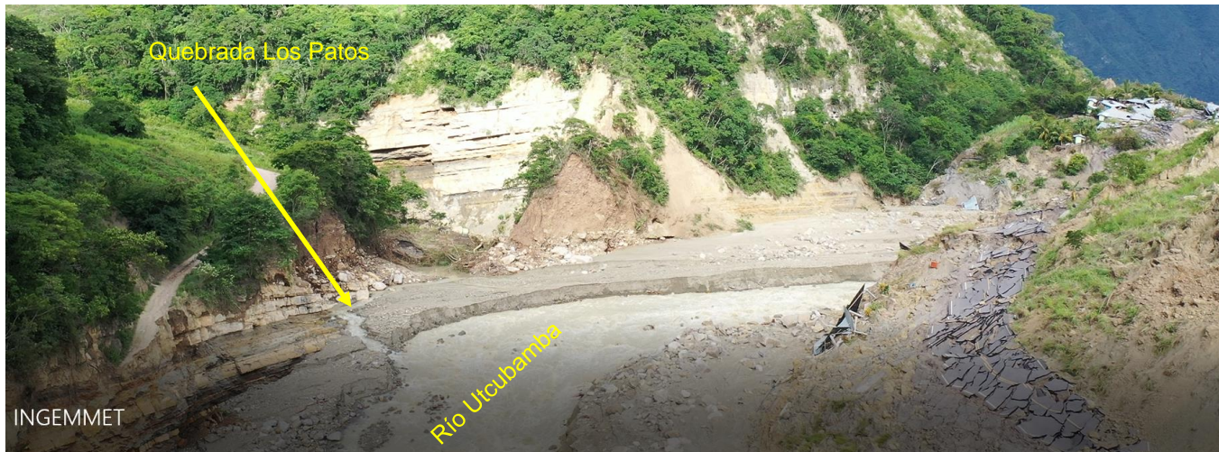
Figura 15. Amplio cauce del río Utcubamba por la margen derecha. La línea amarilla señala la dirección del desfogue de la quebrada Los Patos. Fuente: Fotografía extraída de un video proporcionado por la Fuerza Aérea del Perú.
