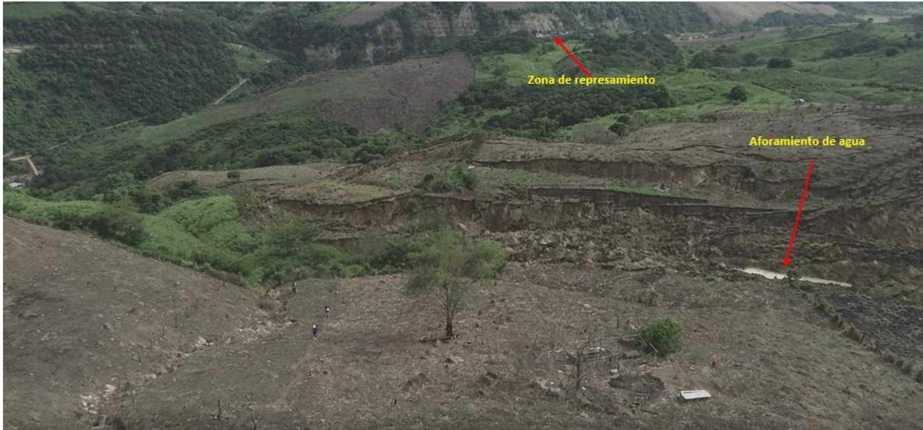
Figura 4. Se observa la zona de represamiento del río del Utcubamba y afloramientos de agua (puquiales) en el cuerpo del deslizamiento, éstos últimos deben ser evacuados. Fuente: Fotografía extraída de un video proporcionado por la Fuerza Aérea del Perú.
