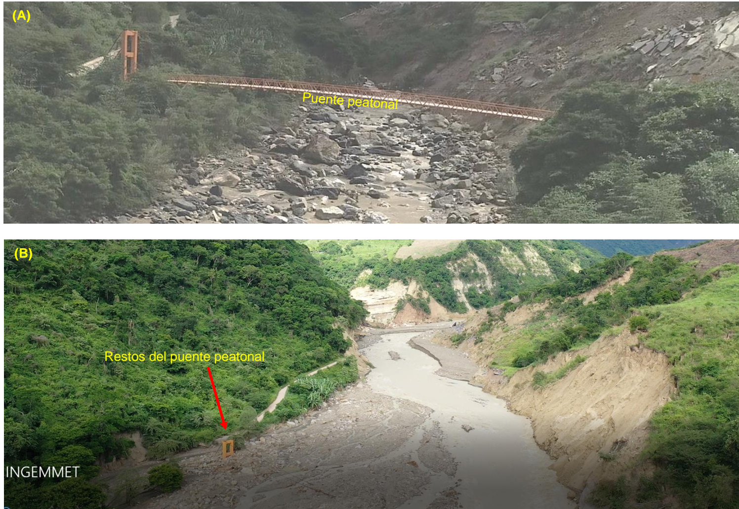
Figura 16: (A) Se muestra el puente antes del embalse (Fuente: Fotografía extraída de un video proporcionado por la Fuerza Aérea del Perú); (B) se observa el puente totalmente cubierto por sedimentos, después de la ruptura del dique.
