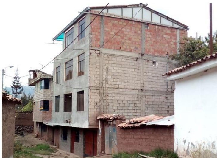
Fotografía: Edificación de 4 niveles ubicado en el lote 02 - Mz C – APV. “Agua Dulce”. Fuente: Equipo Técnico PM41ZRE.
