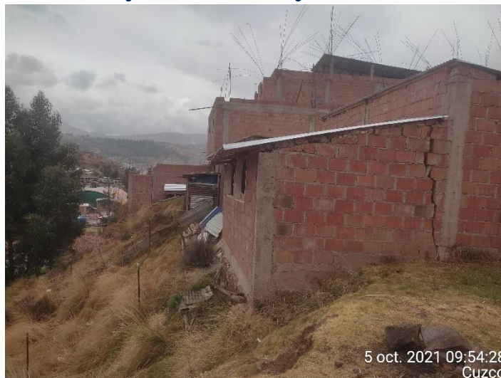
Imagen N° 15: Ladera en la margen derecha del río
