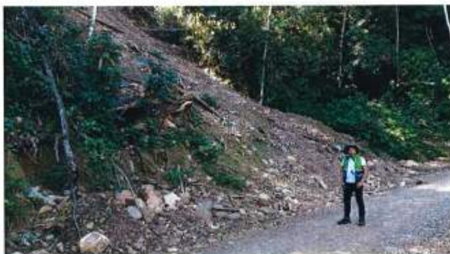
Fuente: Equipo Técnico PPRD-KOSÑIPATA
