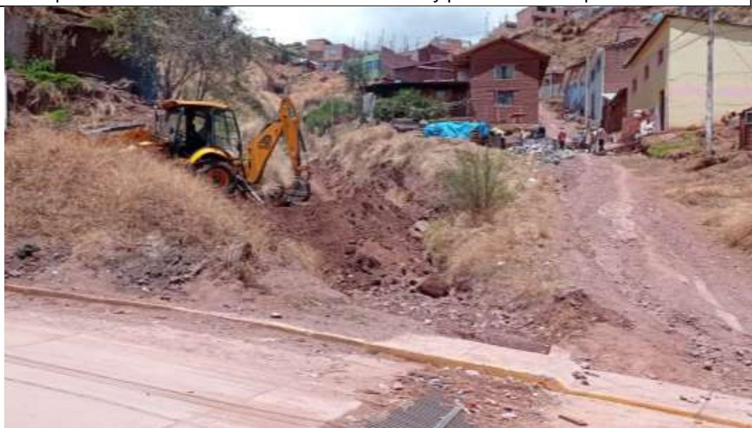
Fotografía 08: Quebrada Ranachayoc. Vista hacia el Sur y aguas arriba, se nota la acumulación de material de colmata el cauce y obstruye el alcantarillado transversal en la vía
