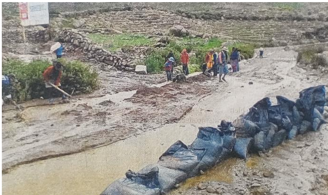
En Mirave la población se vio obligada a proteger sus campos y viviendas con sacos de arena (Diario Sin Fronteras. 09/02/2019)
