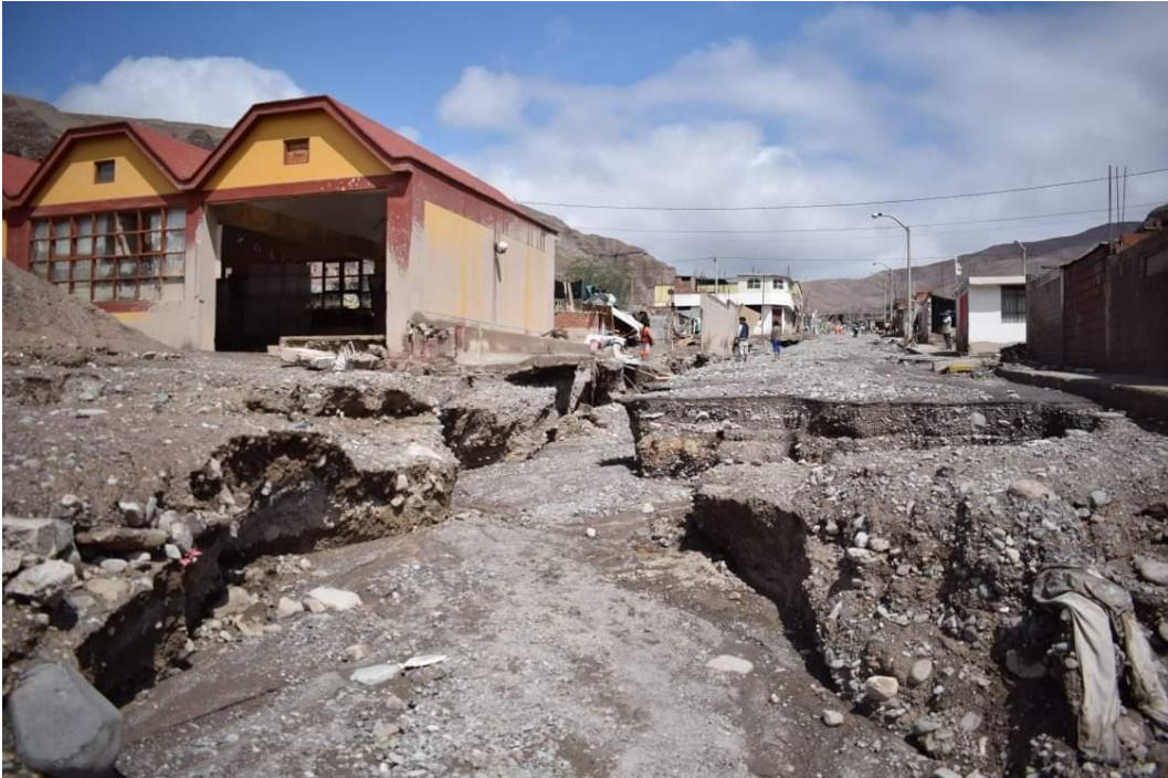
Figura 17: Cubierta de lodo y rocas, así quedo el centro poblado de Mirave, tras el huayco que cayó el pasado viernes (Agencia Andina de Noticias 10/02/2019)
