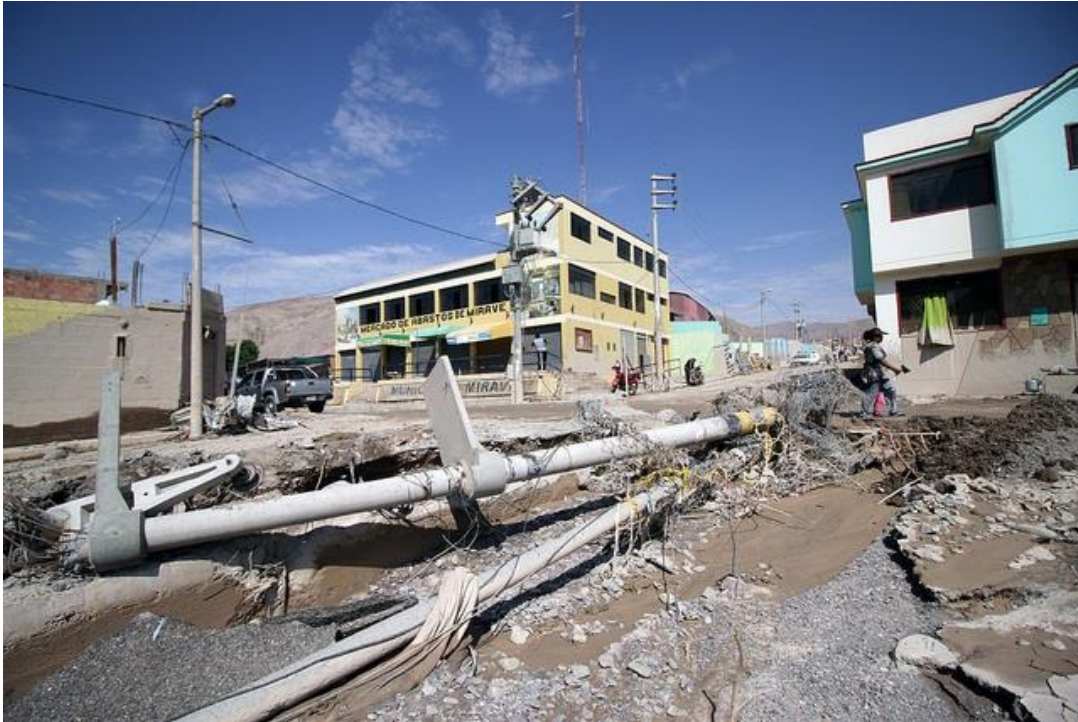
El huayco derribó postes de alumbrado público, dejando sin energía eléctrica a Mirave (Diario Correo. 15/02/2019)
