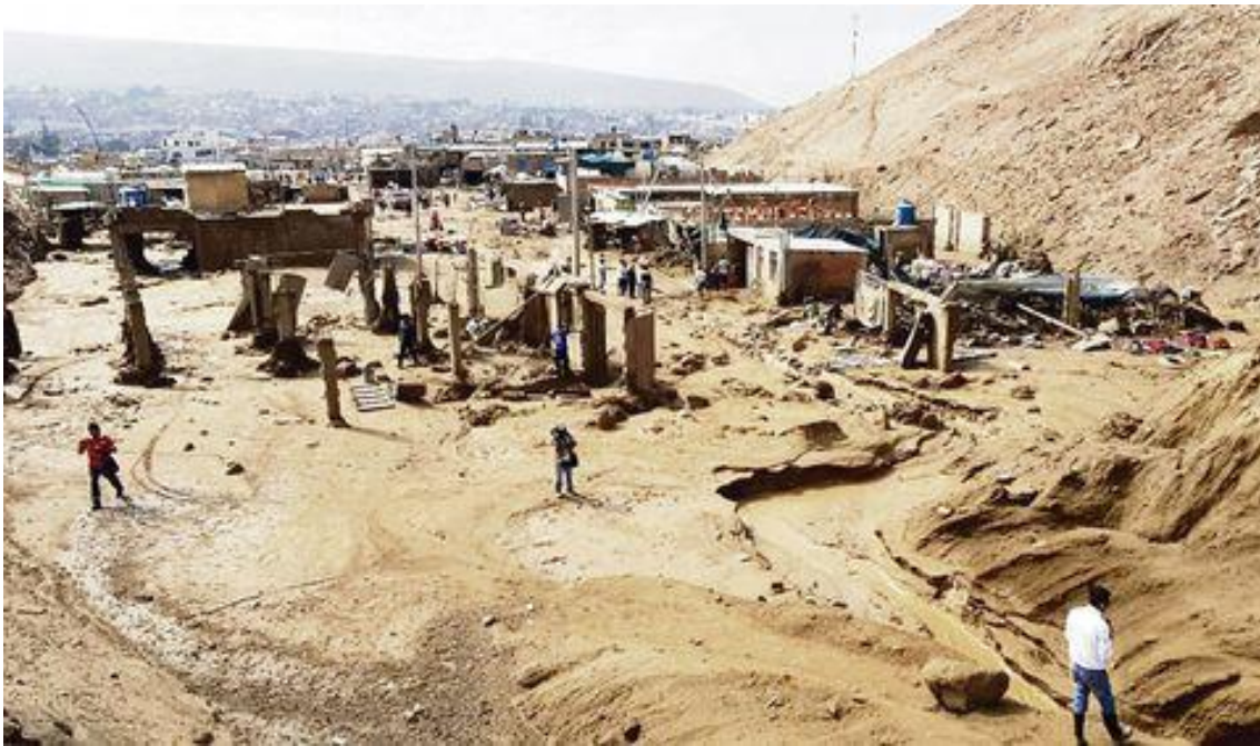
Figura 19: Viviendas construidas sobre el cono aluvial afectadas por la activación de la quebrada del Diablo, (Diario La República. 23/02/2020)
