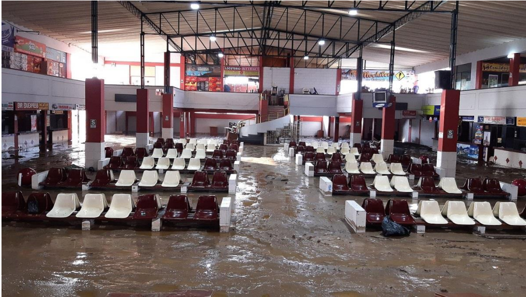
Figura 21: Terrapuerto de Tacna inundado por la activación de la quebrada El Diablo (Diario Gestión. 24/02/2020)
