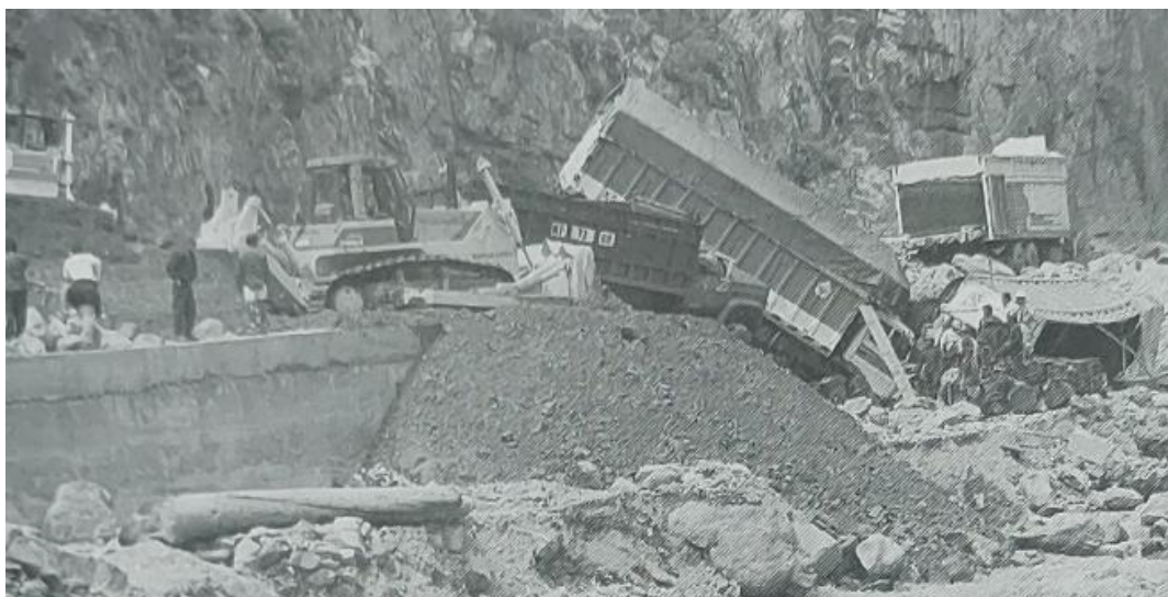
Figura 11.- Vías interrumpidas por los constantes huaycos en la sierra alta de Tacna que ponían en riesgo el transporte de alimentos (Diario El Sol. 02/02/1998)
