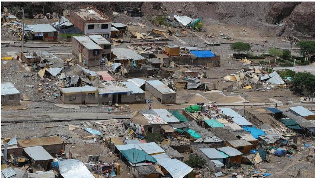
Figura 18: Cuatrocientas cincuenta viviendas fueron afectadas por el huaico. (El Comercio. 10/02/2019)
