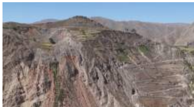
Figura 9: Ladera de alta pendiente con corte de carretera y actividad agrícola, en la zona de Huanca
