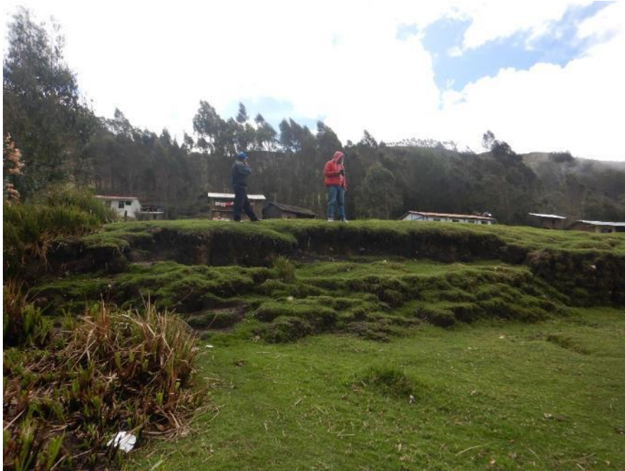
Fotografía 9. Reptación de suelos con presencia de agrietamientos en el terreno de hasta 1.5 m de altura, identificado en el centro poblado Chagavara.
