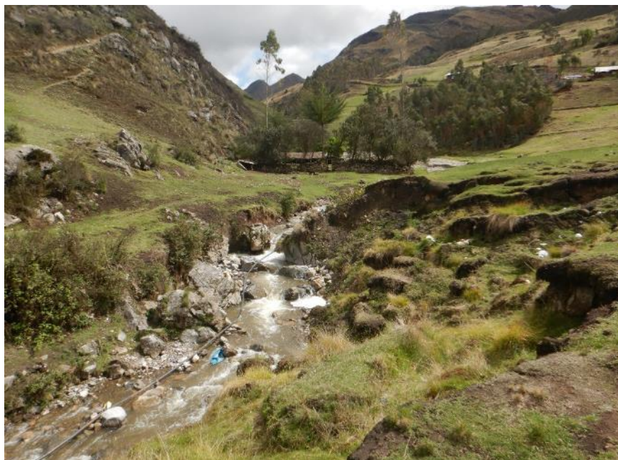
Fotografía 10. Asentamientos del terreno en la margen izquierda de la quebrada Chagavara.
