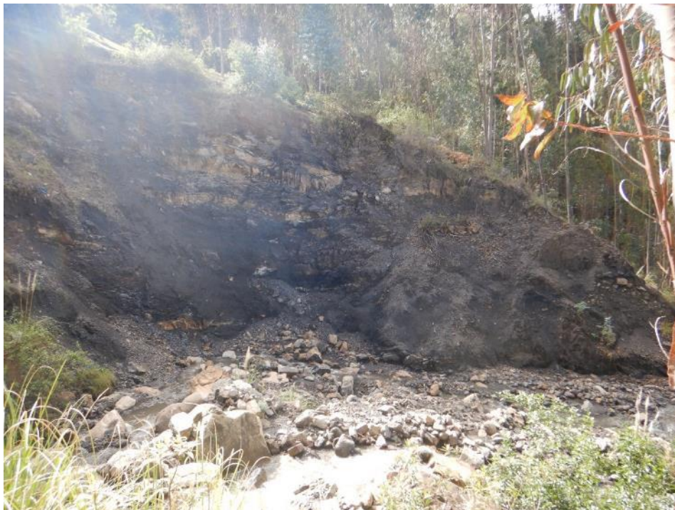
Fotografía 2. Substrato rocoso base en el centro poblado Pijobamba, conformado por intercalaciones de lutitas y areniscas finas, medianamente a muy fracturadas y moderadamente a altamente meteorizadas.
