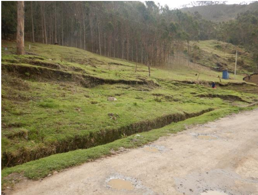
Fotografía 11. Canales de drenaje sin revestimiento que genera infiltración hacia el subsuelo y afectación en viviendas próximas a estos canales. También se pueden observar procesos de reptación de suelos.
