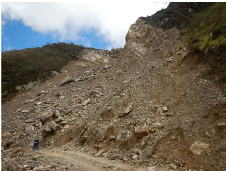
Fotografía 8. Vista de la zona de arranque del evento derrumbe-flujo en el sector de Chillín el cual afectó la vía de comunicación que une las ciudades de Sitabamba y Huamachuco. Coordenadas UTM WGS84: 197217E; 9113789N.
