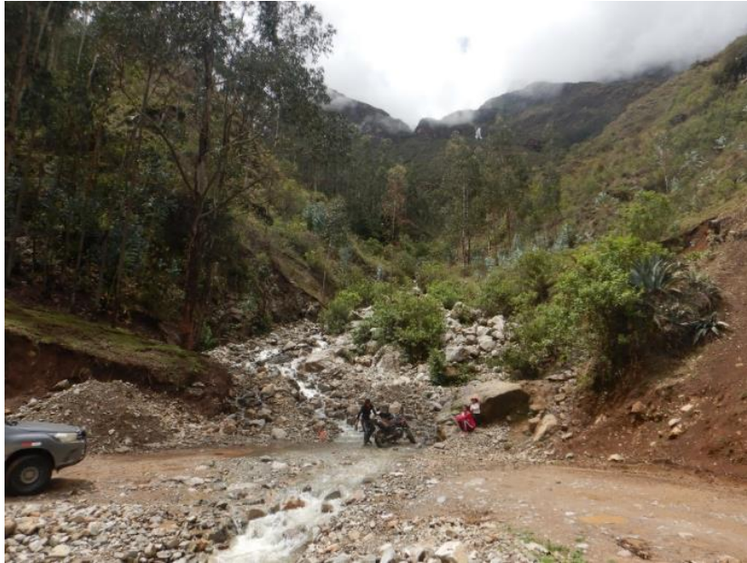
Fotografía 5. Flujos de detritos (huaicos) en la quebrada Ticapampa que afectan la vía de acceso al centro poblado de Sitabamba (Coordenadas UTM WGS84: 202353E; 9113427 N).
