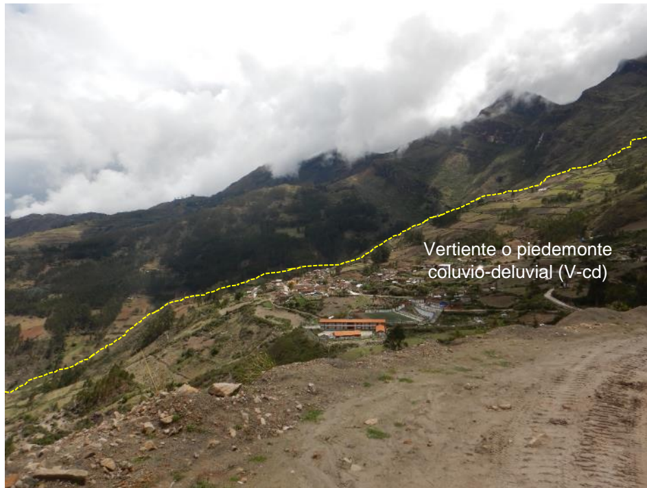
Figura 5. Subunidad de vertiente o piedemonte coluvio-deluvial (V-cd) conformada por depósitos de deslizamientos antiguos. Sobre esta geoforma se asienta el centro poblado de Sitabamba.
