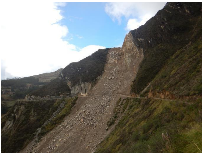
Fotografía 7. Derrumbe-flujo en el sector de Chillín que afectó 200 m de la carretera Sitabamba-Huamachuco. Se puede observar la fuerte pendiente del terreno. Coordenadas UTM WGS84: 197217E; 9113789N.
