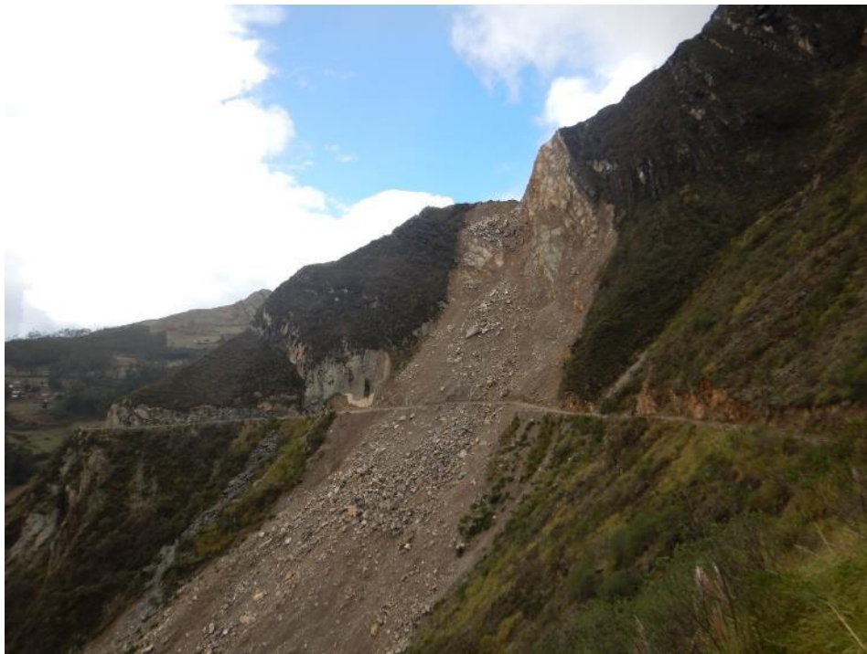
Fotografía 4. Depósitos coluviales identificados en el sector Chillín que corresponden a movimientos complejos que afectaron la vía de acceso al distrito de Sitabamba.
