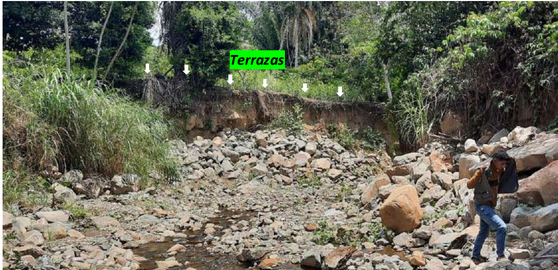
Fotografía 4: Vista de depósitos aluviales formando terrazas en el flanco derecho del río Cusco Mayo.
