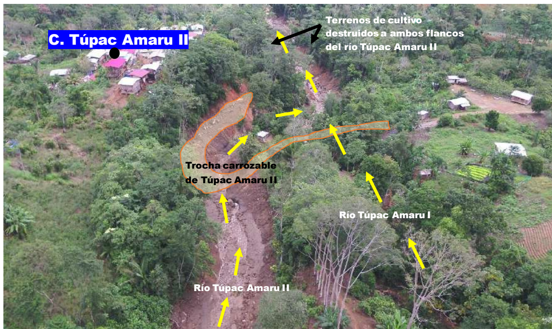
Fotografía 15. Vista aérea trasera de la trocha carrozable de Túpac Amaru II destruida debido al crecimiento del rio del mismo nombre, las flechas amarillas muestran la dirección del flujo. Fuente: INDECI-PICHARI
