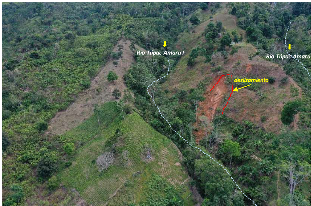
Fotografía 8: Vista de depósito coluvial que adoptan formas semicónicas a ambos flancos de los ríos Túpac Amaru I y II. Además, se observa la presencia de deslizamiento de detritos sobre la geofoma de vertiente coluvial
