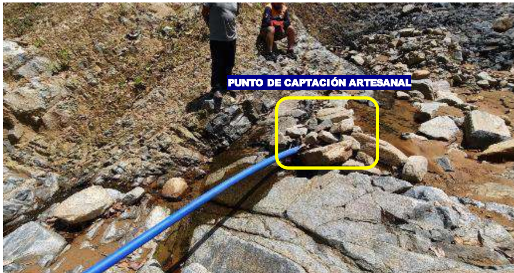
Fotografía 18. Captación artesanal con manguera en la parte alta del río Túpac Amaru II.
