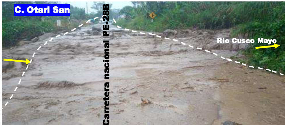
Fotografía 23: Vista del flujo de detritos que sobrepasó el puente Cusco Maro, en el flanco izquierdo se ubica la comunidad de Otari San Martín. El flujo amplió su cauce y se desbordó sobre la carretera nacional PE-28B. Fuente: INDECI_PICHARI 2021
