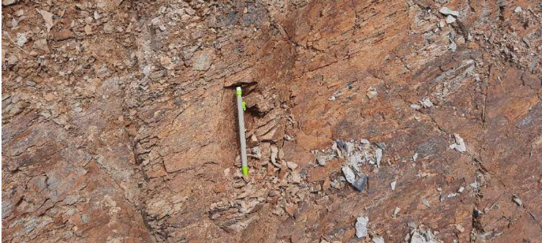
Fotografía 3: Pizarras fuertemente fracturadas con patinas de Fe por oxidación en el flanco derecho del río Túpac Amaru II.
