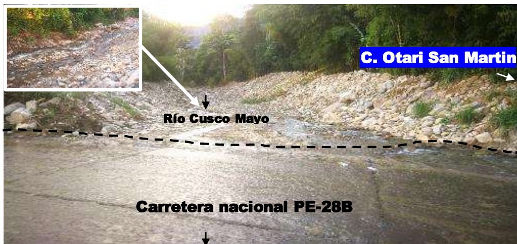
Fotografía 24: Descolmatación y limpieza del cauce del río Cusco Mayo a la altura de la comunidad de Otari San Martín, en abril de 2021. Fuente: INDECI_PICHARI 2021 Los detritos y rocas
