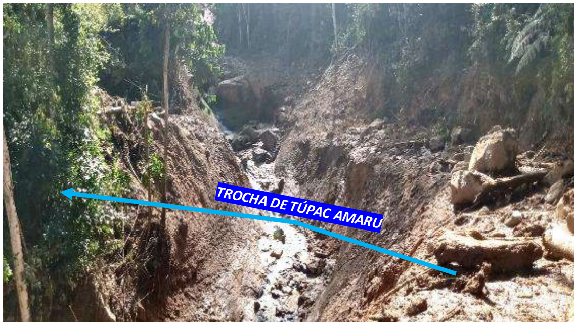
Fotografía 13. Plataforma Túpac Amaru colapsada debido al crecimiento del rio Túpac Amaru II de la comunidad con el mismo nombre. Fuente: INDECI-PICHARI
