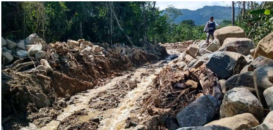
Fotografía 26: Descolmatación y protección con rocas (material detrítico del flujo) a ambos flancos del río Santa Fe. Fuente: INDECI_PICHARI 2021
