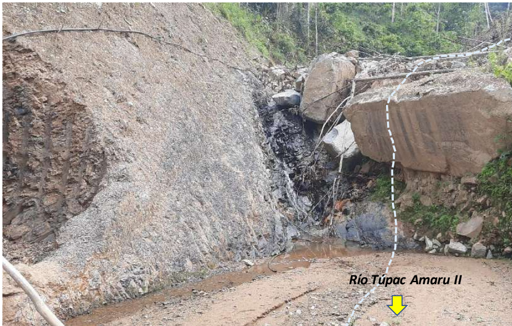
Fotografía 2: Pizarras en capas delgadas con laminación paralela, altamente fracturada en el flanco derecho del río Túpac Amaru II. Coordenadas UTM WGS84: 626512 Este; 8622503 Norte
