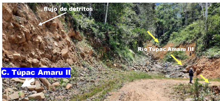
Fotografía 21. Vista del material detrítico que arrastró el flujo a lo largo del río Túpac Amaru III
