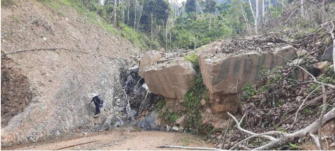
Fotografía 10. Bloques de 2 a 3 m de diámetros sobre el cauce del río Túpac Amaru II, corresponde a material arrastrado en flujos de hace 1 década atrás.
