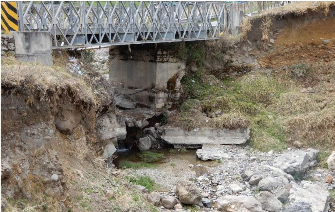
**Fotografía 5.** Erosión fluvial en la margen izquierda del río Saphill, lo que provocó la afectación de los pilares del puente Astobamba.
