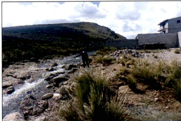
Fotografía 3: Quebrada Seca, construccion de casa en las riberas, crianza de porcinos, posible desborde.
