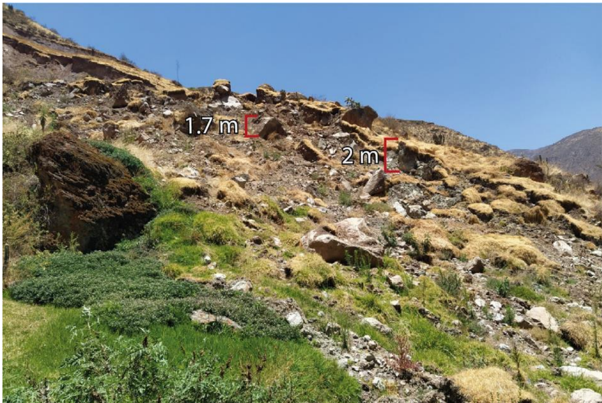
Figura 20. Bloques acumulados en el pie del deslizamiento.
