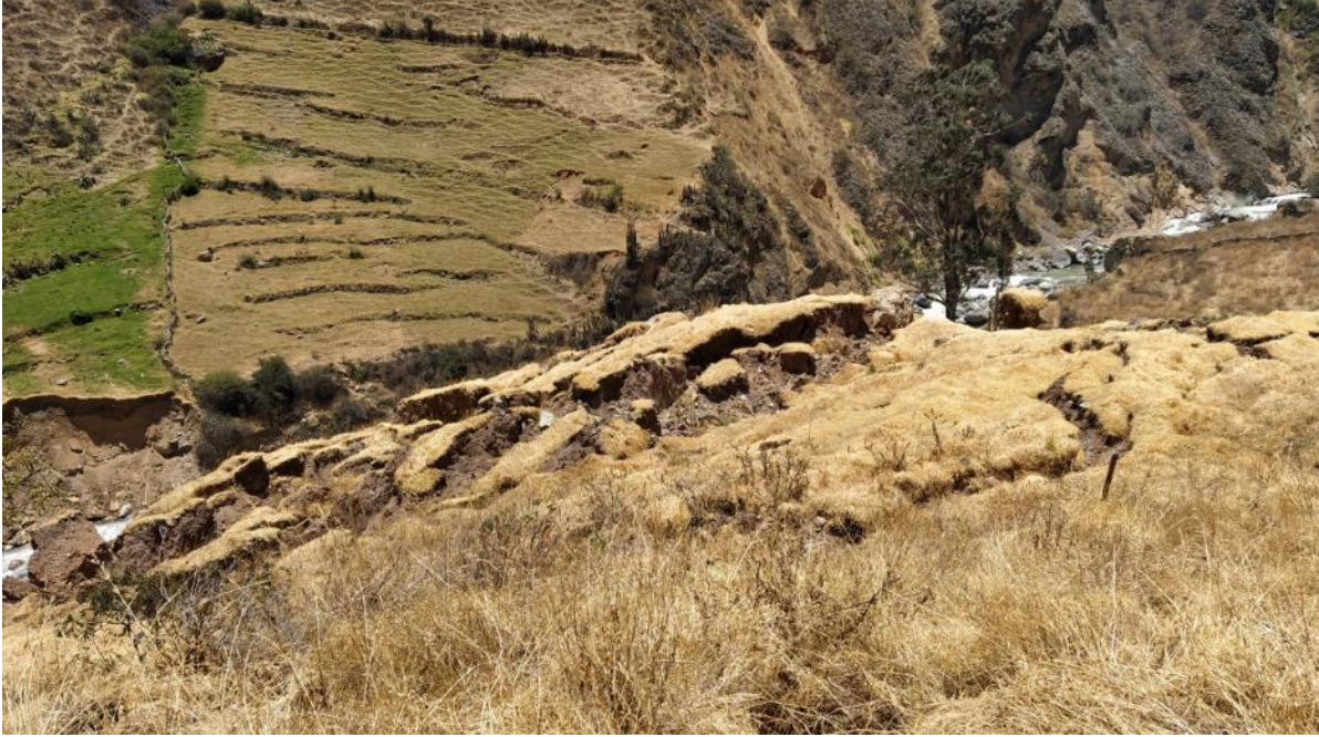
Fotografía 1. Basculamiento en la parte terminal del deslizamiento y grietas tensionales.
