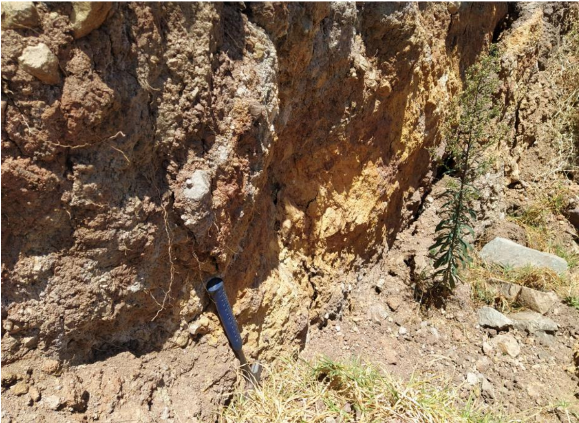
Fotografía 2. Brechas volcánicas altamente meteorizadas, se observan entre las grietas del deslizamiento.
