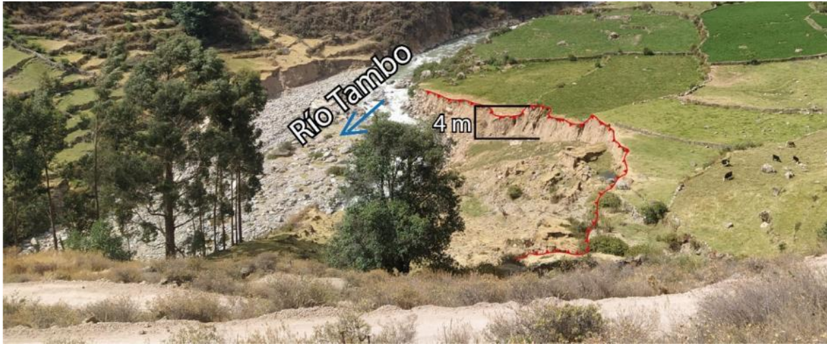
Figura 28. Deslizamiento rotacional reciente en la margen izquierda del río Tambo (Coordenadas UTM, WGS 84, 18s; X: 471011, Y: 8486588).
