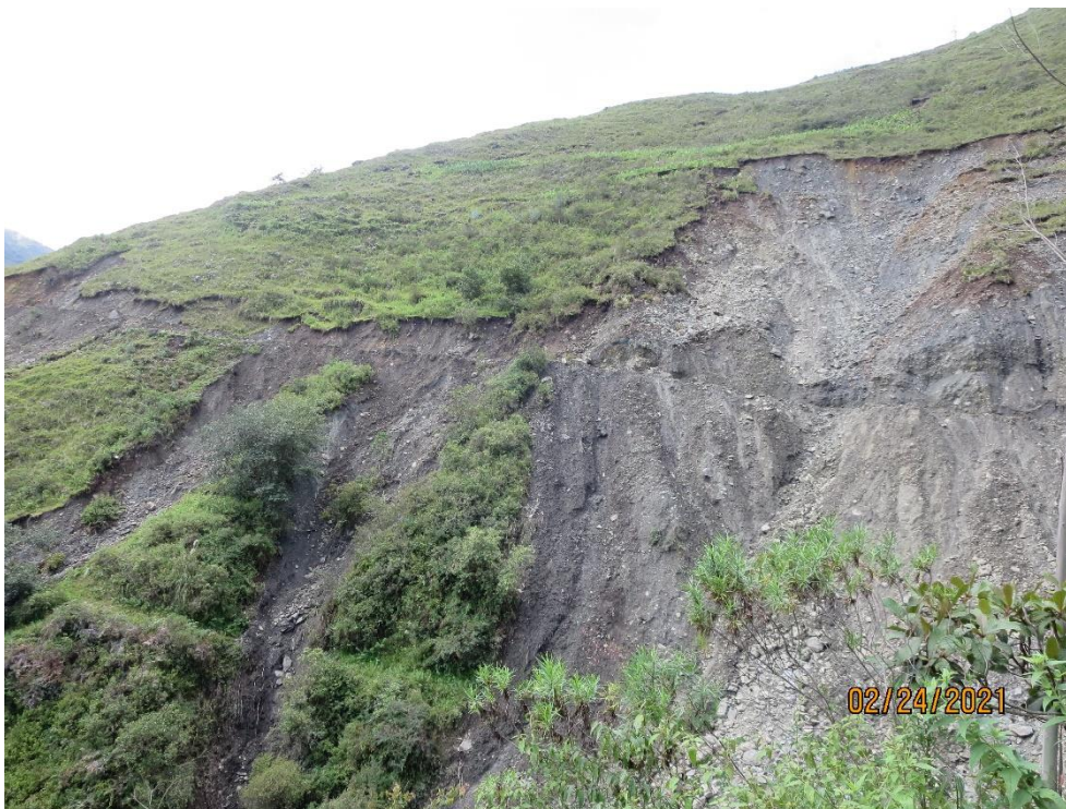
Fotografía 1. Depósito coluvial, fotografía tomada con vista hacia el escarpe del derrumbe, ubicado en el sector flanco este del cerro Moronti.
