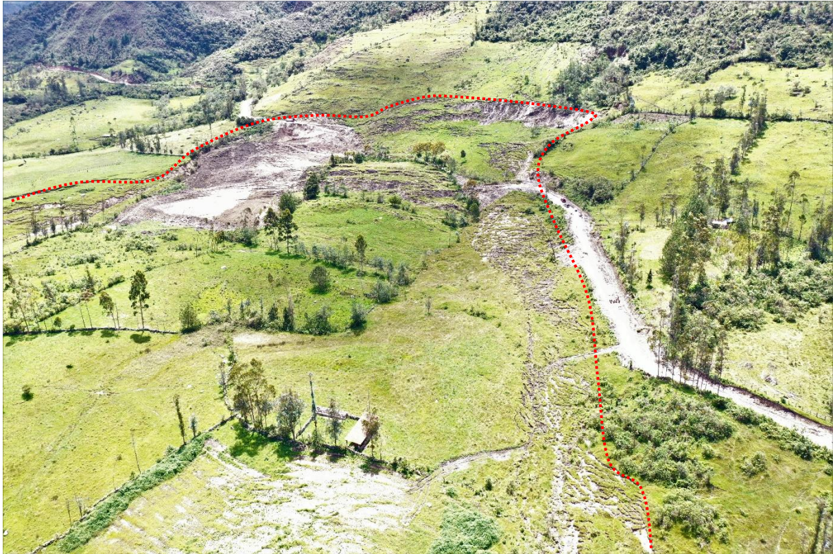
Figura 10. Escarpa principal del deslizamiento Fuente: Imagen tomada con dron Mavic 2 Pro.
