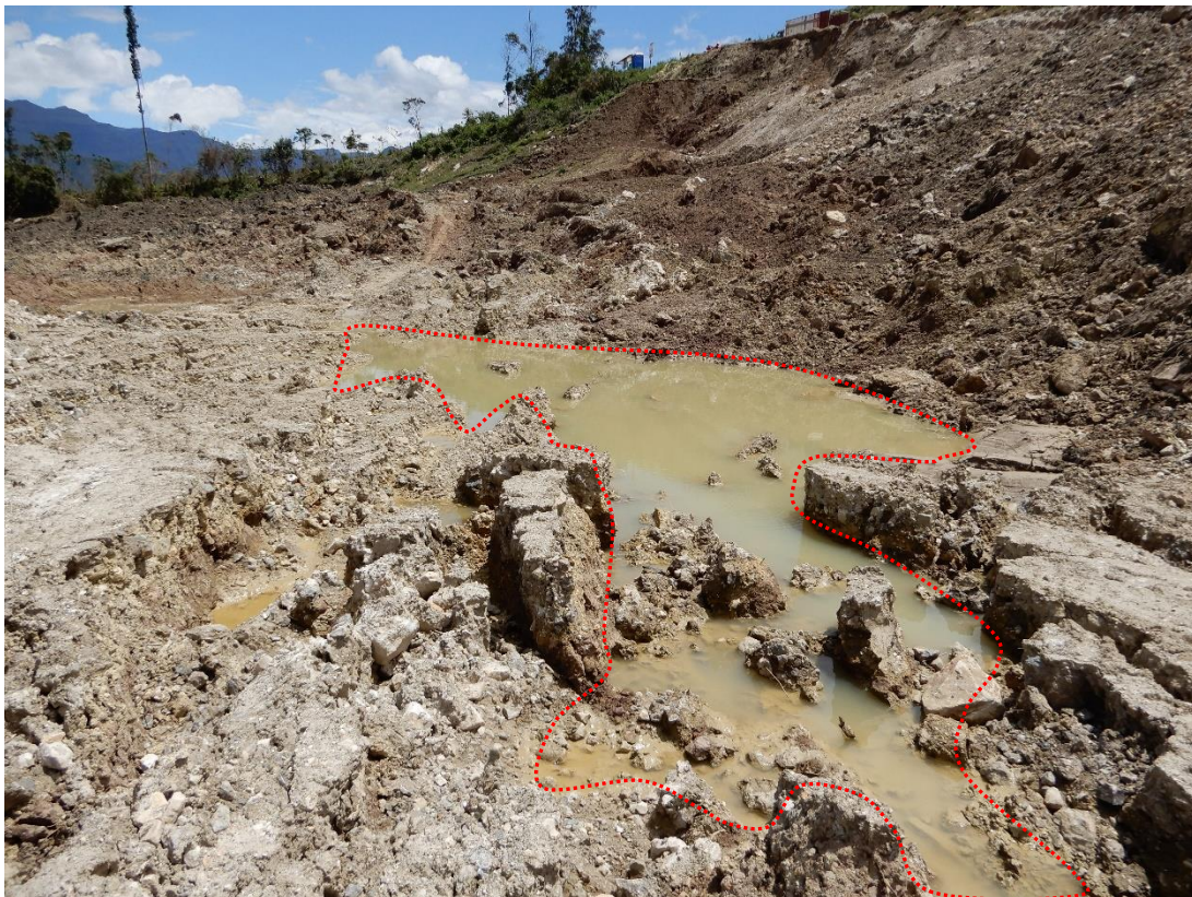
Figura 5. Se observa espejos de agua en el cuerpo del deslizamiento, evidenciando la saturación del terreno.
