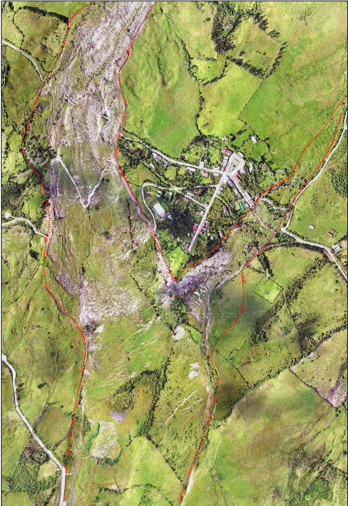
Figura 9. Vista en planta, se observa la masa deslizada que bordeo el área poblada de la localidad de Recta
