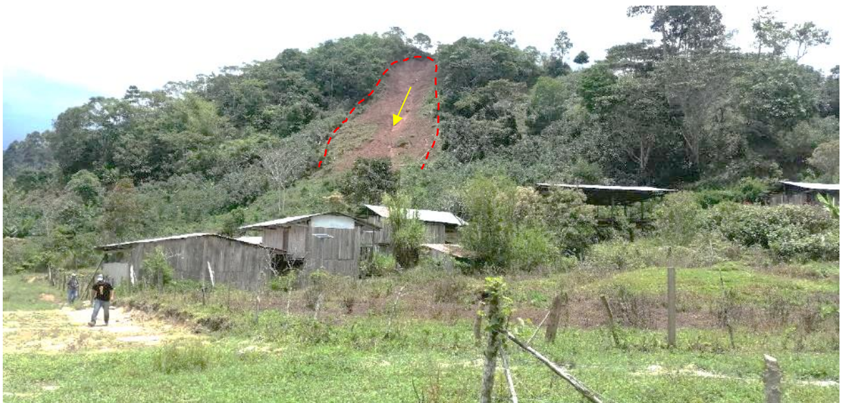
Figura 30. Vista general del deslizamiento-flujo de lodo.
