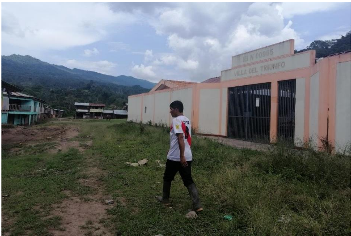
Figura 27. Institución educativa inicial N°00965 Villa El Triunfo, propensa ante inundación fluvial por desborde de la quebrada Santa Clara.
