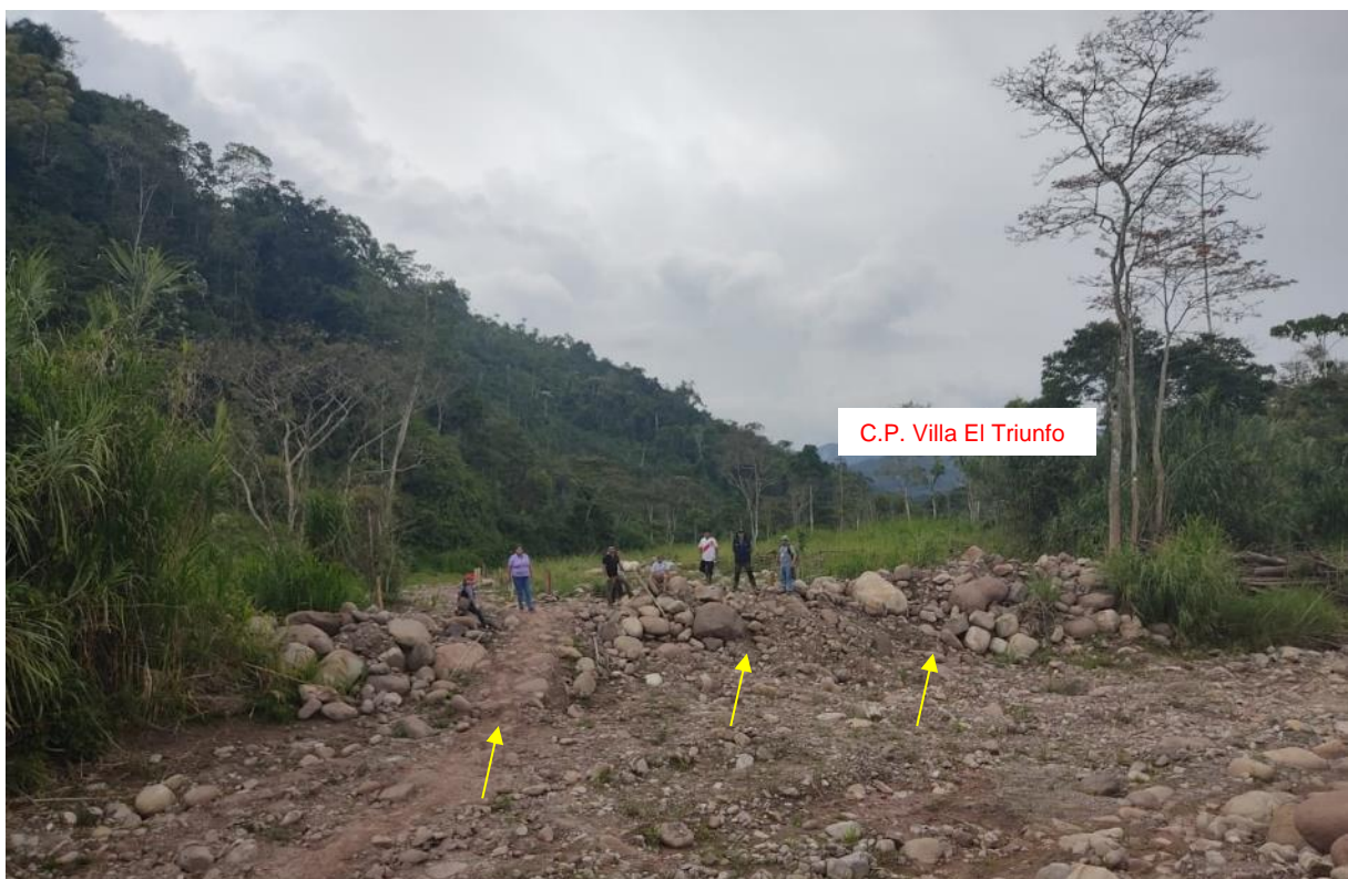
Figura 19. Extremo sur de la terraza aluvial sobre la que se asienta el C.P. Villa El Triunfo. Nótese la conformación rústica de la protección con material propio.
