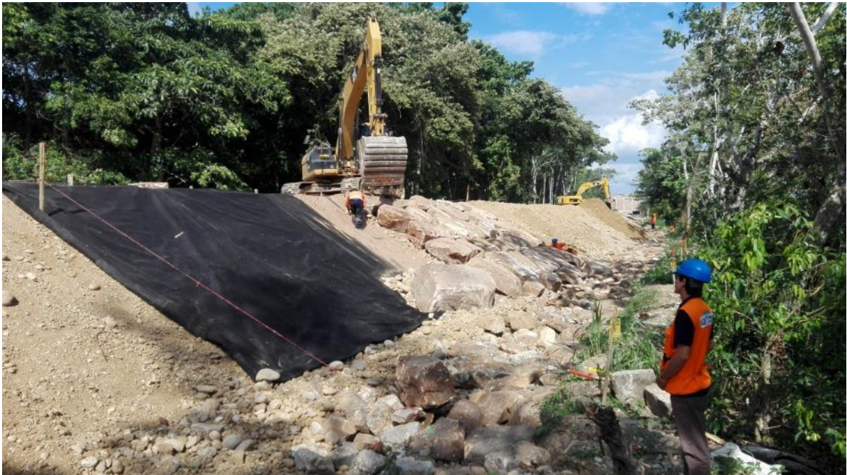
Fotografía 1: Conformación de enrocado y dique de relleno granular, separados por una geomalla. Fuente: Abraham Gamonal Sánchez Obra defensa ribereña de la localidad de Bellavista – San Martín (2016).
