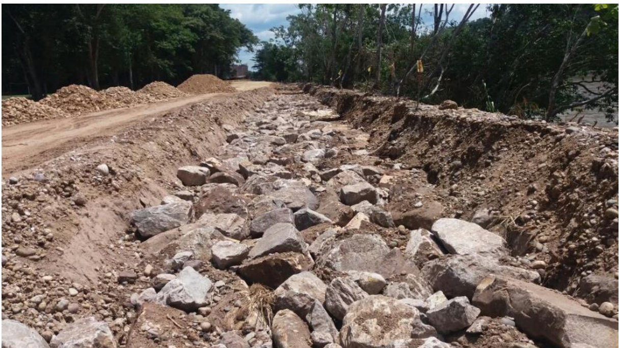
Fotografía 3: Conformación de uña antisocavante con enrocado. Fuente: Abraham Gamonal Sánchez Obra defensa ribereña de la localidad de Bellavista – San Martín (2016).
