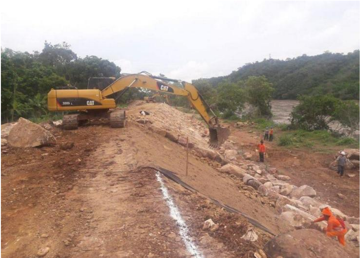
Fotografía 2: Conformación de enrocado y dique de relleno granular. Fuente: Abraham Gamonal Sánchez Obra defensa ribereña de la localidad de Bellavista – San Martín (2016).
