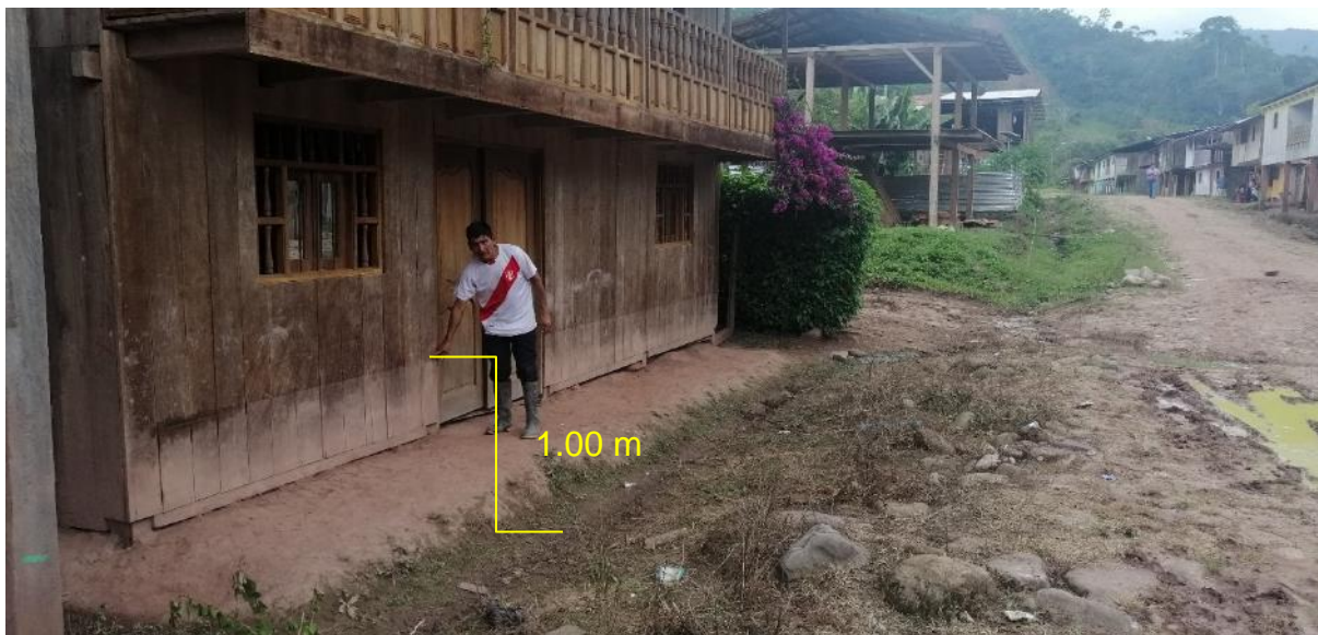
Figura 28. Altura alcanzada por último evento de inundación registrado en el 2019, por desborde del río Indoche. Este nivel alcanza 1.00 m respecto al terreno natural.
