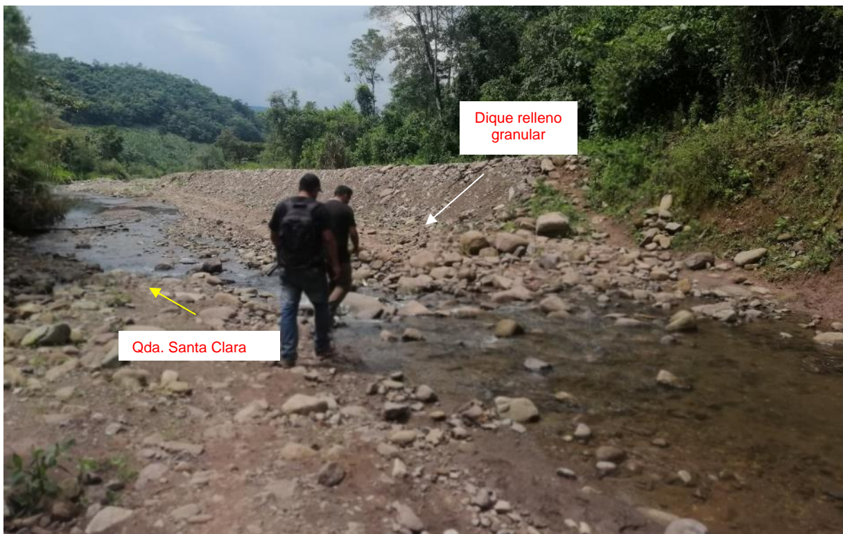
Figura 21. Dique de relleno granular conformado con material propio, como medida de control ante procesos erosivos.
