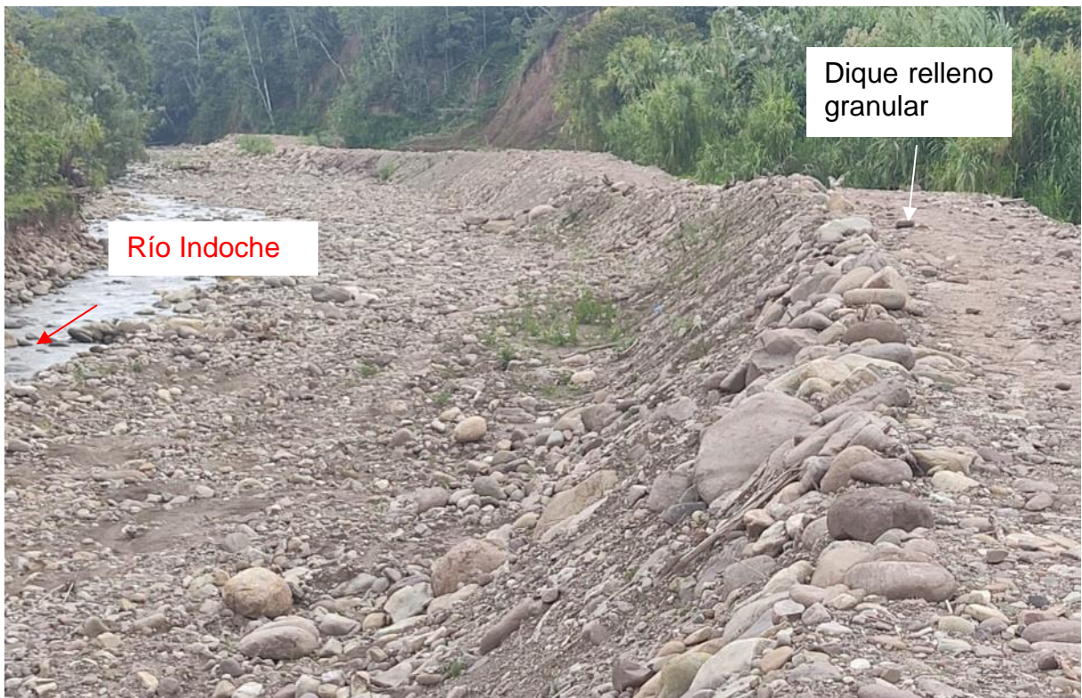
Figura 17. Se observa la conformación de un dique de relleno granular con material propio, como obra de emergencia para protección ribereña.
