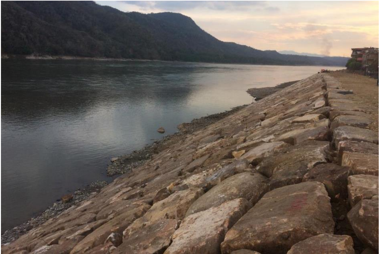
Fotografía 4: Defensa ribereña conformada por enrocado y dique de relleno granular. Fuente: Abraham Gamonal Sánchez Obra defensa ribereña de la localidad de Bellavista – San Martín (2016).
