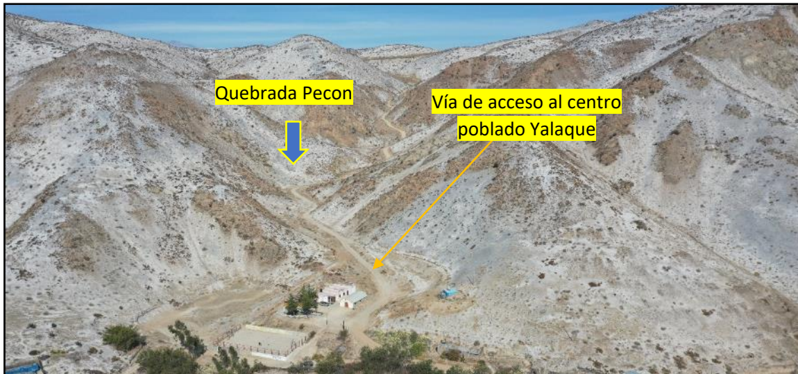
Figura 31. Quebrada Pecon. (Coordenadas UTM WGS84 261550E, 8146149N).
