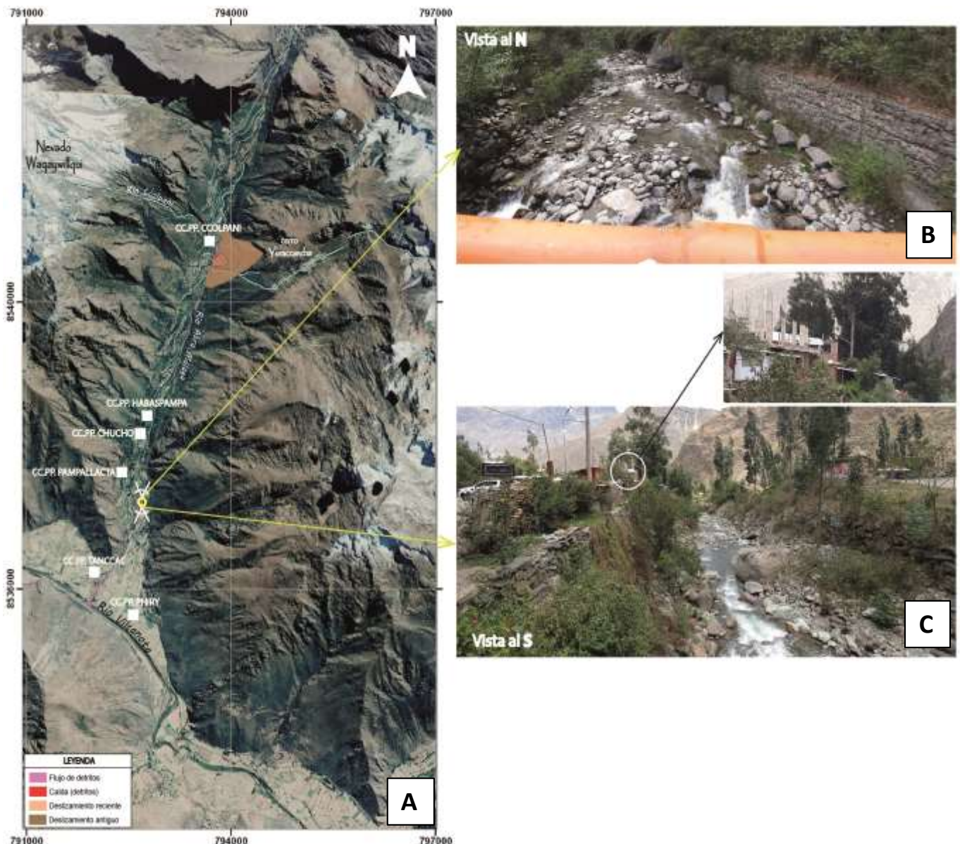
B) Puente Santa Rosa y gaviones realizados en el flanco izquierdo. C) viviendas del C.P. Phiry ubicado en el flanco izquierdo del río Abra Málaga.
