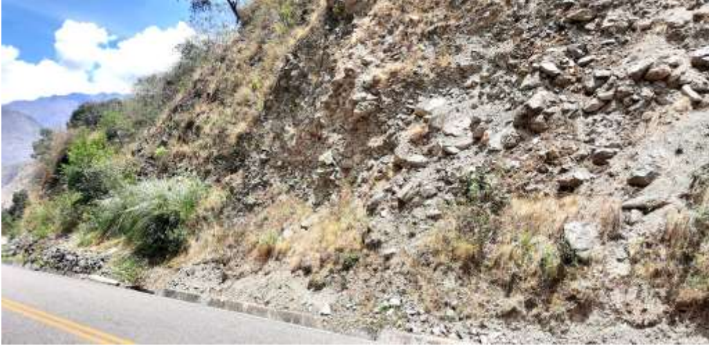
Fotografía 3: Vista de depósitos coluviales en el corte de talud de la carretera Tunasmoco (ruta Ollantaytambo – Quillabamba).
