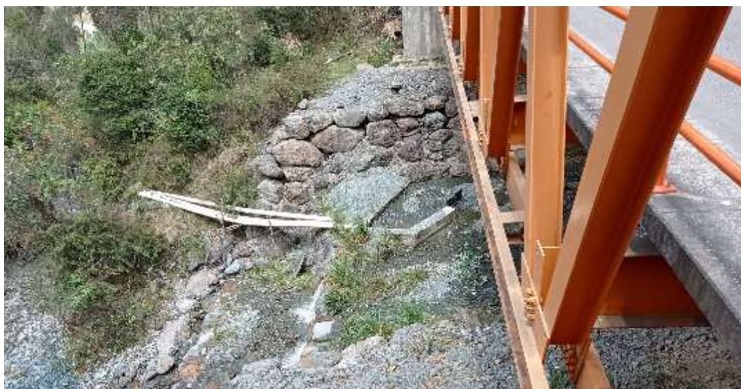
Fotografía 15: Muros de piedra para la protección de la plataforma del puente Ccolpani.
