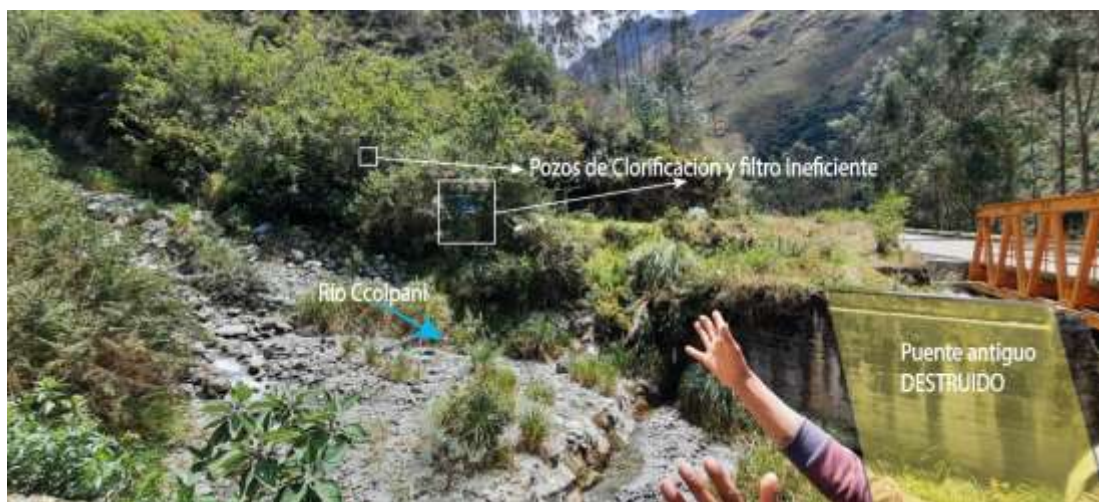
Fotografía 14: Puente antiguo de tránsito peatonal destruido y vista de pozos de clorificación y filtro ineficiente.
