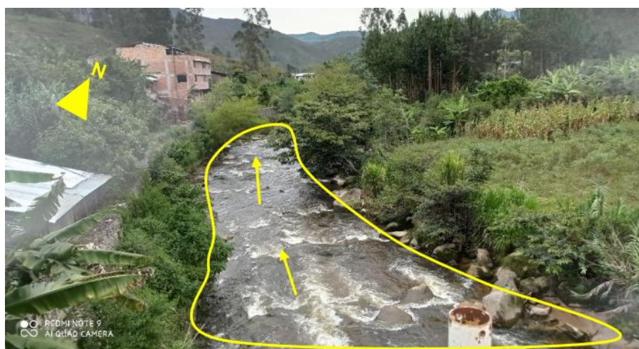
Fotografía 14: Materiales de origen fluvial (bloques de roca) transportados a través del cauce del río Olia
