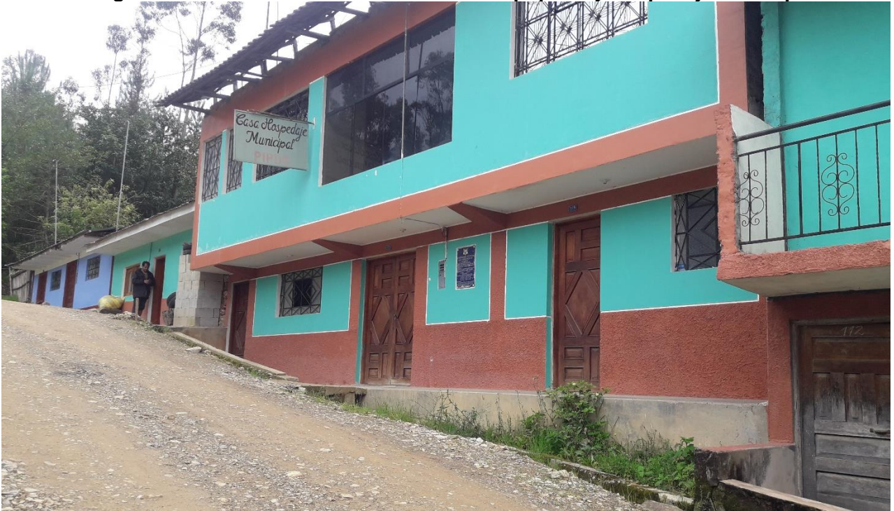
Fotografía 15: Fachada del local del comedor popular y hospedaje municipal
