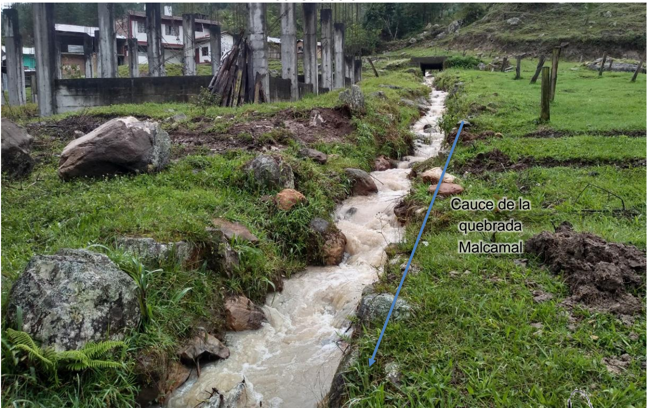
Fotografía 18: Estructuras del nuevo mercado municipal que se encuentra en construcción
