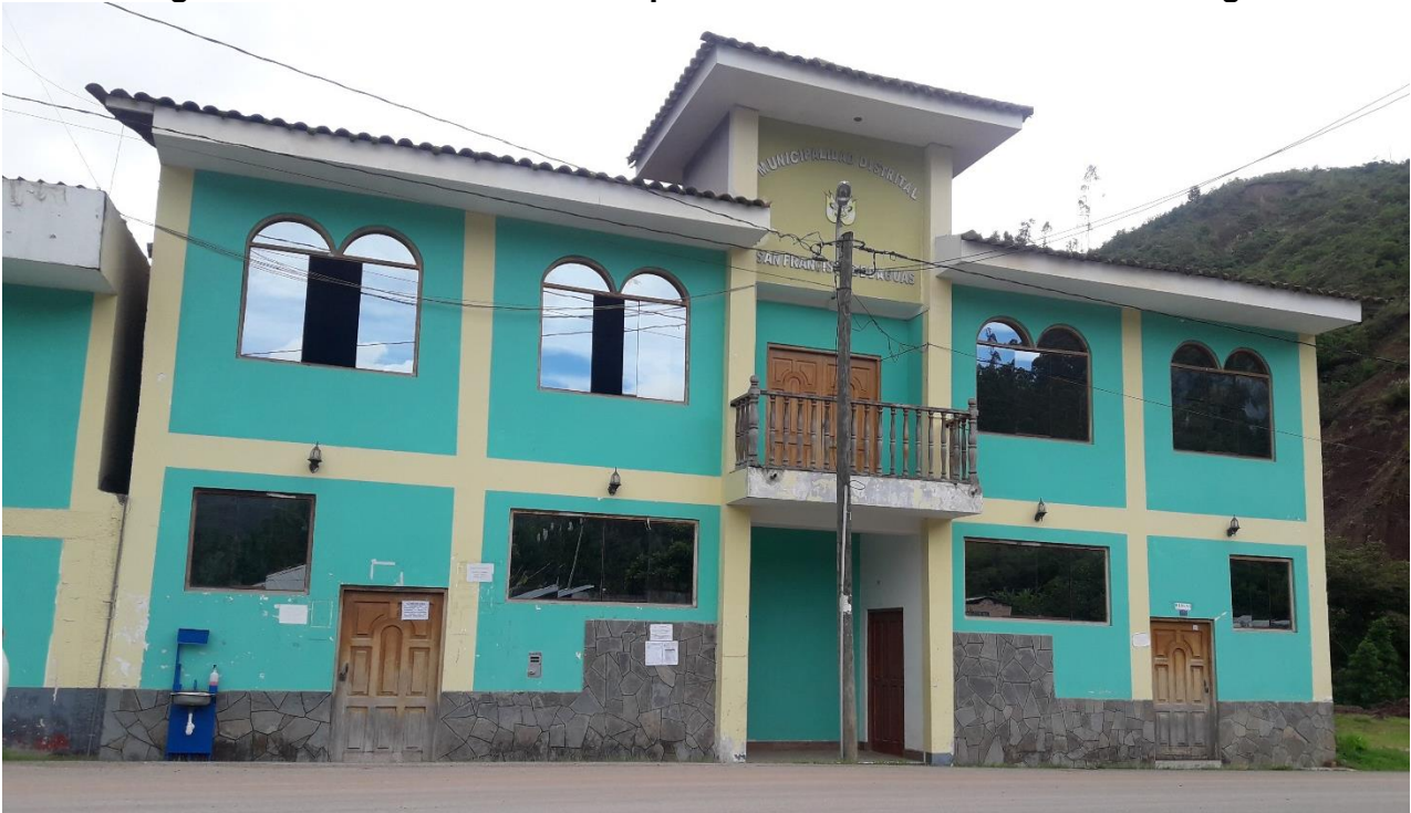
Fotografía 17: Fachada de la Municipalidad Distrital San Francisco de Daguas
