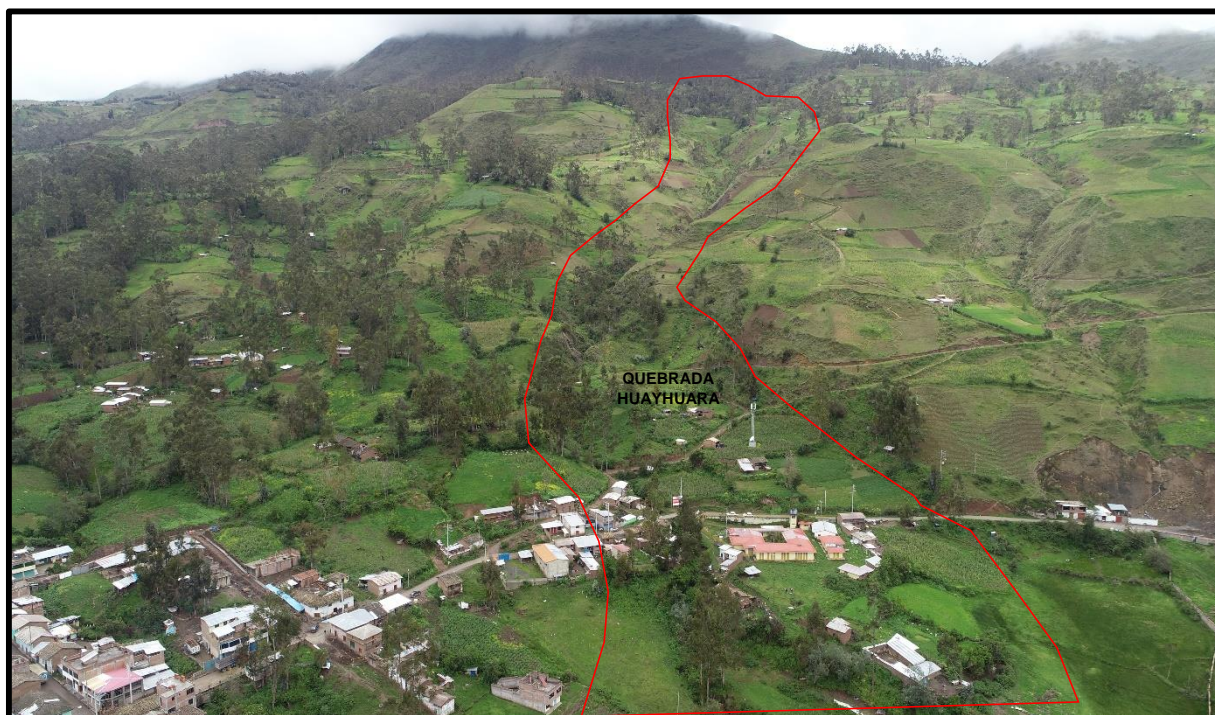
Imagen N° 25: Vista aérea Panorámica del Sector de la Quebrada Huayhuara del distrito de Paucarbamba, provincia de Churcampá y departamento de Huancavelica
