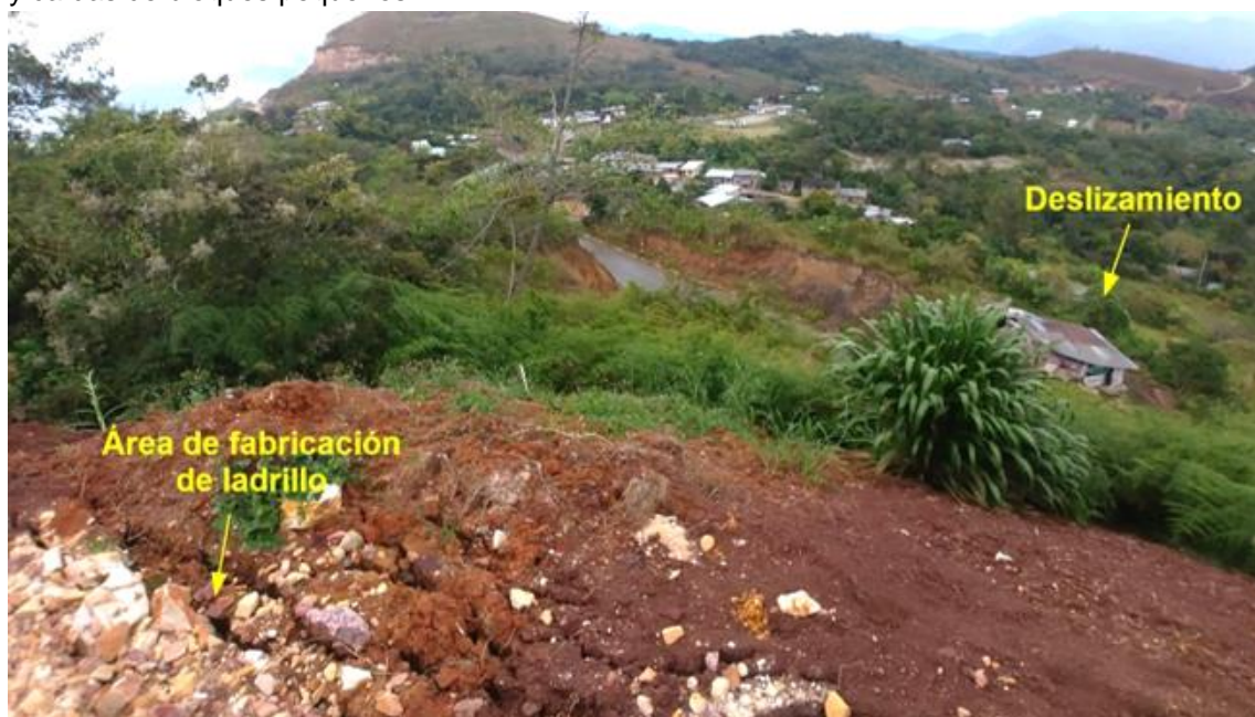
Figura 15: Zona destinada para la elaboración de ladrillo ubicada hacia aguas arriba del deslizamiento.
