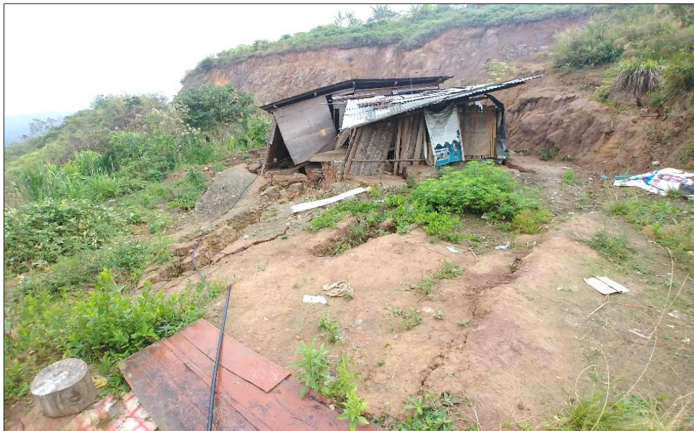
Fotografía 02: Vivienda afectada por el deslizamiento.
