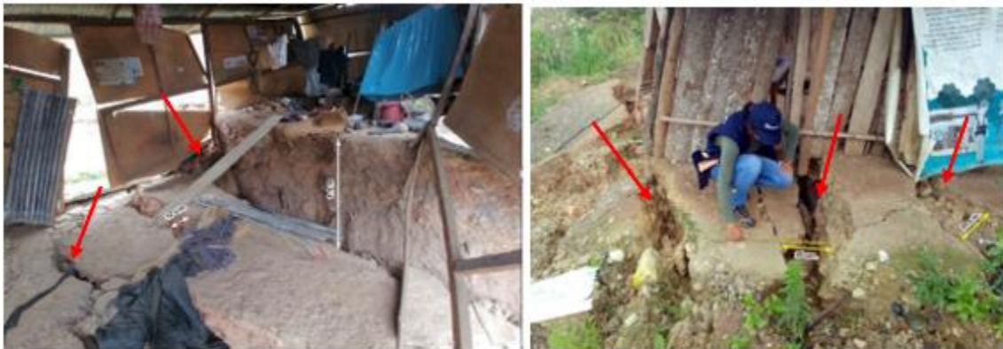
Figura 13: Vista de amplias grietas en el cuerpo del deslizamiento. Nótese que el ancho de las grietas oscila entre 0.12 – 0.3 metros y sus profundidades entre 0.8 – 1.5 metros.
