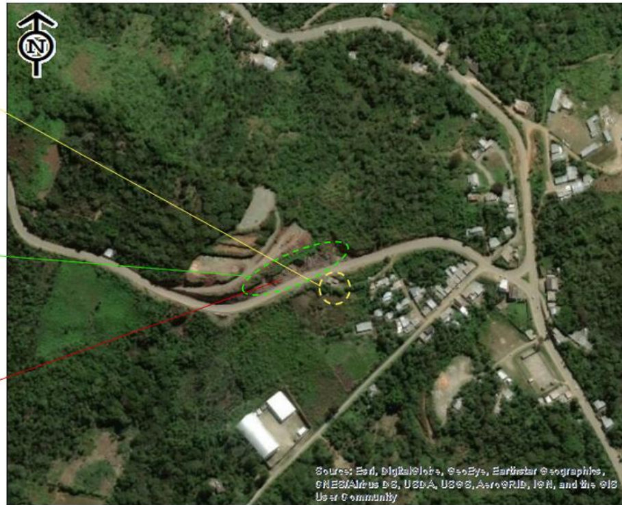
Figura 6: Imagen satelital de la vía de evitamiento. El círculo amarillo representa la zona de deslizamiento en el talud inferior y el círculo verde la zona de erosión de laderas y caídas de rocas (menor ocurrencia) en el talud superior.
