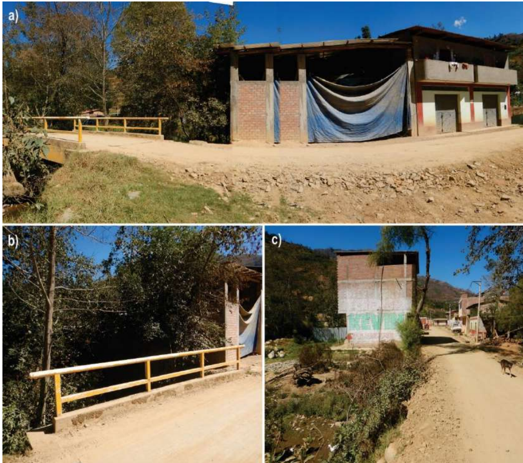
Figura 25. a) Vivienda afectada por el desborde del río, según indica personal de GRD de la Municipalidad distrital de Molino, este llegó a 20 cm, sobrepasando el puente de concreto. b) Puente de 8 m de ancho, 1.8 m de alto, c) Trocha carrozable por donde se desplazó el desborde del río Cochano el cual intersecta con el río Manzano.
