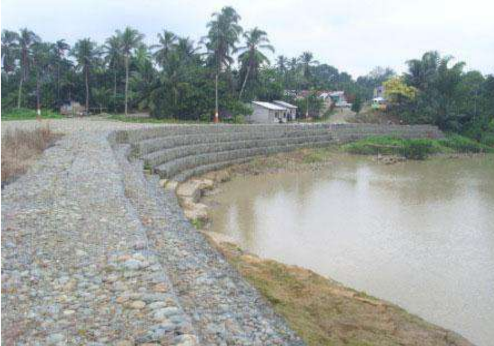
Fotografía 01. Gaviones escalonados (tipo terrazas)
