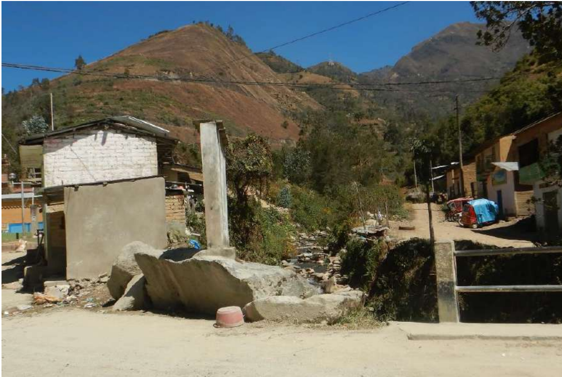
Fotografía 3. Se observó un bloque de 2 x 2.5 m. ubicado a un costado del puente, según informan los pobladores esta fue rodada años atrás cuando se desbordó el río. Se ubica entre las coordenadas UTM 8898343 N, 385027 E con una altitud de 2541 m s.n.m.
