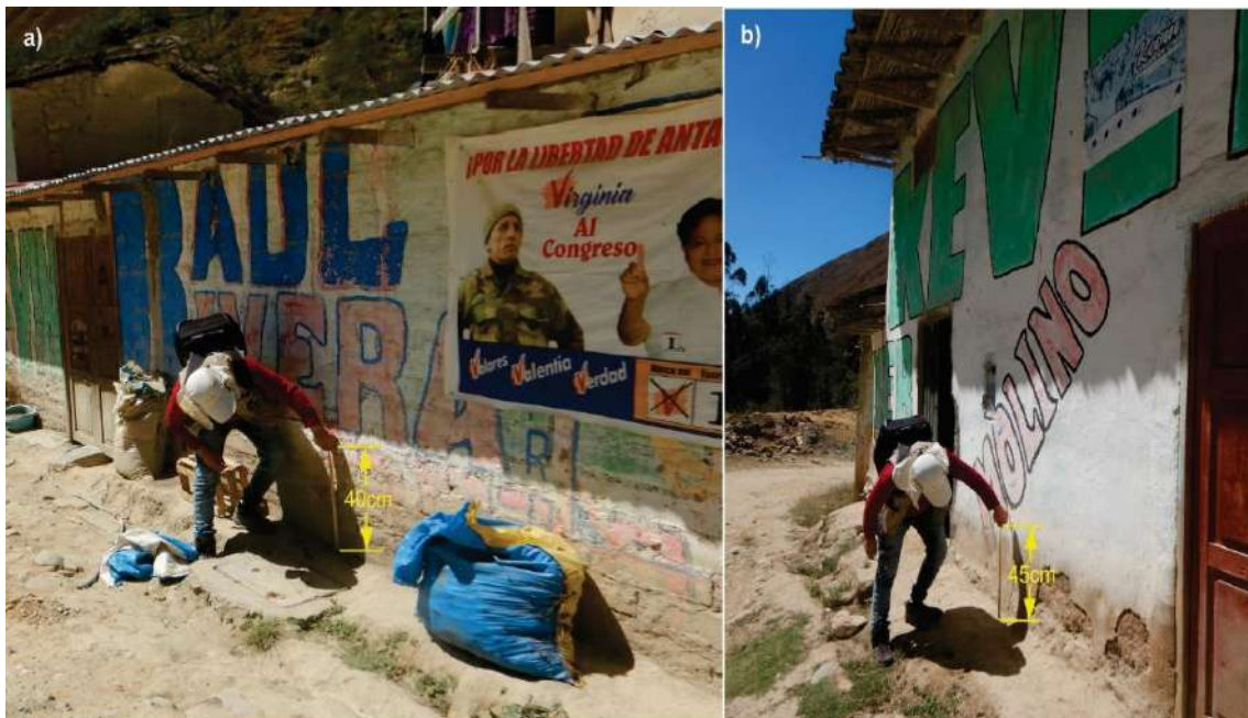
Figura 18. Rastros o huellas del nivel que llegó a alcanzar el desborde del río Cuchimachay, con alturas de hasta 45 cm.
