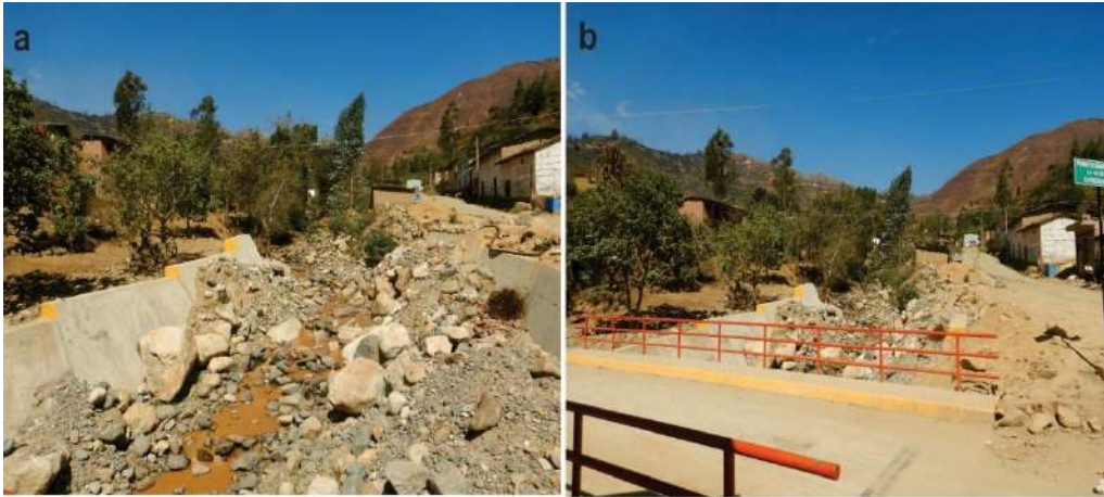
Figura 11. Vista con dirección al sur, donde se observa el material depositado por el huaico, y el estrechamiento del cauce entre 11.5 a 7 m.
