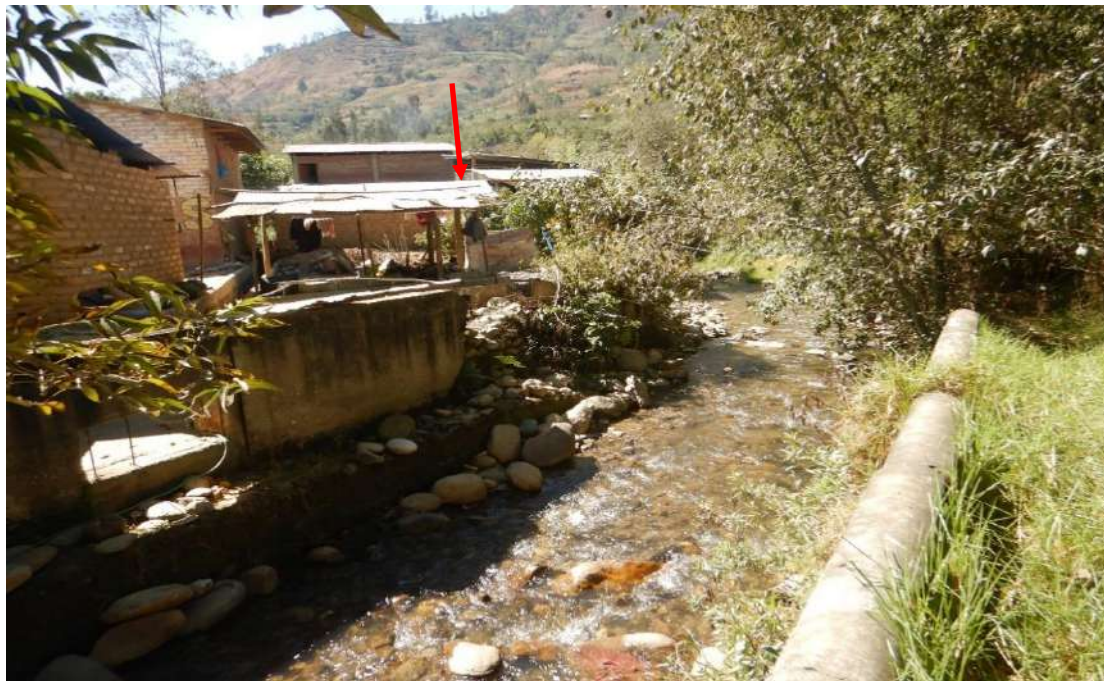
Figura 27. Vivienda en construcción a menos de 2 m del cauce. Es importante destacar que este sector no presenta muro de contención como se puede apreciar en la figura.
