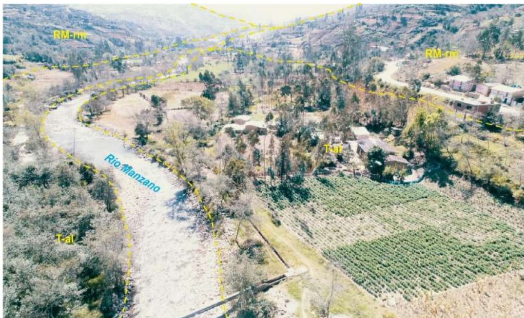
Figura 9. Vista tomada con el dron, donde se aprecia el río manzano y en sus márgenes las unidades de terrazas aluviales y montañas de rocas metamórficas.
