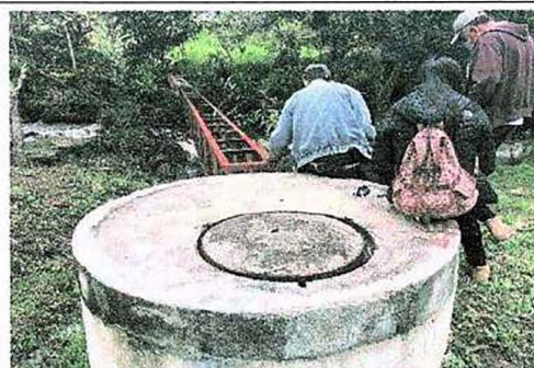
Fotografía N° 2. Tramo 2 - Aguas abajo, zona de inundación. Elementos del sistema de desagüe: Poza séptica y buzón de desagüe.
