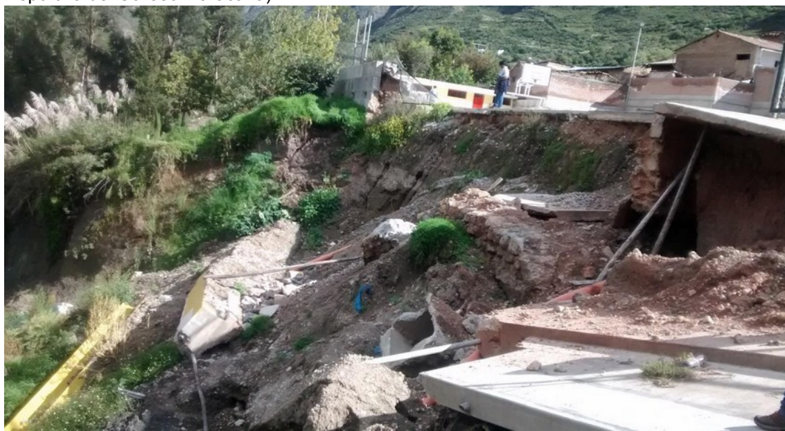
Fotografía N° 10. Se distingue daños de Infraestructura Pública por deslizamiento (Loza Deportiva del Coliseo Maracaná).
