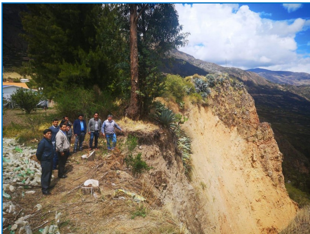
Fotografía N° 4. En la imagen fotográfica se identifica agrietamiento de suelos y derrumbes por erosión fluvial en el Local Institucional del I.E. Basilio Auqui.
