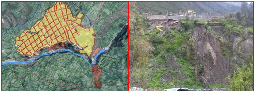
Fotografía N° 1. En el esquema se muestra las zonas de deslizamiento
