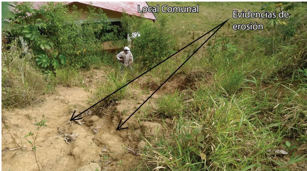
Figura 10. Evidencias de erosión en la ladera del Derrumbe D2 que afectó el local comunal del C.P. La Libertad, descrito en el informe técnico A6710.
