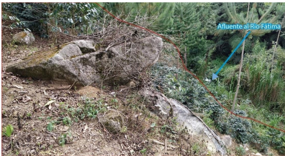
Figura 17. Depósitos coluvio-deluviales en el área propuesta de reubicación 1.
