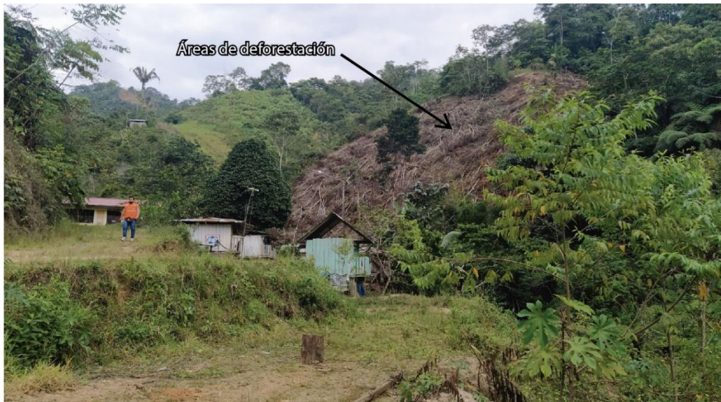
Figura 11. Área de deforestación, en la ladera que genero el derrumbe D3
