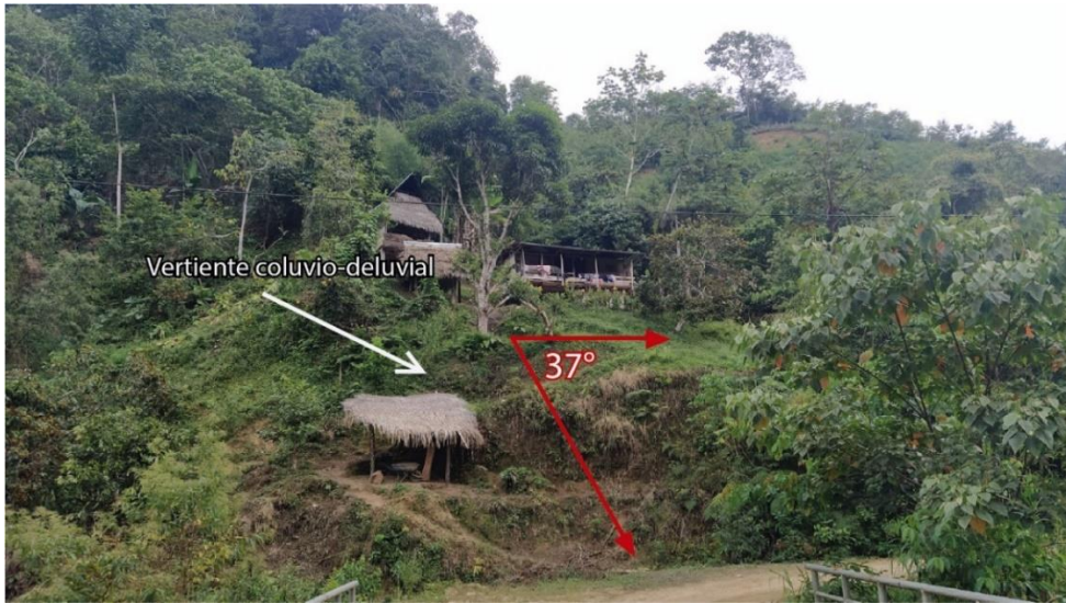
Figura 8. Viviendas del C.P. La Libertad construidas sobre depósitos coluvio-deluviales.
