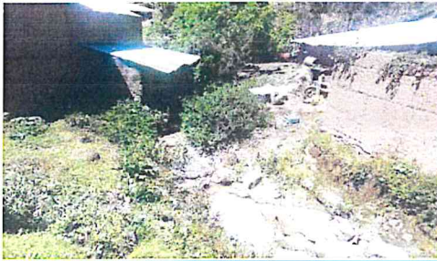
viviendas ubicadas en la quebrada Chasqui
