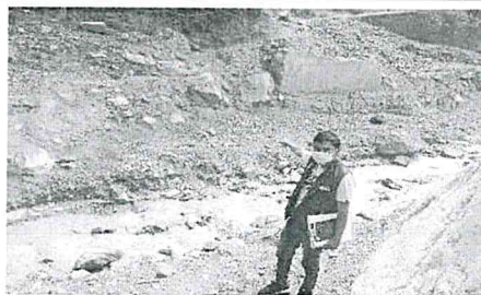
Erosion de la Margen derecha e izquierda de la quebrada cochacan en el C.P. Acocachán
