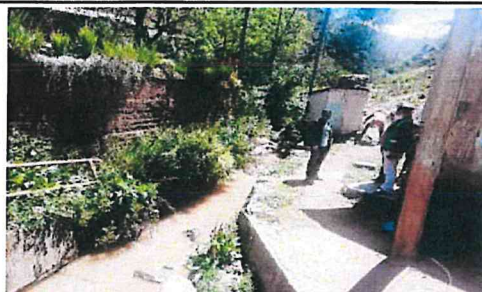
Erosion de la Margen derecha e Izquierda de la quebrada Osapampa en el C.P Chasqui
