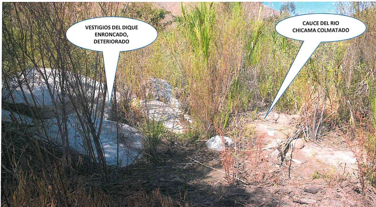
FIGURA N°01: TRAMO CRÍTICO EN EL RÍO CHICAMA , EN EL SECTOR HUABALITO, DISTRITO DE CHICAMA, PROVINCIA DE ASCOPE - LA LIBERTAD.
