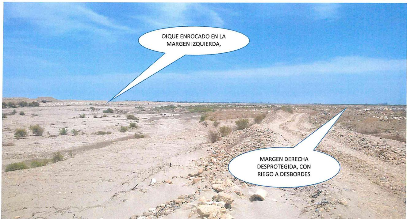
FIGURA N°01: TRAMO CRÍTICO EN EL RÍO CHICAMA , EN EL SECTOR PUENTE CAREA AGUAS ABAJO, MARGEN DERECHA DEL RIO CHICAMA, DISTRITO DE CHOCOPE, PROVINCIA DE ASCOPE - LA LIBERTAD.
