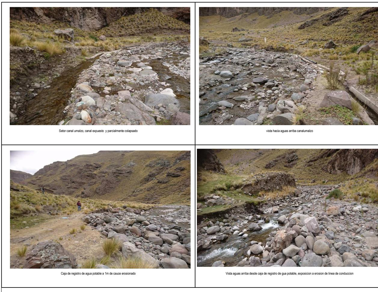
Setor canal umalzo, canal expuesto y parcialmente colapsado
