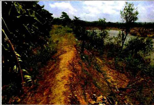
En la columna de fotografías se observa el muro que fue erosionado por la avenida del río Tumbes
