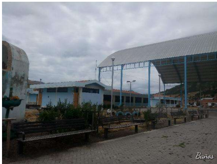
Vista de los pabellones y servicios de la I.E. Gran Amauta, en buenas condiciones estructurales.
