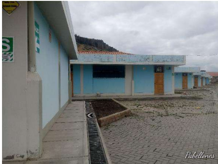
Vista de los pabellones de la I.E. Gran Amauta, en buenas condiciones estructurales.
