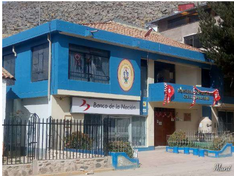
Vista de la municipalidad distrital, en buenas condiciones estructurales.
