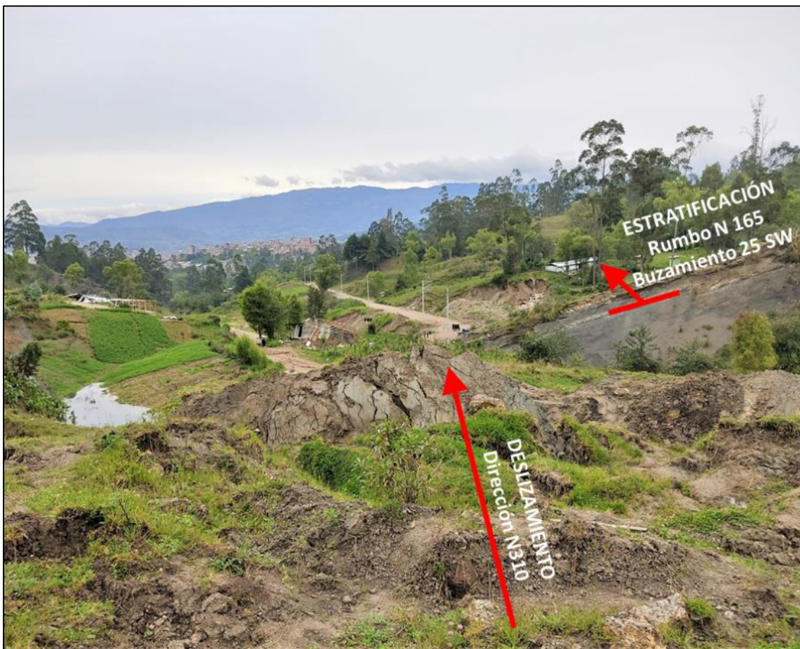
Figura 18. En la figura se puede ver que el buzamiento de la estratificación es favorable a la pendiente del terreno, y por ende a la dirección del desplazamiento del deslizamiento. Coordenadas UTM 761623 E – 9273783 N
