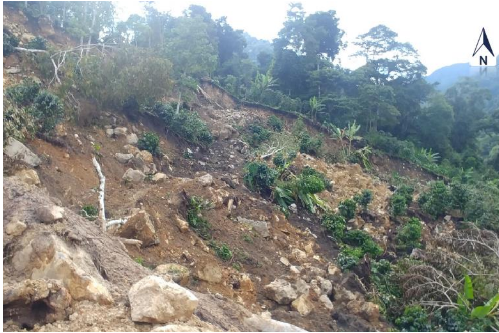
Figura 7. Se puede apreciar en el cuerpo del deslizamiento que se erradicó las especies nativas para ocuparlos por cultivos de café y plátano, probablemente sin implementación de drenajes adecuados, permitiendo el incremento de la saturación del terreno.
