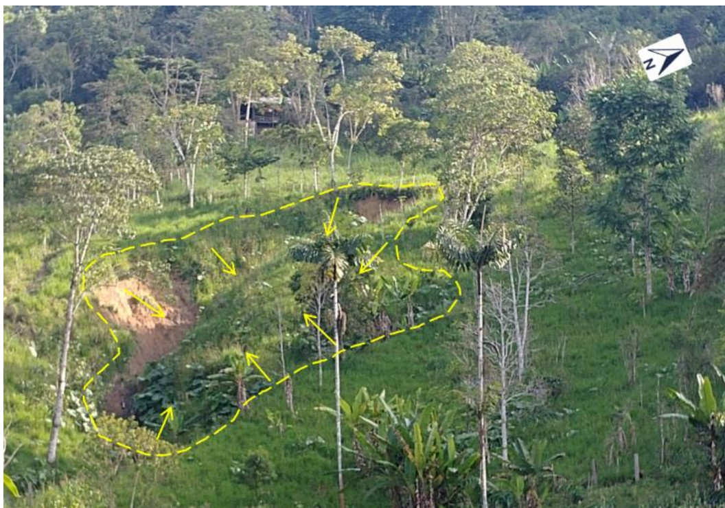
Figura 11: Hundimiento en la parte posterior al deslizamiento, se puede apreciar la erradicación de las especies nativas.
