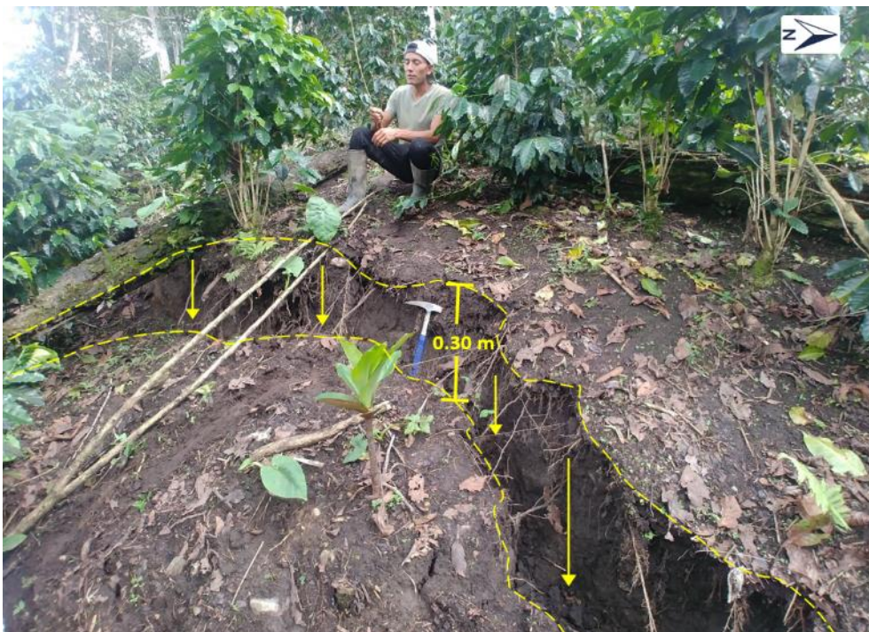
Figura 8. Grieta con desplazamiento vertical de 30 centímetros, en la parte posterior del deslizamiento.
