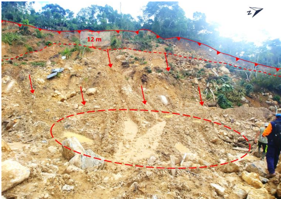
Figura N° 12. Se puede observar la surgencia de agua dentro del cuerpo deslizado, indicativo que los suelos se encuentran totalmente saturados.
