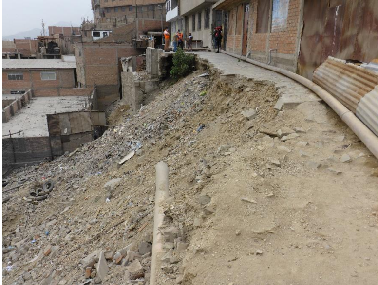
Fotografía 6. Vertiente coluvial de detritos (V-d) generada por el derrumbe en el asentamiento humano La Milla.
