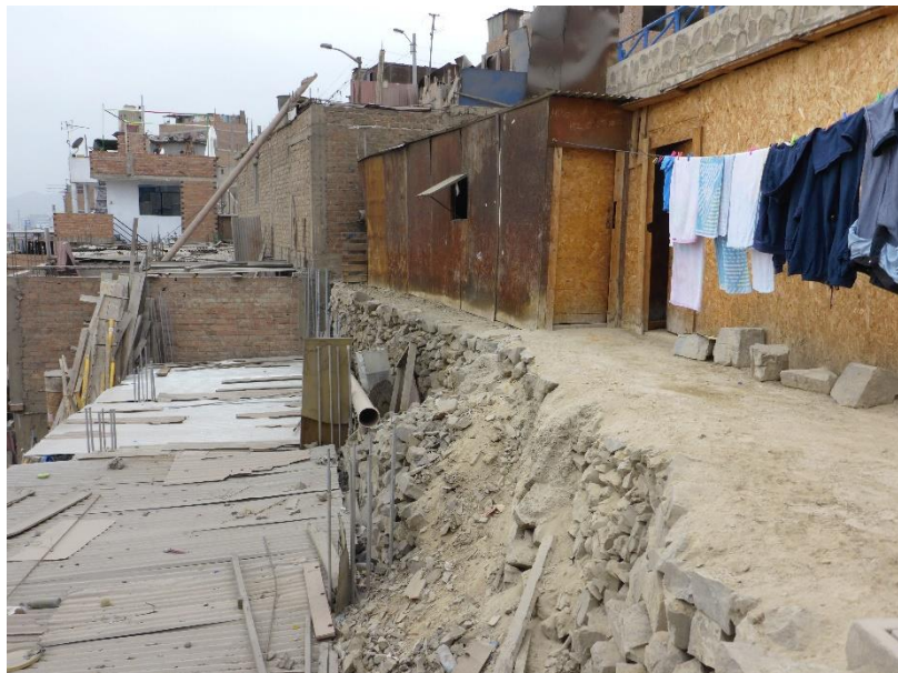
Fotografía 10. Vivienda ubicada sobre pircas de rocas en el Pasaje Huascarán. Coordenadas UTM (WGS 84): 275358 E, 8670785 N.
