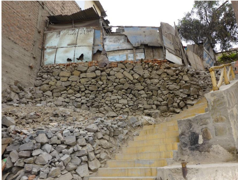
Fotografía 9. Vivienda de madera y calamina ubicada sobre pircas de rocas y ladrillos a la altura del Pasaje Huascarán. Coordenadas UTM (WGS 84): 275362 E, 8670769 N.
