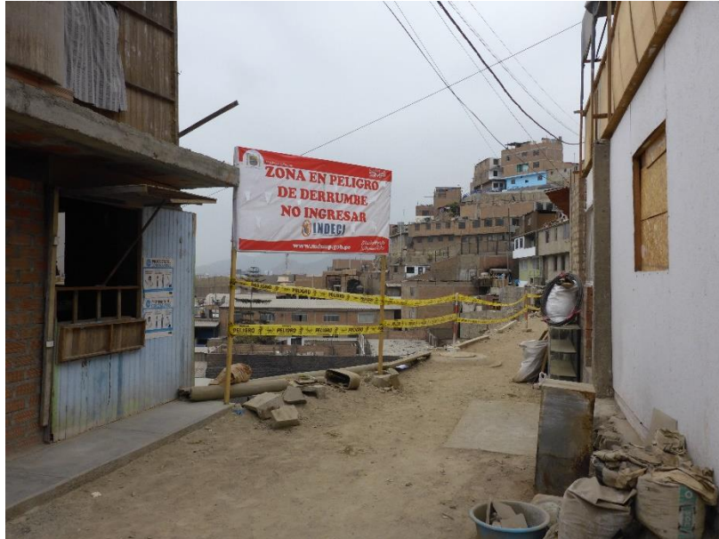
Fotografía 15. Señalización de la zona de peligro por derrumbe en el asentamiento humano La Milla. Coordenadas UTM (WGS 84): 275335 E, 8670807 N.
