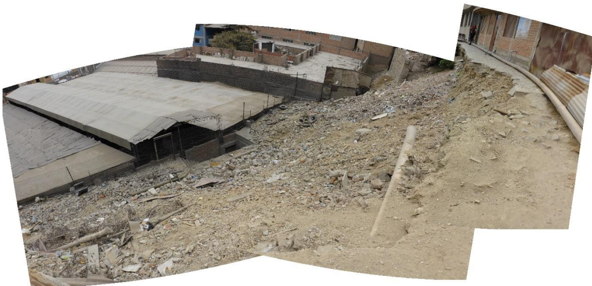
Fotografía 8. Vista panorámica del derrumbe en el asentamiento humano La Milla. Coordenadas UTM (WGS 84): 275330 E, 8670810 N.
