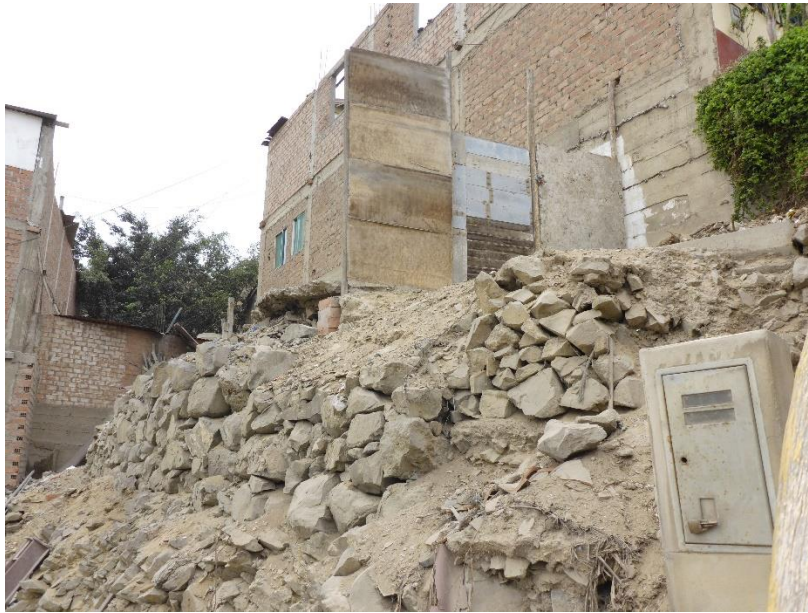
Fotografía 11. Viviendas construidas sobre pircas de rocas en el Pasaje Arica. También se puede apreciar material de relleno como arenas y desmote. Coordenadas UTM (WGS 84): 275315 E, 8670772 N.
