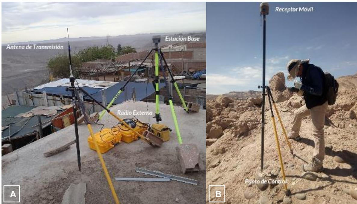
**Figura 4.** Instalación de Equipos para Levantamiento GNSS RTK. Los valores de corrección se envían directamente por radio desde la estación base (A) al receptor móvil (B). De esta manera, con este último se puede registrar continuamente su posición relativa al punto de referencia con una precisión por debajo del decímetro.
