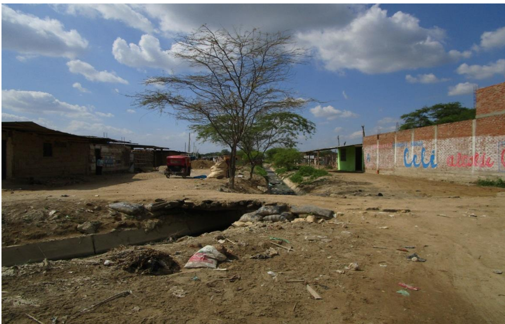
Foto 15: Canal que pasa por el AA.HH. José Carlos Mariátegui se encuentra con agua estancada y con desechos sólidos, en época de precipitaciones se desborda generando inundación en las viviendas aledañas
