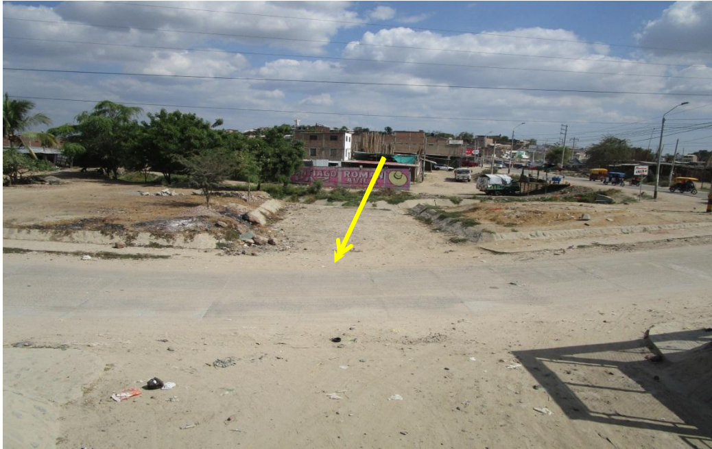
Foto 20: Zona de inundación en el AA.HH. Buenos Aires, afectando el parque recreativo municipal y las vías de tránsito
