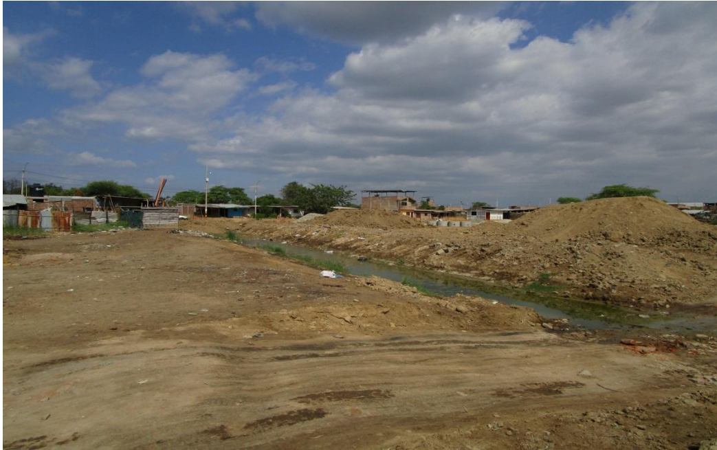
Foto 16: Falta de mantenimiento del canal que pasa por el AA.HH. Renacer, el mismo que en época de precipitaciones colapsa e inunda a las viviendas aledañas al canal
