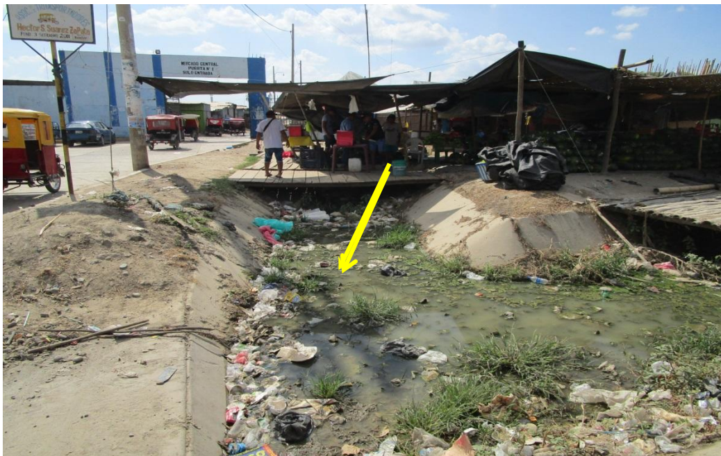
Foto 19: Canal que pasa frente al mercado de Tambogrande, el mismo que en época de precipitaciones colapsa e inunda el mercado y zonas aledañas, además de ser foco de proliferación de enfermedades
