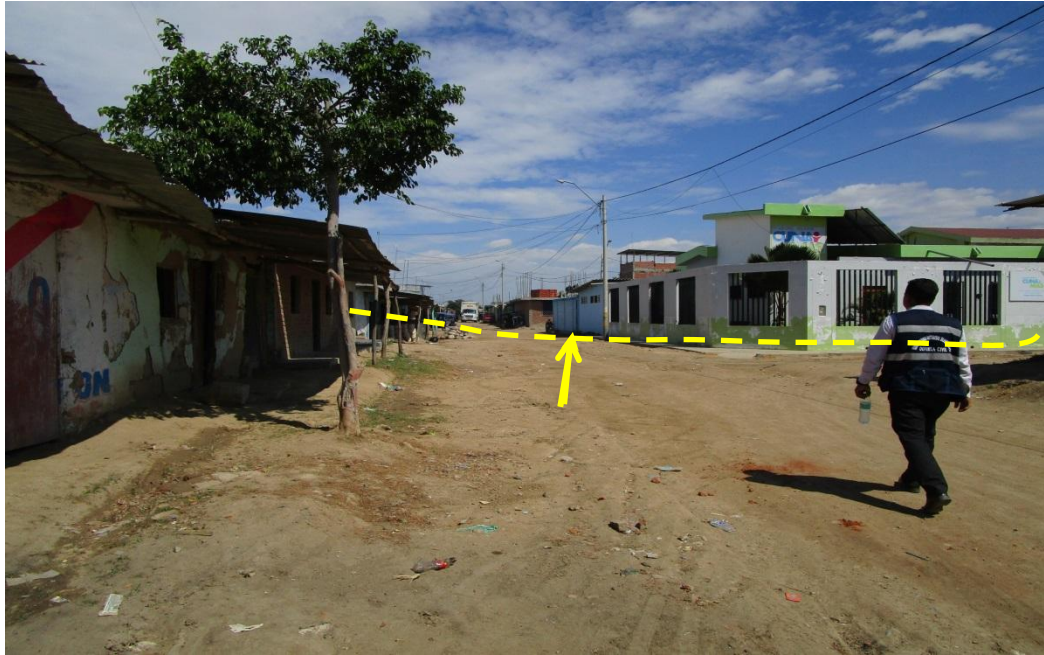
Foto. 12: Hasta este nivel (línea amarilla) llegó el desborde de la quebrada Carneros, el mismo que afectó viviendas aledañas, local comunal Cuna Más y el Centro Integral de Atención al Adulto Mayor (CIAM)
