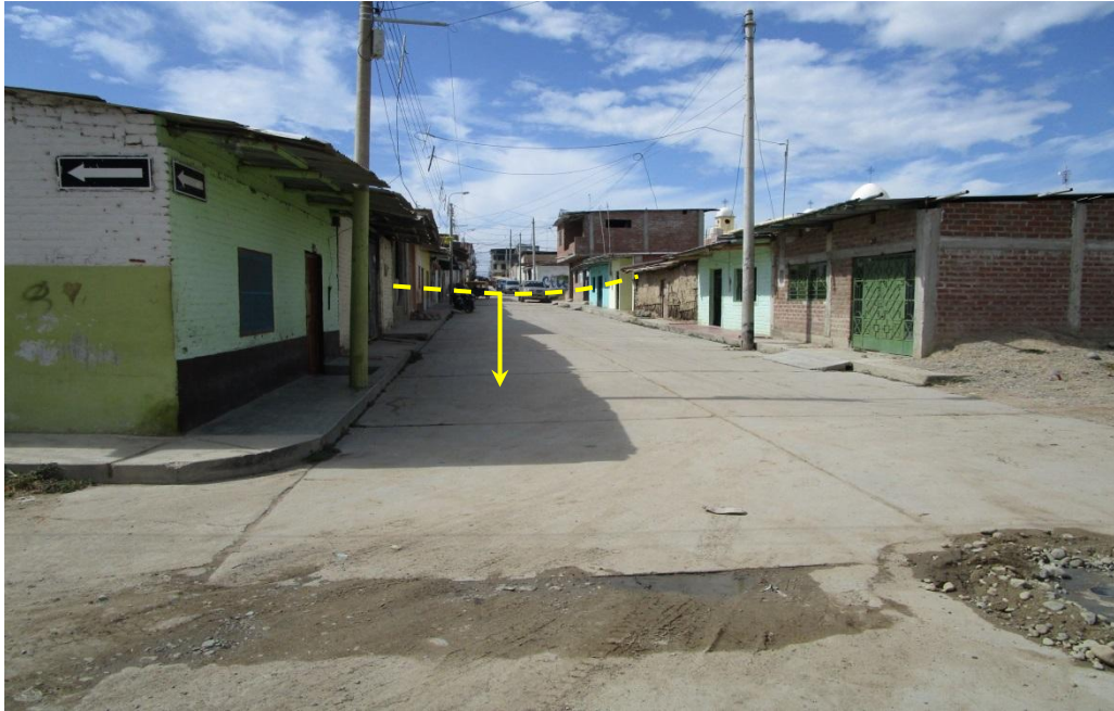
Foto 14: Límite de inundación por desborde del río Piura en el evento El Niño 2017 (línea amarilla), a pocos metros de la base de serenazgo del distrito de Tambogrande, sector Barrio Sur
