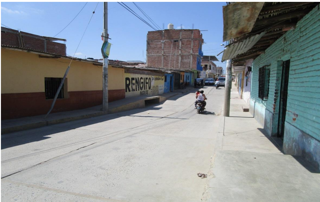
Foto 21: Inundación en el casco urbano de Tambogrande, esto debido a que pasa un canal por la ciudad que no tiene desembocadura, formándose una “Cuenca ciega”
