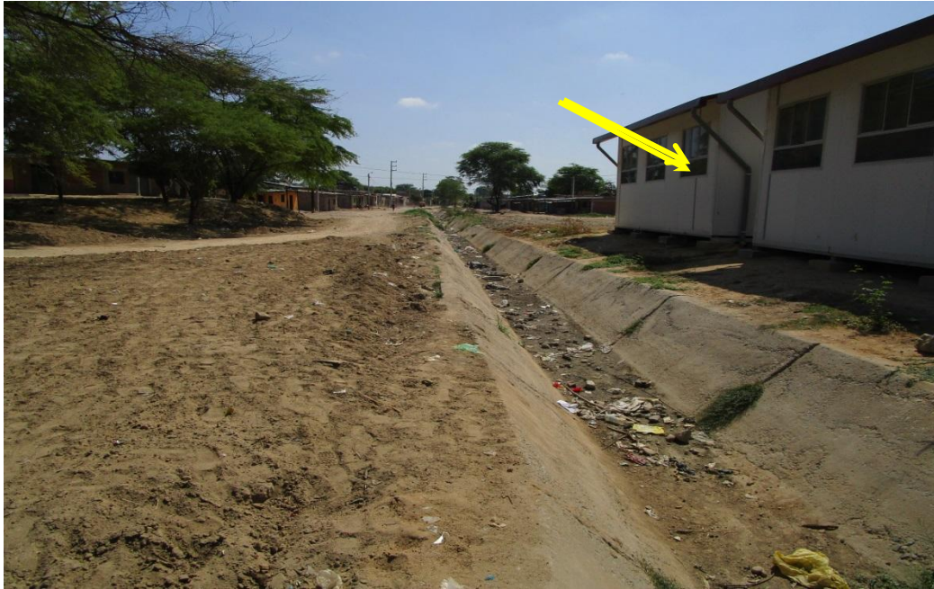
Foto 18: En el evento El Niño 2017 se desbordó este canal, afectando a la Institución Educativa Inicial (flecha amarilla) que se encuentra en el AA.HH. Los Almendros
