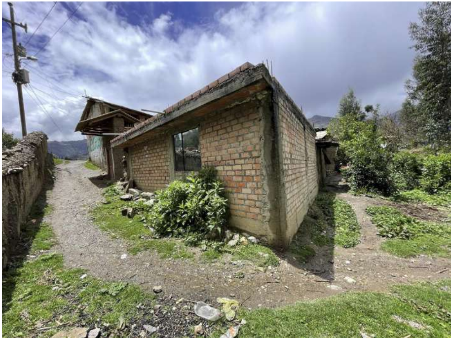
Fotografía N° 10 – Vivienda de material noble (pared ladrillo y techo losa aligerada).
