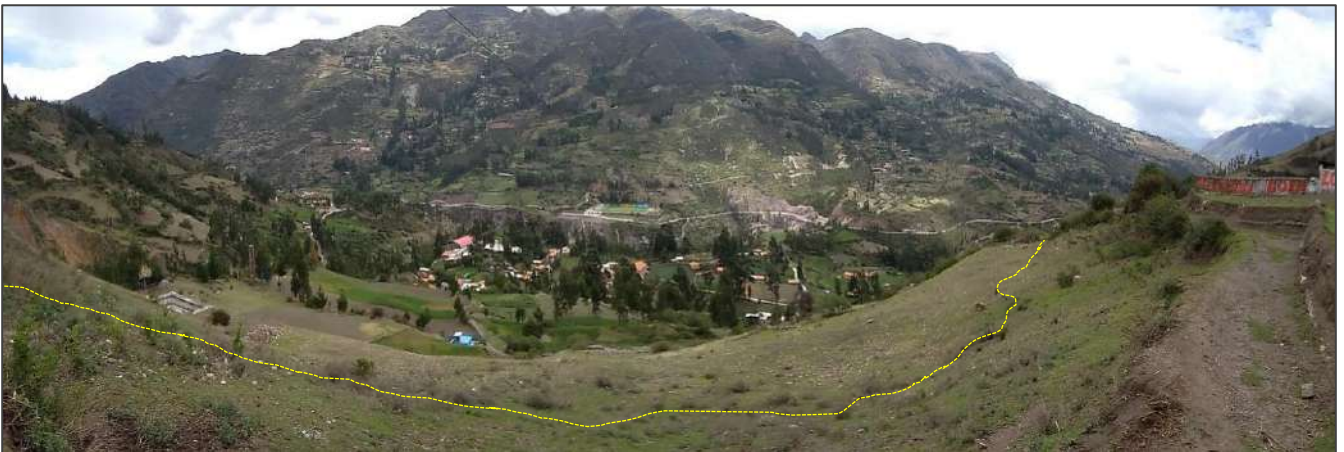
Figura N° 14. Vista de la zona de deslizamiento rotacional en el sector Vista Alegre. Debajo se visualiza el centro poblado Millhuish.
