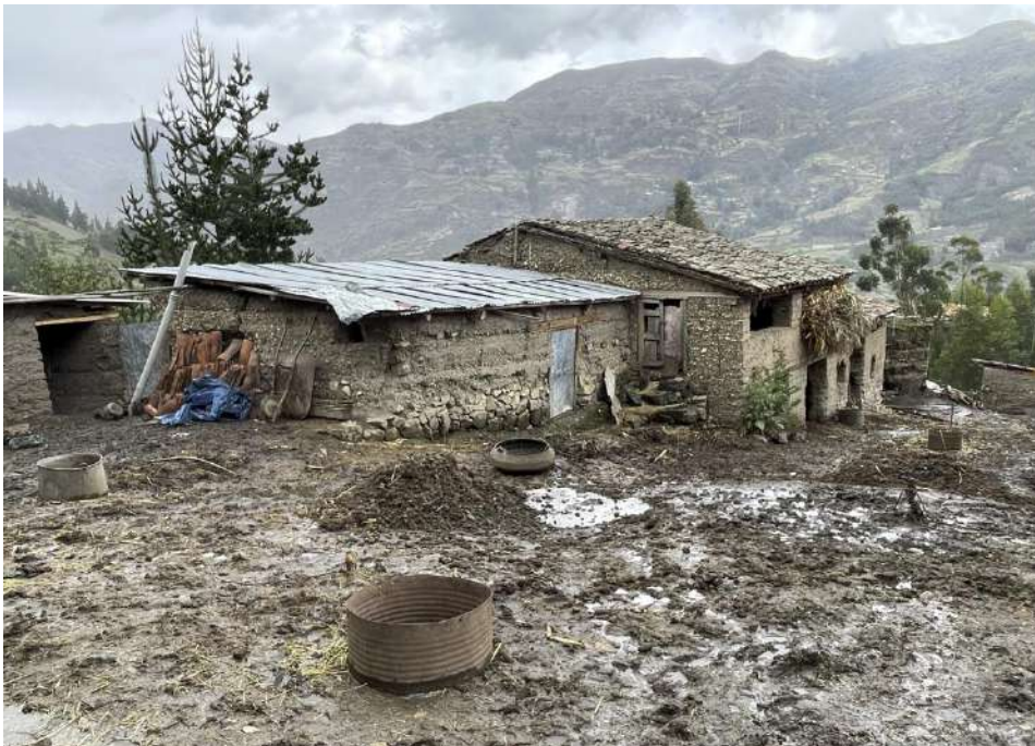
Fotografía N° 14 – Viviendas de material precario.
