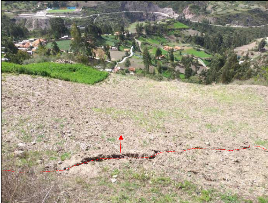
Figura N° 18. Vista de la zona de deslizamiento rotacional en el sector Vista Alegre. Fractura y desplazamiento de la capa de suelo.
