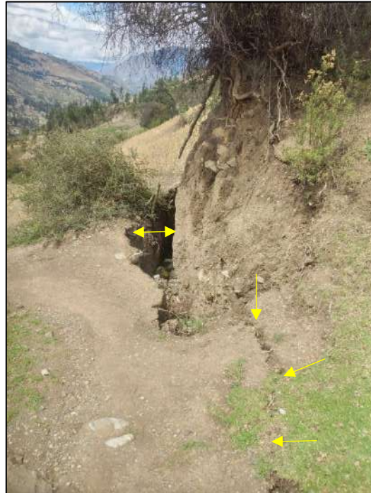
Figura N° 16. Vista de la zona de deslizamiento rotacional en el sector Vista Alegre. Fractura y desplazamiento del suelo.
