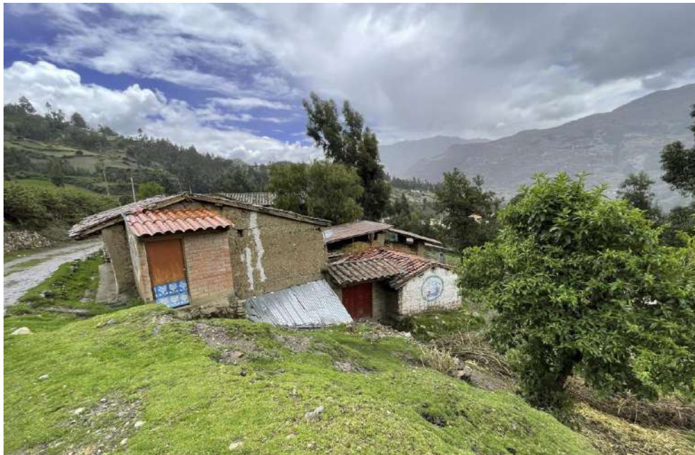
Fotografía N° 16 – Viviendas típicas de la zona de estudio sobre laderas empinadas.
