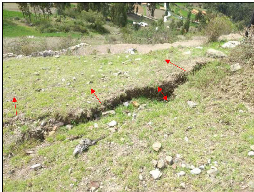
Figura N° 17. Vista de la zona de deslizamiento rotacional en el sector Vista Alegre. Desplazamiento vertical.
