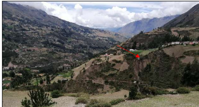
Figura N° 2. Formación geomorfología Talud coluvial.
