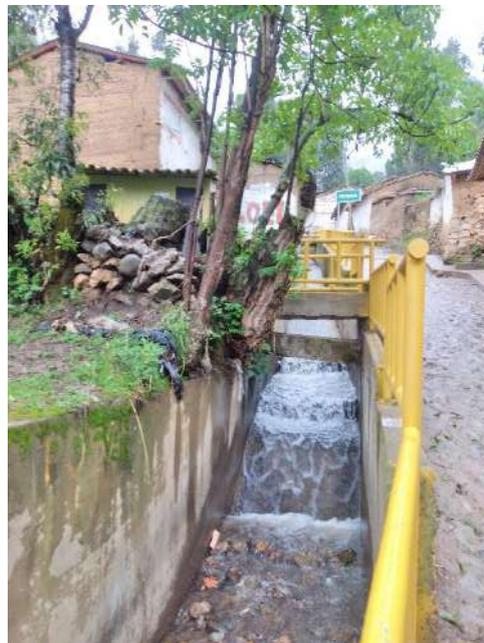
Fotografía N° 6 – Canal de drenaje con presencia de sedimentos por falta de limpieza.
