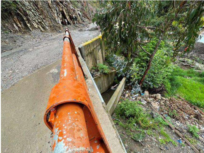
Fotografía N° 11 – Canaleta trasportando el flujo de agua de las precipitaciones.
