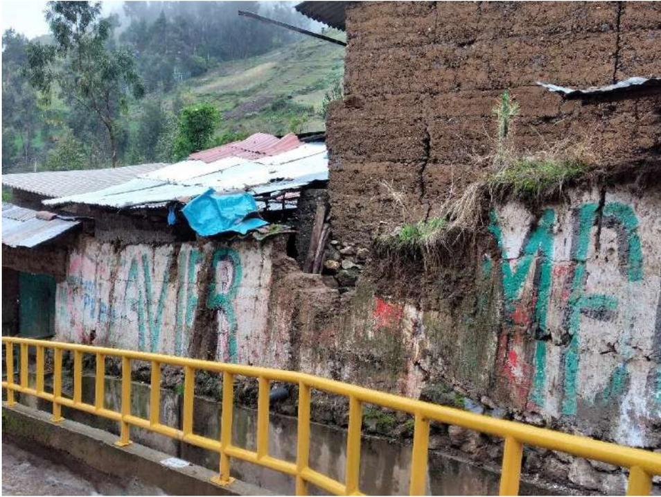
Fotografía N° 9 – Estructura de la vivienda afectada por las precipitaciones.
