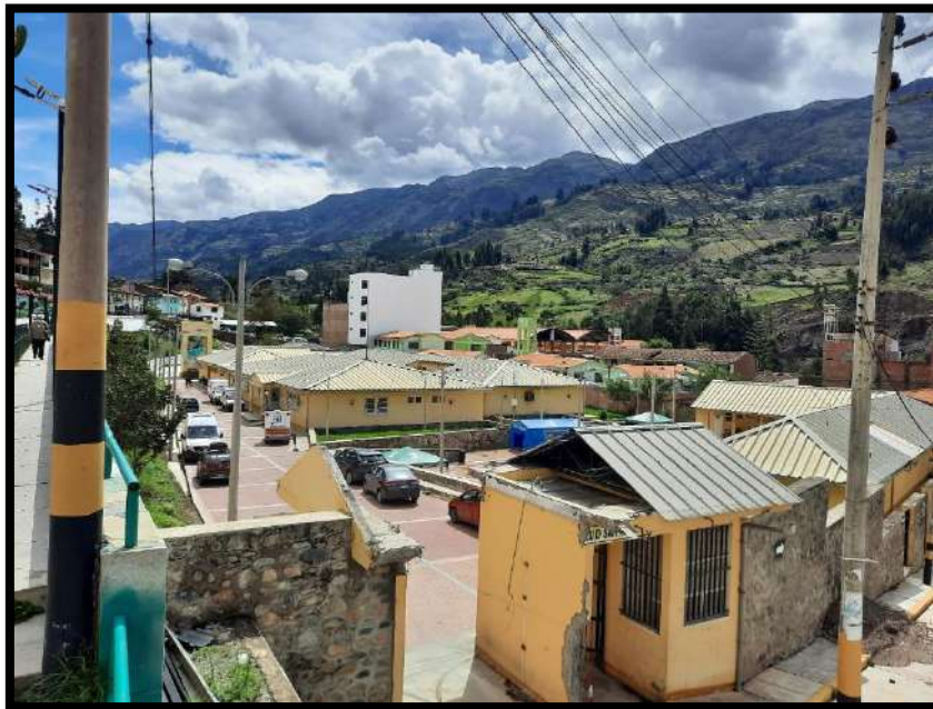
Foto 04. Vista panorámica del Centro de Salud San Marcos con daños en la entrada
