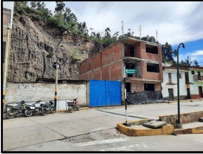
Foto 03. Socavación del cerro para la construcción de nuevas edificaciones
