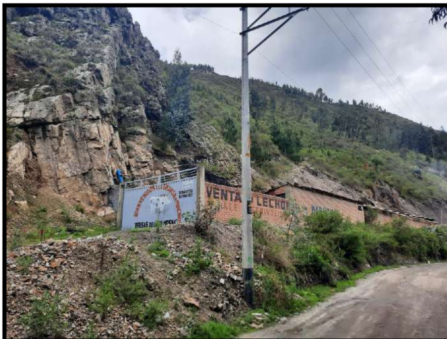
Foto 08. Socavación del cerro para la construcción del local comercial
