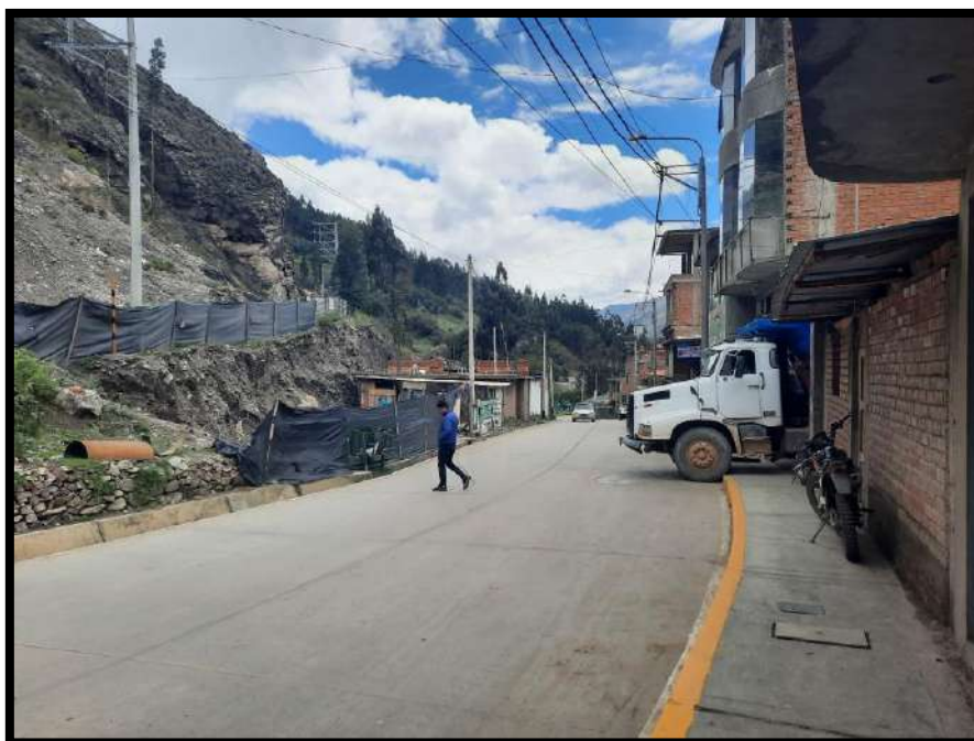
Foto 01. Viviendas ubicadas colindantes con el cerro lado izquierdo de la vía
