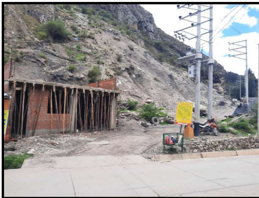
Foto 02. Nuevas construcción viviendas ubicadas colindantes con el cerro
