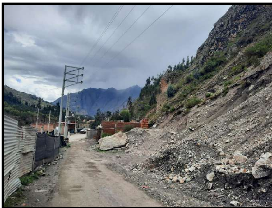
Foto 05. Área colíndate con el cerro donde se producen los deslizamientos
