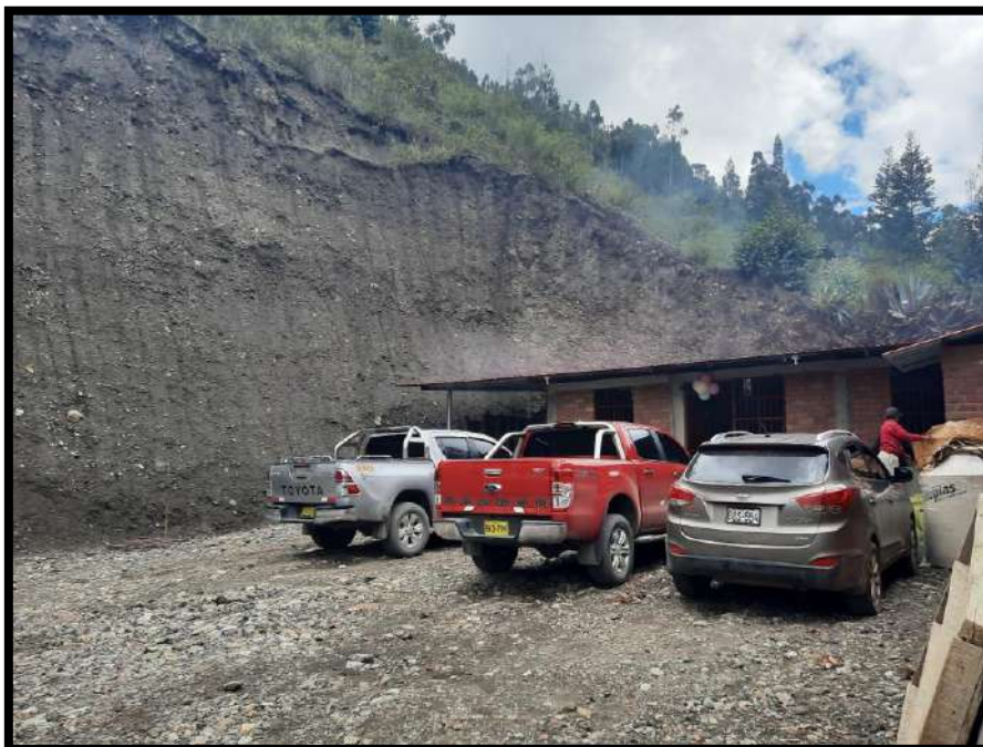
Foto 07. Socavación del cerro para la construcción del local, vista del corte
