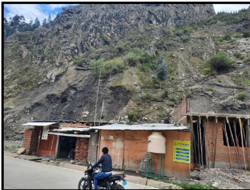
Foto 03. Nuevas construcción viviendas ubicadas colindantes con el cerro
