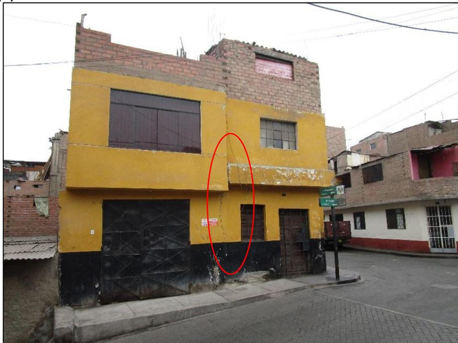
*Figura 51. Daños en viviendas ubicadas en el AA.HH. 1° De Mayo (a) y la intercepción del Jr. Reque y Ca. Huancarqui, en el AA.HH. Villa María del Perpetuo Socorro (b), por efectos del asentamiento del suelo*
