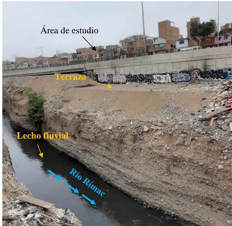
Figura 8. Geoformas (Terraza y lecho fluvial) identificadas en el área de estudio.
