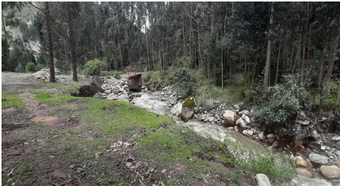
Figura 7. Materiales fluviales depositados en el cauce y materiales aluviales depositados a ambas márgenes de la quebrada Pacchac. Materiales resultantes de flujos aluvionales activados en periodos de lluvias provenientes de quebradas secundarias.
