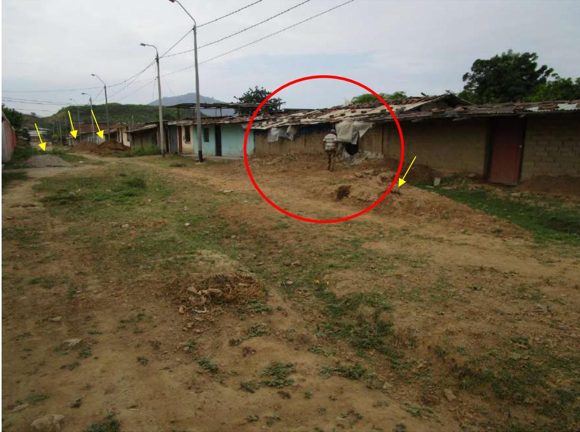
**Foto 10: Vivienda del Sr. Segundo Juárez Pacherras - círculo rojo (autoconstrucción de material precario-adobe) afectada por inundaciones pluviales a causa de las precipitaciones en el año 2019 (febrero), declarada como inhabitable por la Municipalidad de Morropón (testimonio del poblador). La columna de agua de inundación según señalan pobladores llegó a 0.50 m. Las flechas amarillas indican acumulaciones de material usado para el relleno de las calles**
