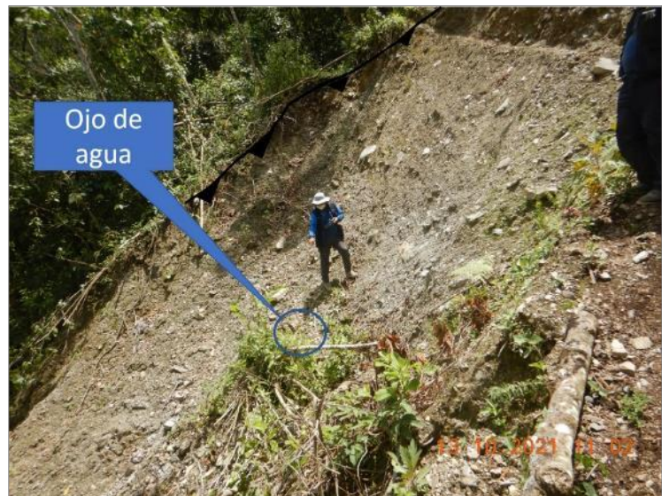
Figuras 15 y 16. Vista del deslizamiento con longitud de 12 m, que afectó el camino peatonal del sector.
