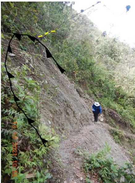
Figuras 15 y 16. Vista del deslizamiento con longitud de 12 m, que afectó el camino peatonal del sector.
