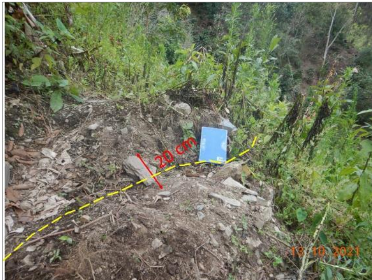
Figura 13. Vista de la grieta con 20 cm de apertura en área de cultivos.
