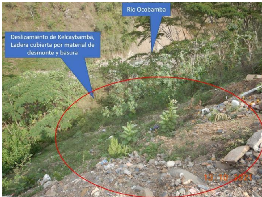
Figura 11. Estado actual del deslizamiento del poblado de Kelcaybamba, cubierto por material de desmonte y basura en coordenadas UTM: 777141 E, 8575804 S.
