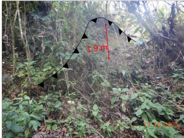
Figura 14. Vista de escarpa de deslizamiento con salto de 1.9 m.
