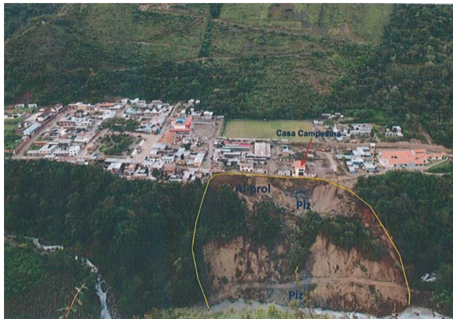
Figura 12. Deslizamiento del poblado de Kelcaybamba en el año 2013, imagen obtenida del Informe técnico N° A6630 Deslizamiento de Ocobamba (Ingemmet, 2013, p. 32).
