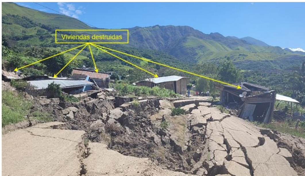
Figura 14. Viviendas totalmente destruidas en el flanco derecho del deslizamiento. Coordenadas UTM WGS84, Norte: 9385531 – Este: 778833
