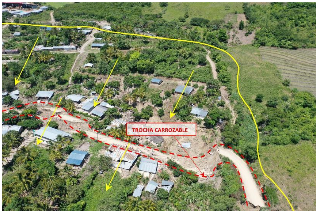
Figura 21. Trocha carrozable afectada (intransitable), flanco derecho.
