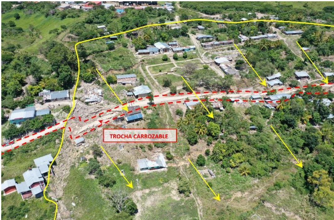
Figura 20. Trocha carrozable afectada (intransitable), flanco derecho.
