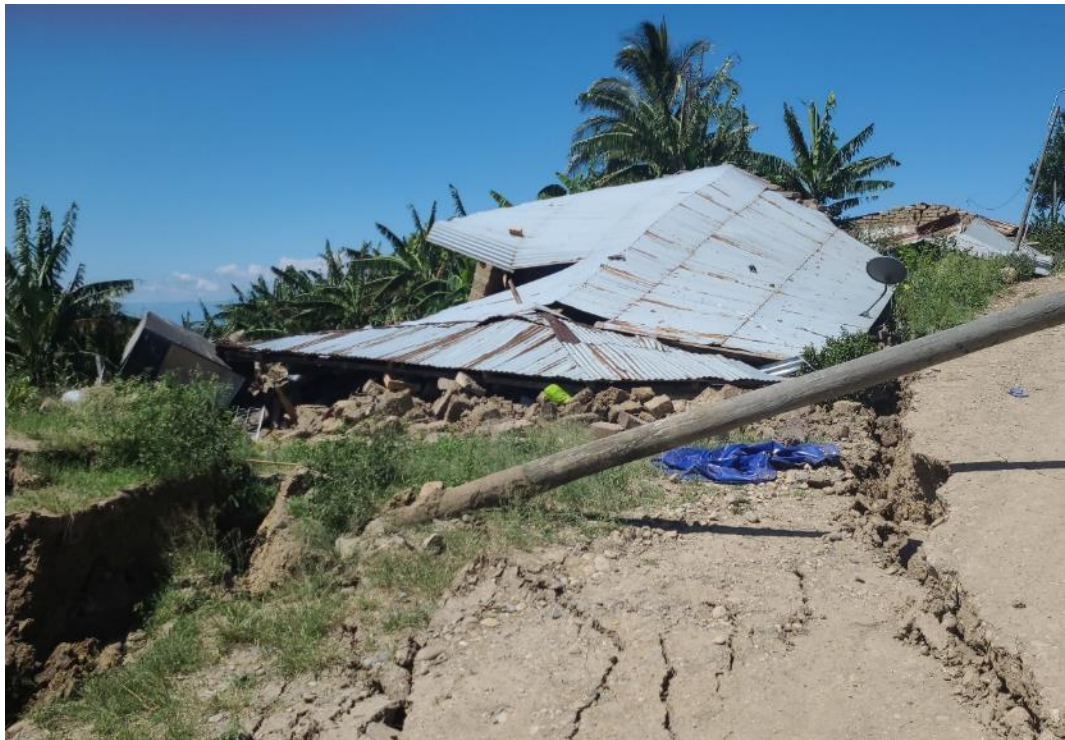
Figura 16. Vivienda totalmente colapsada.
