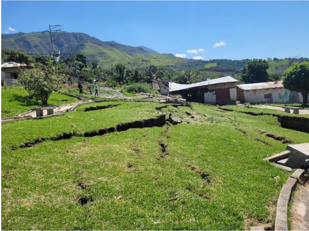
Figura 17. Se observa múltiples escarpes secundarios, y agrietamientos en la plaza principal del centro poblado de San Isidro.
