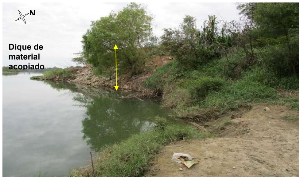
**Foto 10:** Dique construido (marzo 2017) con altura aproximada de 3 metros para evitar la inundación por el aumento del caudal del río Chira como medida de emergencia en el distrito de Querecotillo
