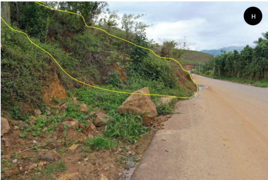
Figura 18. Naturaleza de suelo incompetente, material de remoción antiguo susceptible, pendiente de terreno 25 a 45°.
