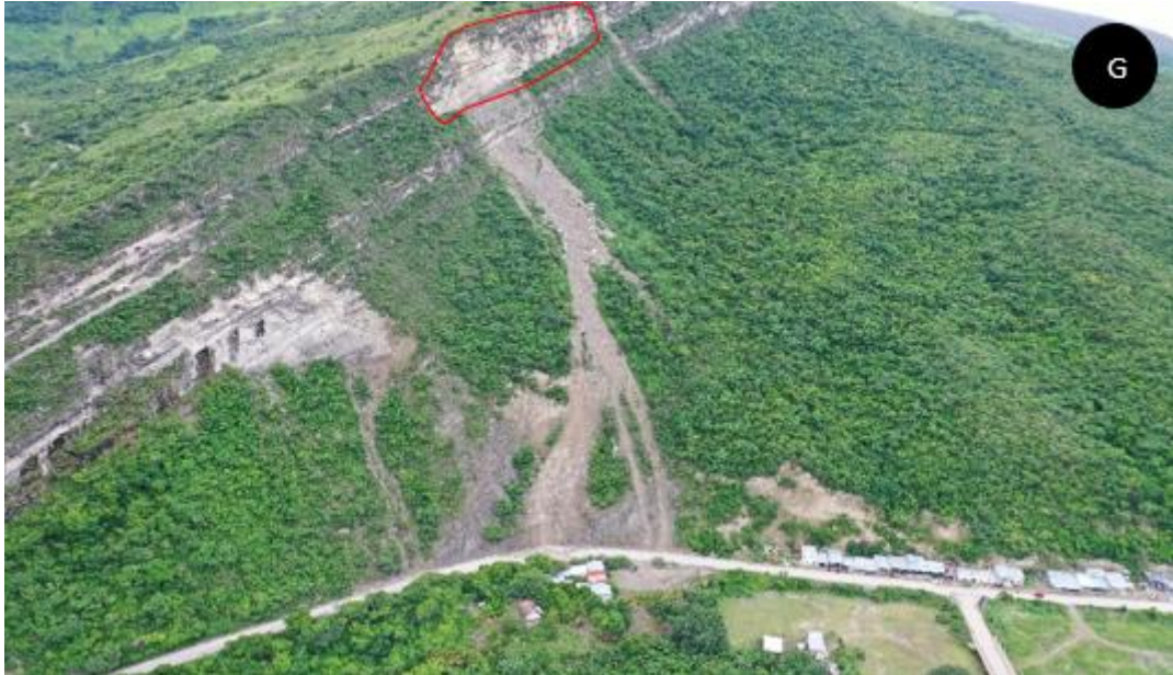
Figura 15. Derrumbe en km 81 de la carretera Jaén a San Ignacio (116031376), alternancia de roca de diferente competencia, Calizas micríticas intercaladas con lutitas grises, pendiente de terreno mayor a 45°, zona de arranque irregular de aproximadamente 50m, altura de arranque de 250m.
