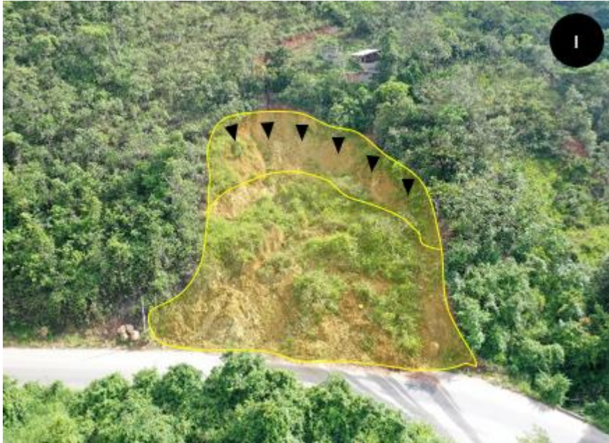
Figura 19. Deslizamiento de falla rotacional de única escarpa en km 118 de carretera San Ignacio a Jaén (116041297), en conglomerado de rocas intrusivas y areniscas con matriz limosa de color amarillo.
