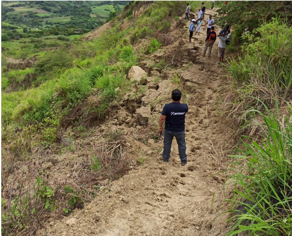
Foto 05. Daños en vías de acceso, caserío Santo Domingo del progreso, distrito Huarango, Provincia de San Ignacio.
