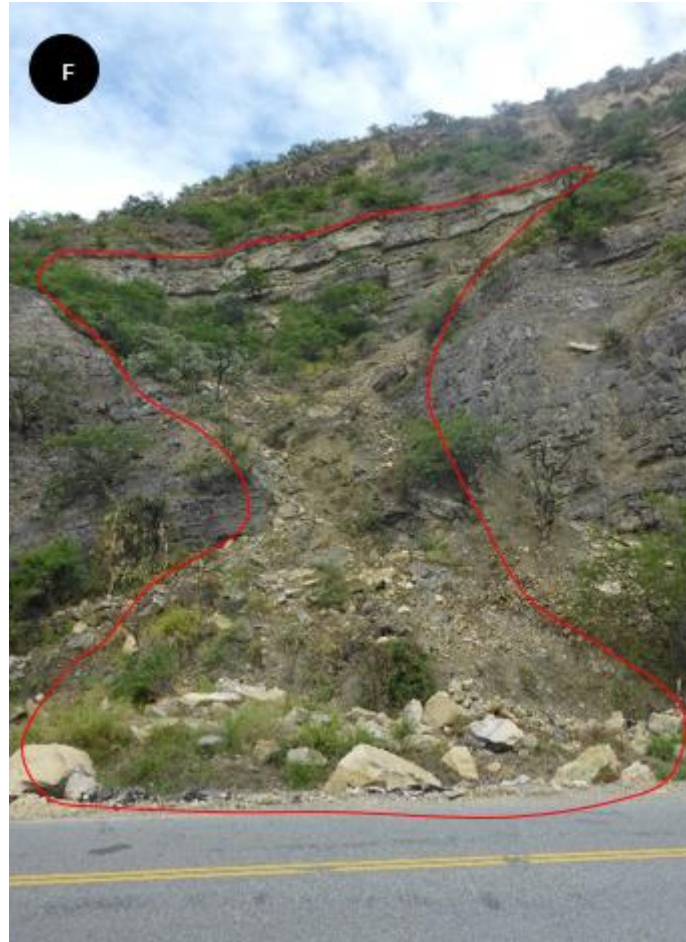
Figura 13. Derrumbe en el km 186 de la carretera Bagua a Chamaya (115921093), talud de corte artificial en alternancia de calizas margosas del Grupo Quilquiñan cubiertas por material aluvial. Obstrucción de 30m de vía.
