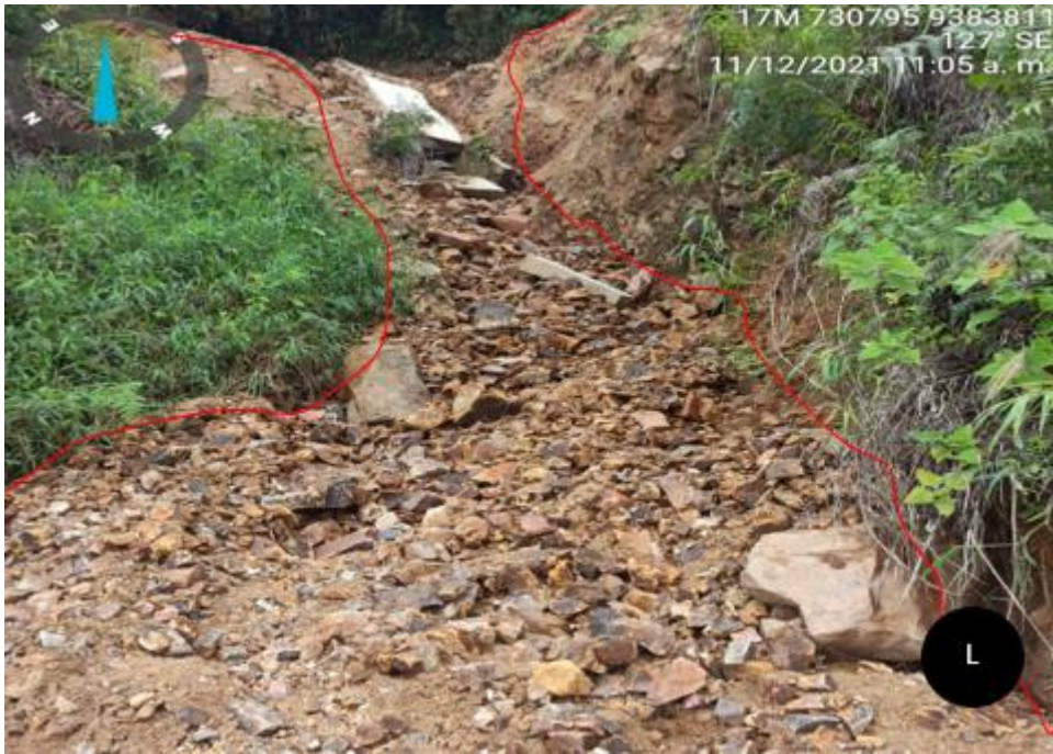
Figura 25. L. Derrumbe en Caserío San Francisco Distrito de Huabal (115941065), Sustrato de mala calidad, tonalitas y granodioritas muy meteorizadas cubiertas de material de remoción antiguo, obstrucción de vía en km 3 de camino rural San Francisco a San Antonio de Chigamal.
