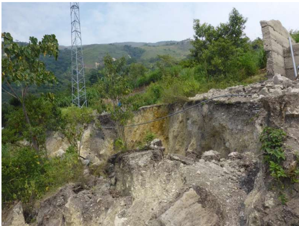
Fotografía 42. Escarpa de deslizamiento en San Martín.
