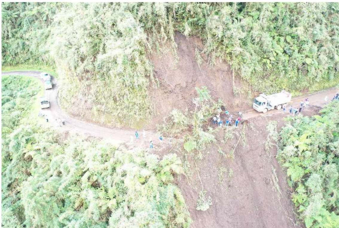
Fotografía 24. Derrumbe entre las quebradas Tarasca - Chonia, frente a sector Vista Hermosa.
