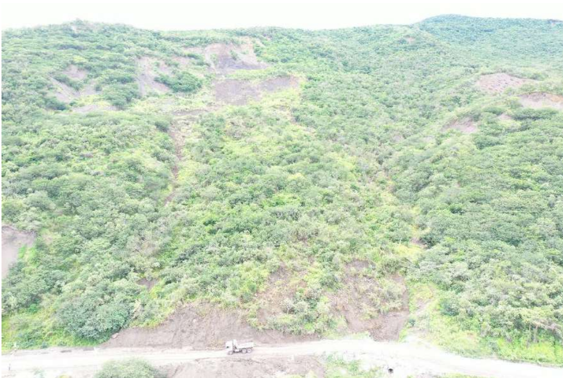
Fotografía 32.Deslizamiento reactivado, ubicado entre Puerto Panamá y Arenal, km 250 de carretera Fernando Belaúnde Terry .
