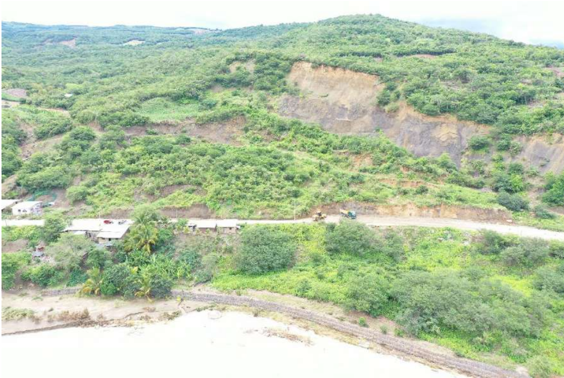
Fotografía 31.Deslizamiento reactivado ubicado en el sureste de Puerto Naranjitos, carretera Fernando Belaúnde Terry.
