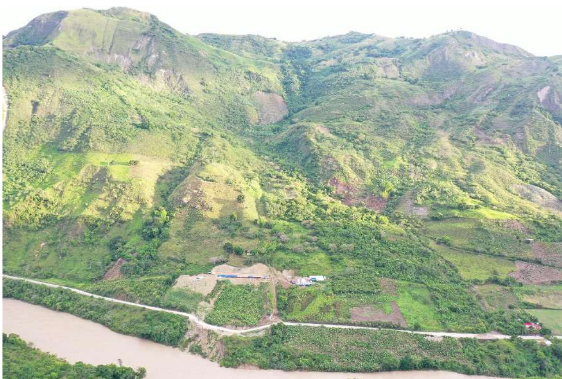
Fotografía 4. Vista panorámica de la ladera de montaña donde ocurre el deslizamiento en proceso de formación, ubicado en la margen derecha del río Marañón, aguas arriba de La Libertad. Se observa afectación en la carretera.
