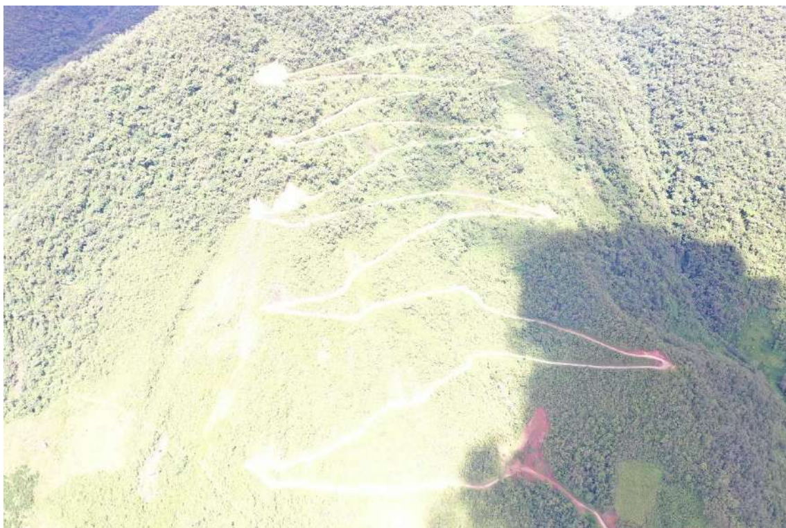
Fotografía 23. Zona de derrumbes discontinuos que afecta carretera ubicado al sureste de Congón, entre quebradas Tarasca – Chonia .
