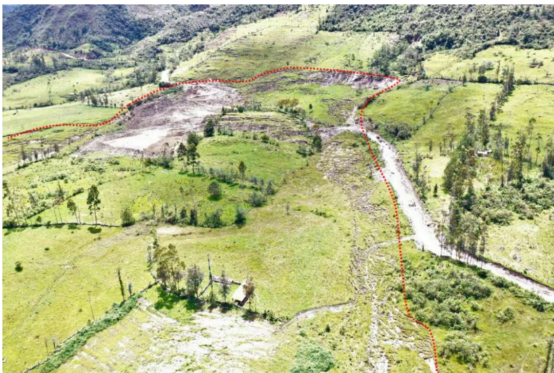
Figura 14. Escarpa principal del deslizamiento Fuente: Imagen tomada con drone Mavic 2 Pro.
