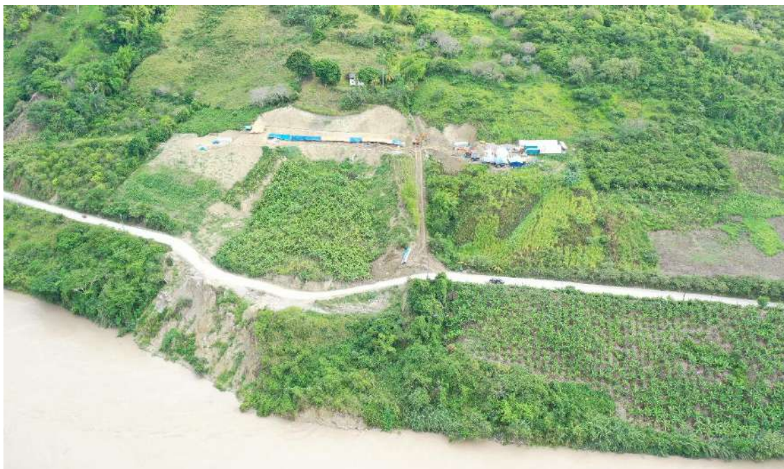
Fotografía 3. Deslizamiento en proceso de formación en la margen derecha del río Marañón, aguas arriba de La Libertad. Se observa afectación en la carretera y el oleoducto que cruza por la cabecera del deslizamiento.
