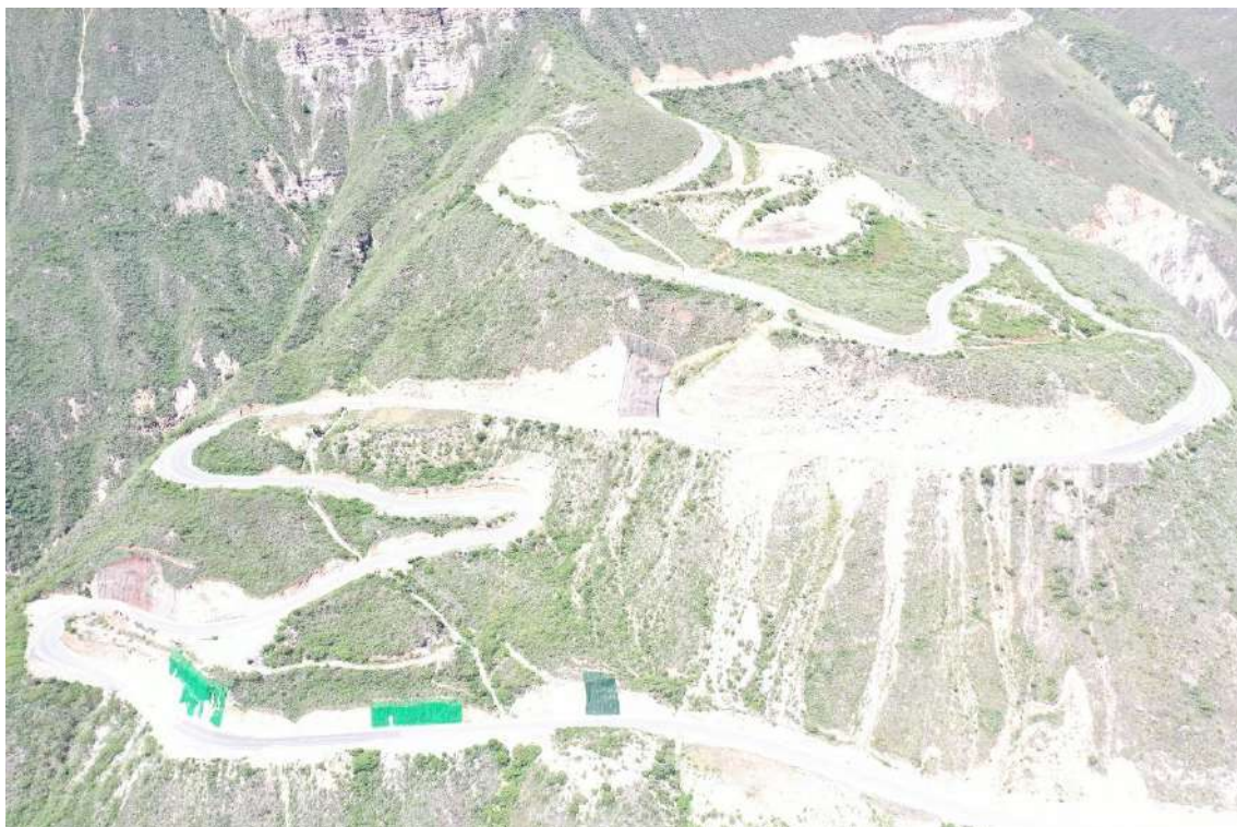
Fotografía 20. Zona de caída de rocas en el sector de Caclic, carretera Chachapoyas – Luya.
