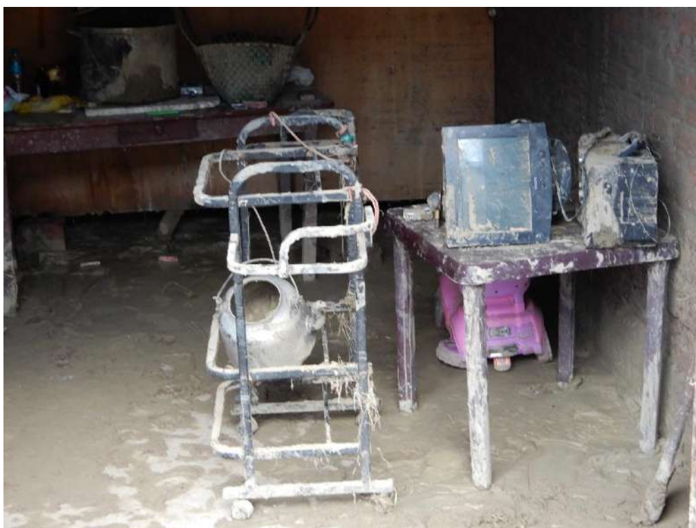
Fotografía 30. Detalle de Pertenencias y electrodomésticos perdidos por la inundación.
