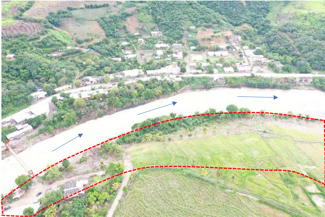
Figura 18. En el Puerto El Huingo (El Salao), margen derecha del río Utcubamba se observa las viviendas y tierras de cultivo que fueron afectados por la inundación fluvial. También, se observa viviendas susceptibles a ser afectadas por la erosión fluvial.
