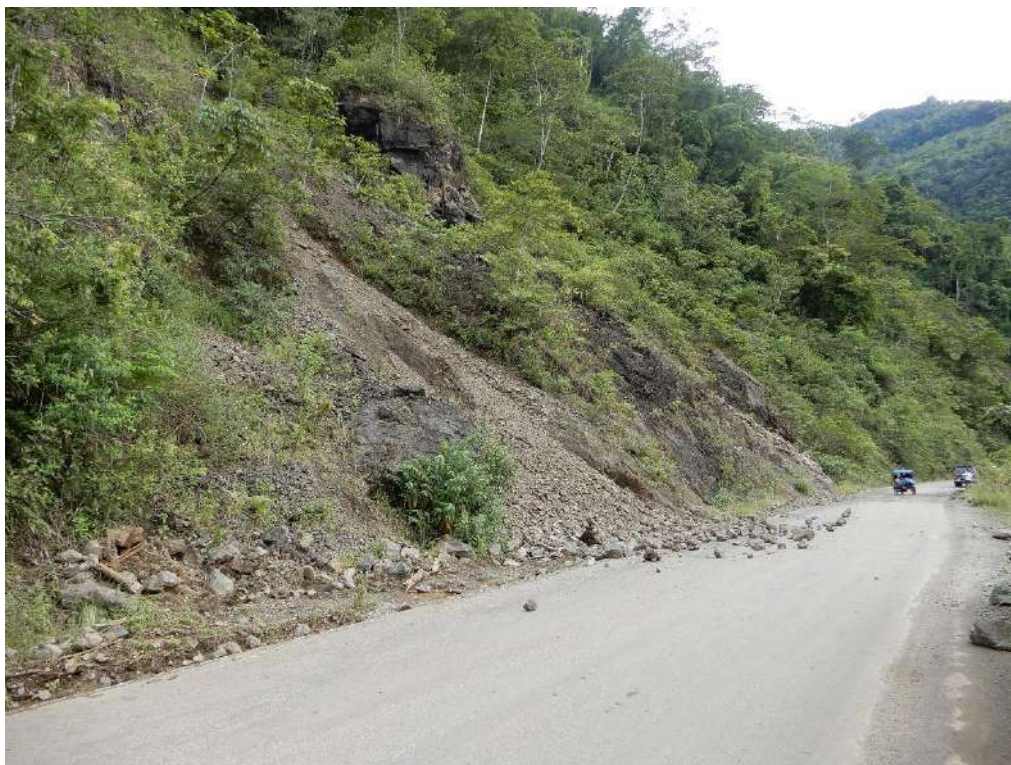
Fotografía 1. Caída de rocas en la margen derecha del río Marañón, aguas arriba de Tutumberos, carretera Bagua – Santa María de Nieva.
