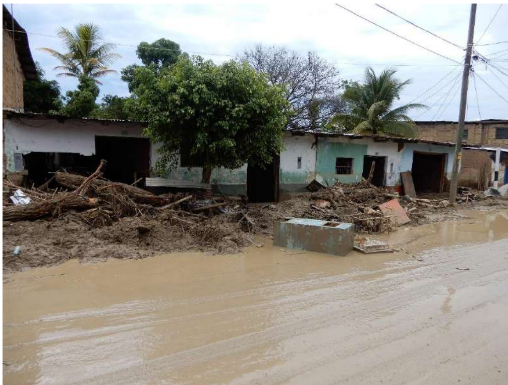
Fotografía 29. Calle inundada y colmatada por desborde del río Utcubamba en el sector de Puerto Naranjitos, margen izquierda..
