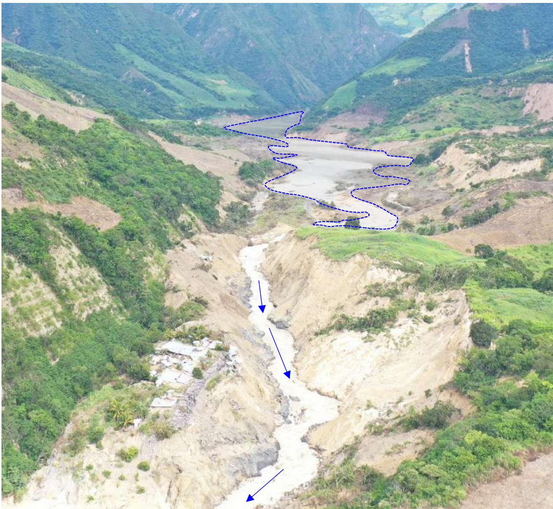
Figura 24. Vista panorámica del embalse y desembalse de río Utcubamba en Aserradero, tomada el 04 de diciembre. Vista aguas arriba.
