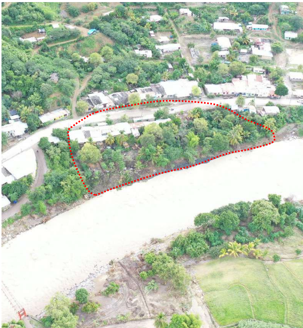
Figura 19. Deslizamiento en proceso de activación en Aserradero.
