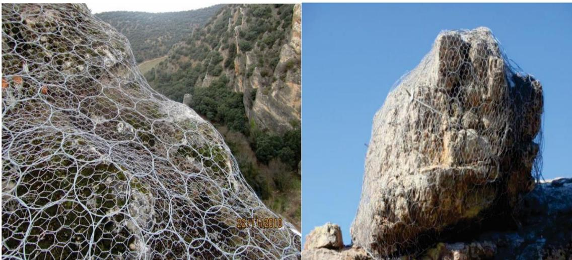
**Figura 4.** Ejemplos de estabilización con red de anillos
