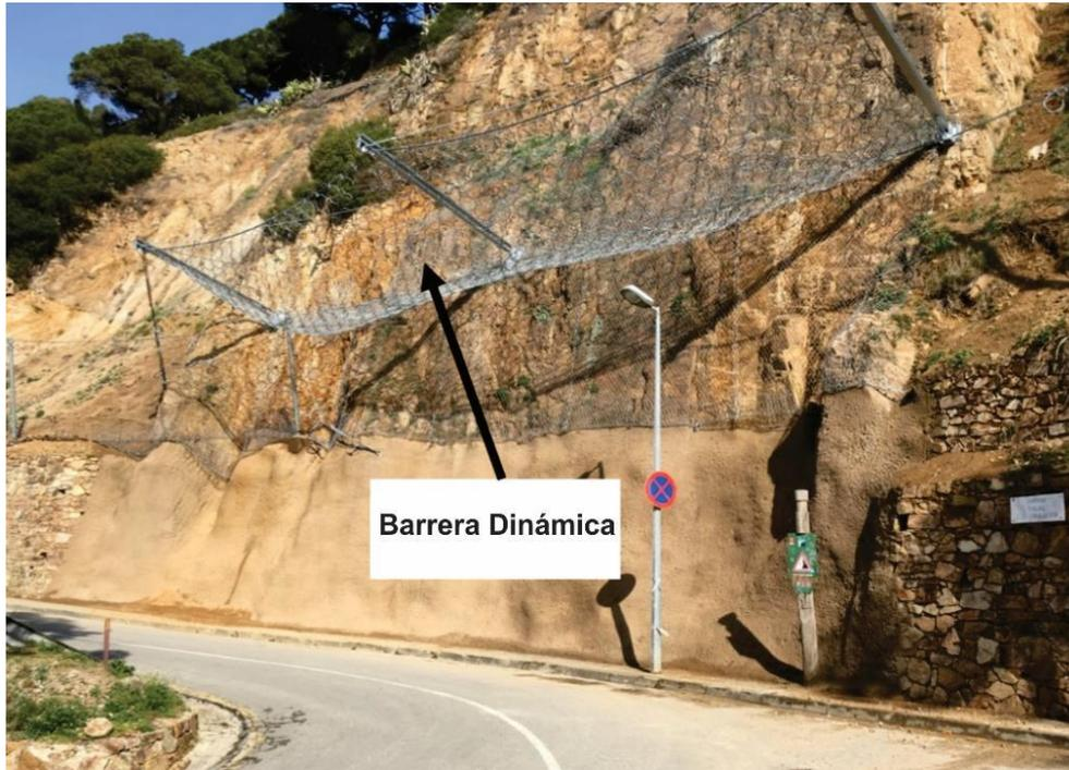
**Figura 3.** Ejemplo de barrera dinámica.
