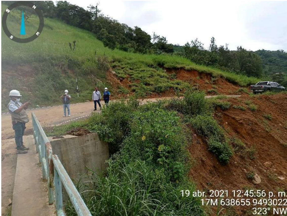
Figura 15: Reptación de suelos en la ladera ubicada hacia el margen izquierdo de la quebrada Linderos
