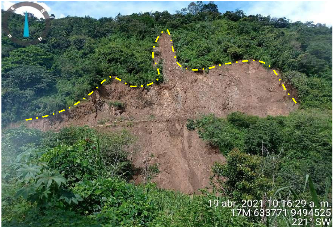
Figura 7: Deslizamiento en las inmediaciones de la quebrada Las Vegas
