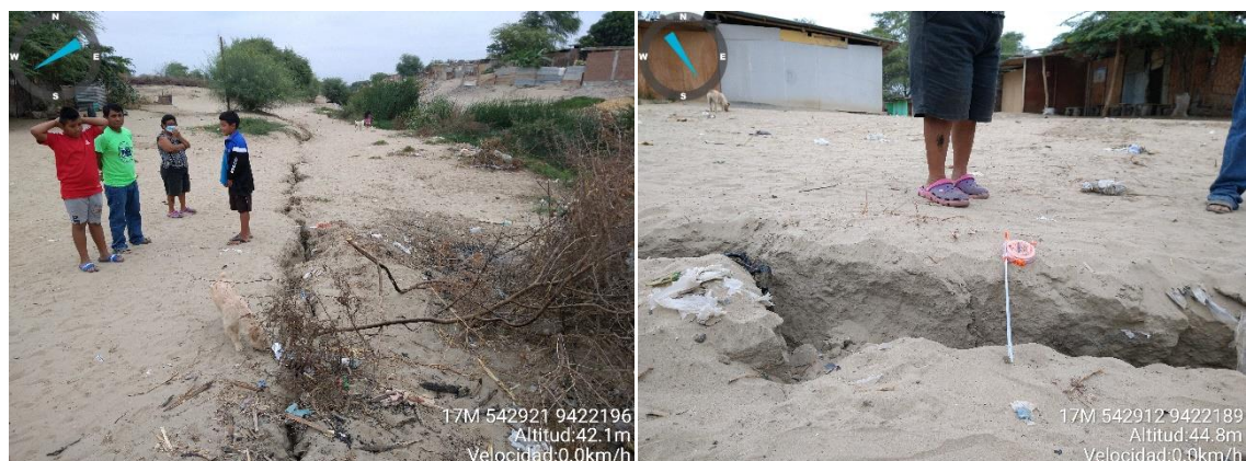
Figura 21: Agrietamiento en el suelo de 122 m de longitud en zona contigua a falla geológica F1 (Figura 20)
