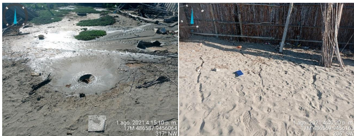
Figura 25: Licuación de suelos en C.P. La Bocana, acompañado con agrietamientos de suelo dentro de algunas viviendas
