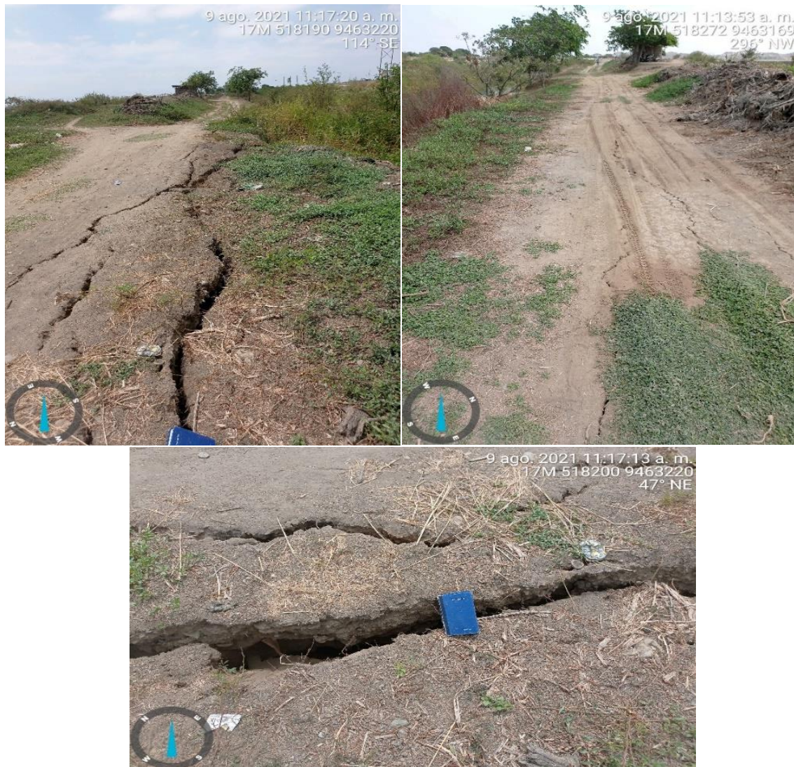
Figura 10.- Agrietamientos en el suelo ubicados en las cercanías del epicentro del sismo de Sullana, presentan 127 m de longitud con dirección noreste- suroeste
